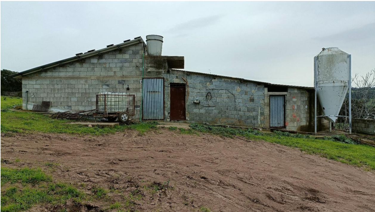
Foto n. 1 – vista prospetto principale edificio
