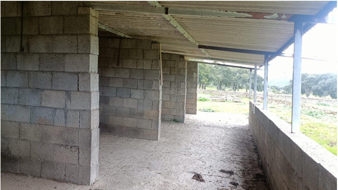
Foto n. 11 – vista interna, tettoia
