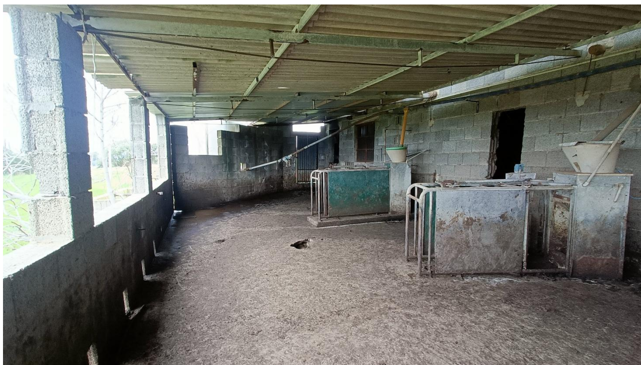
Foto n. 10 – vista interna, tettoia
