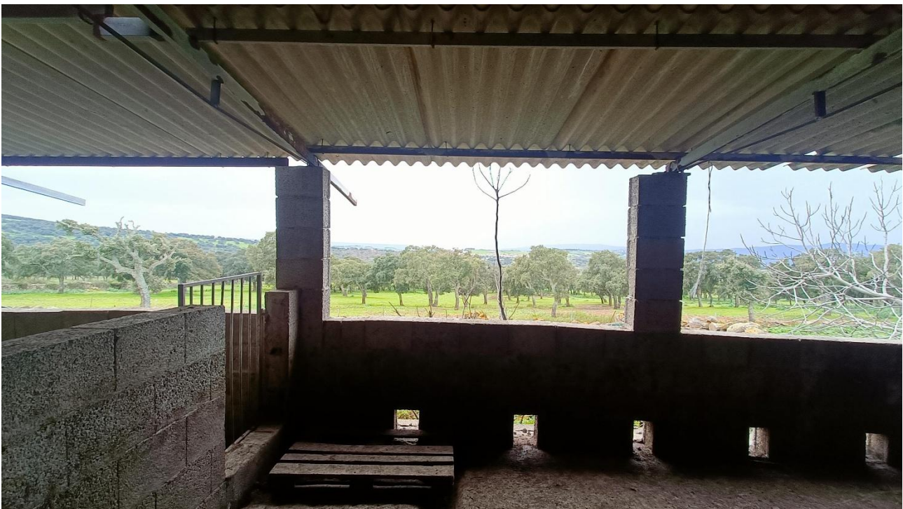
Foto n. 12 – vista interna, tettoia
