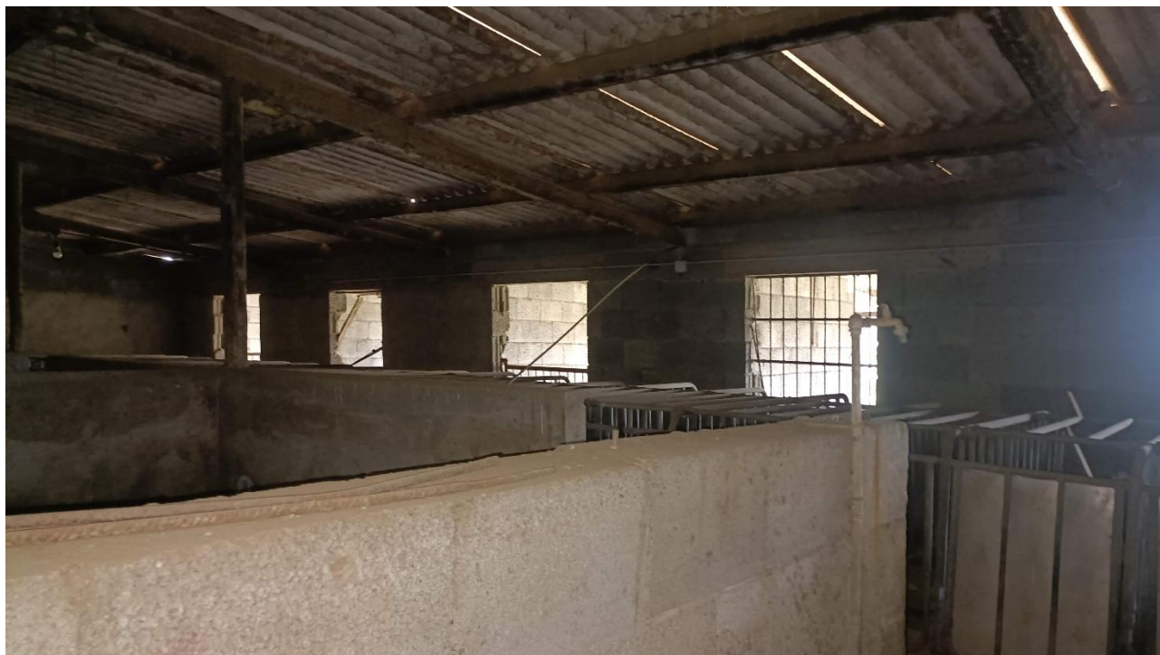
Foto n. 9 – vista interna, box
