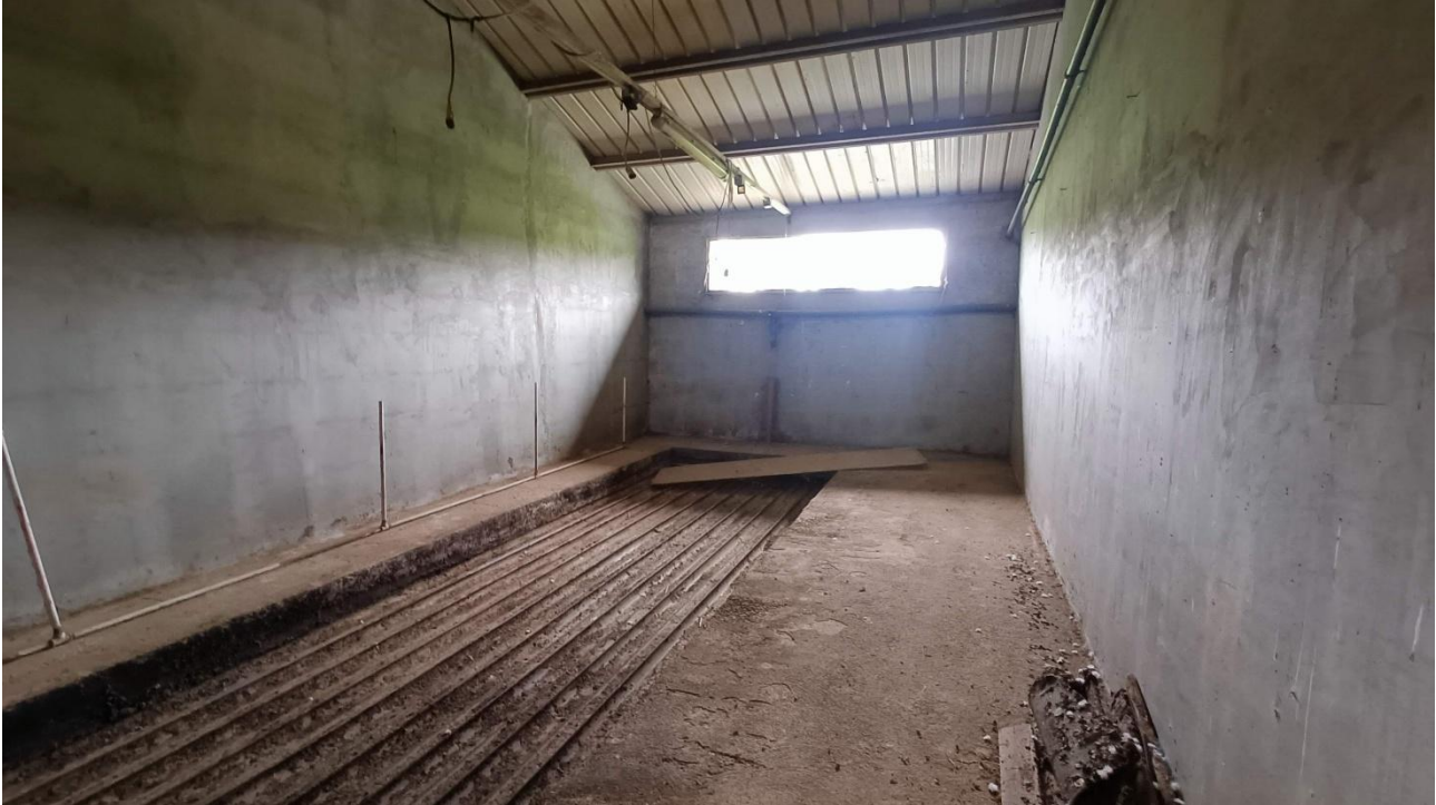
Foto n. 8 – vista interna, box
