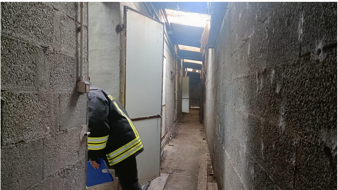
Foto n. 6 – vista interna, corridoio
