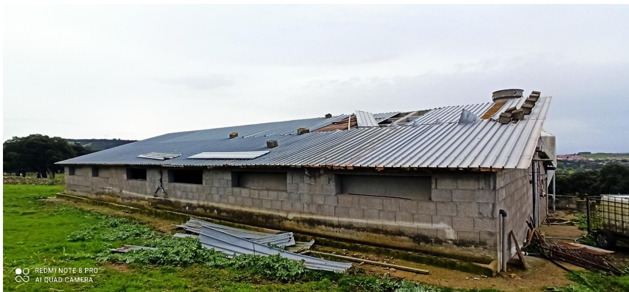
Foto n. 3 – vista prospetto laterale
