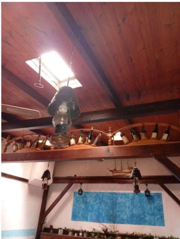
15 - Copertura inclinata in legno della prima sala
