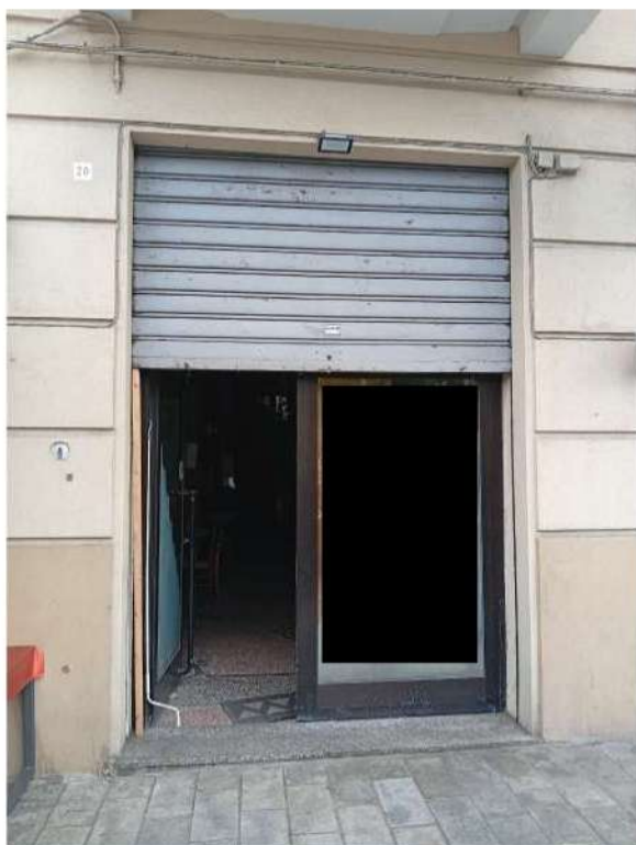
01 - Ingresso civ. 20R di Corso Mazzini
