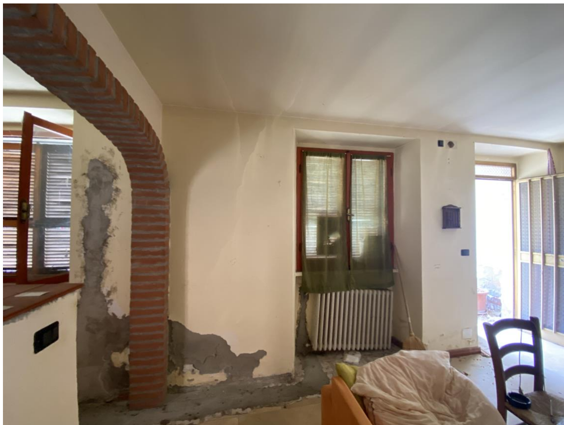
Foto 05: soggiorno e ingresso, particolare delle parti non finite.
