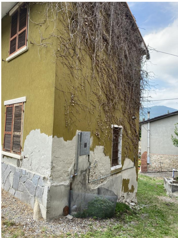
Foto 02: lato sull'area cortilizia mappale 57
