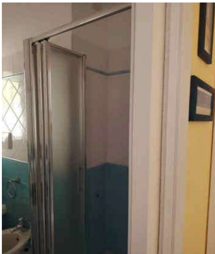
Foto 25 – Bagno – dettaglio doccia
