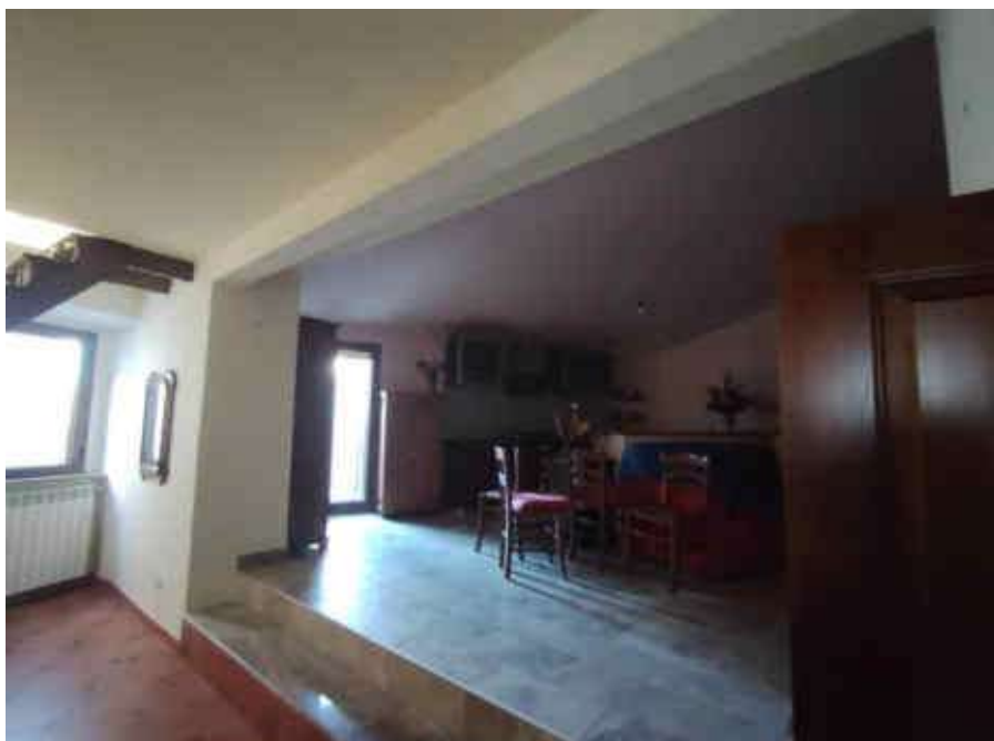
Foto n° 10 – Vista cucina soggiorno varco da chiudere
