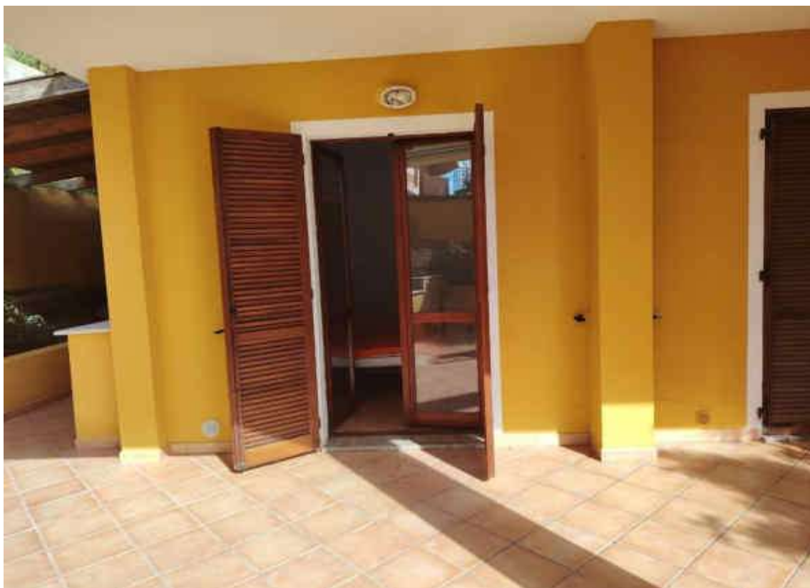
Foto n° 7 – Accesso porta finestra camera da letto
