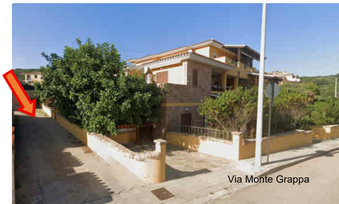
Foto n° 1 – Accesso all'immobile dalla strada
