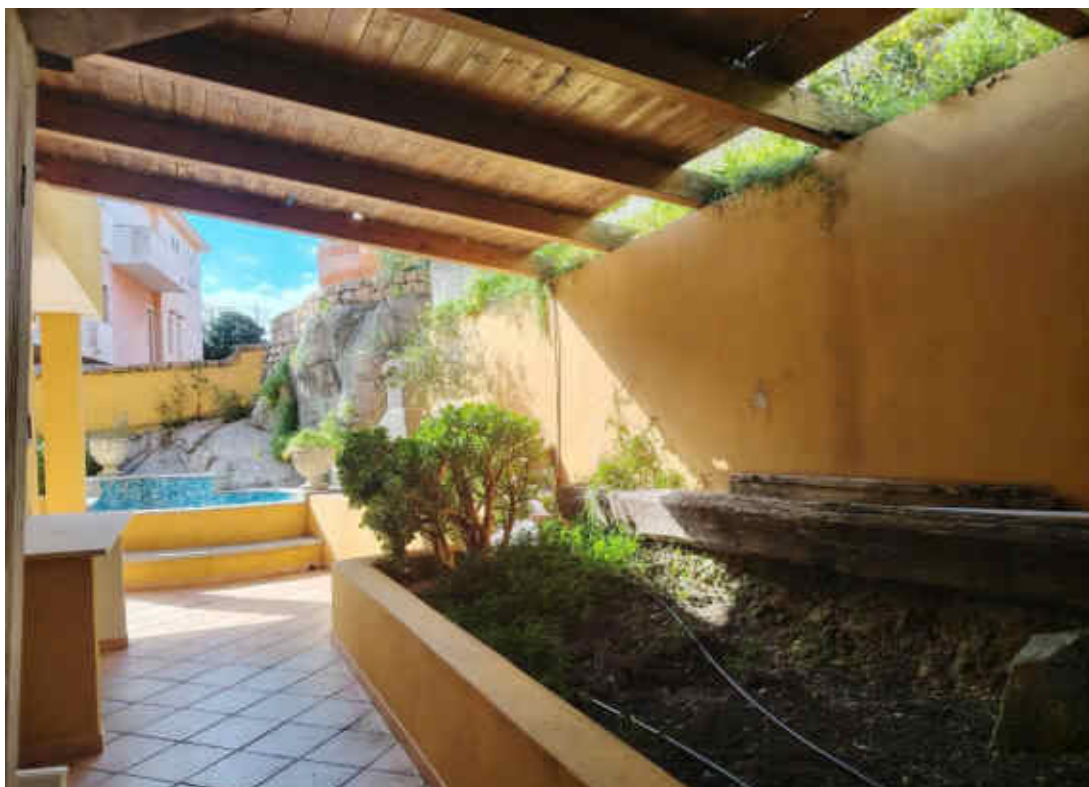
Foto 9 – Veranda coperta lato camera e bagno
