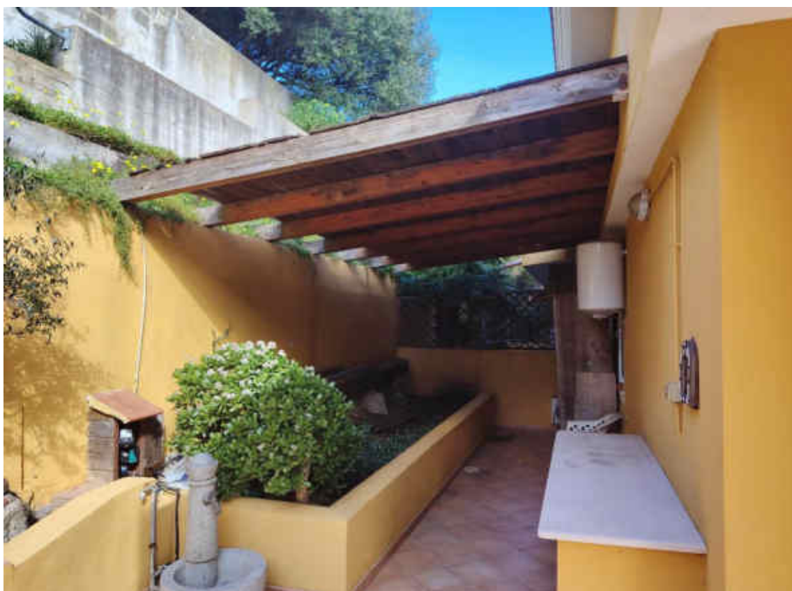
Foto 8 – Veranda coperta lato sx ingresso
