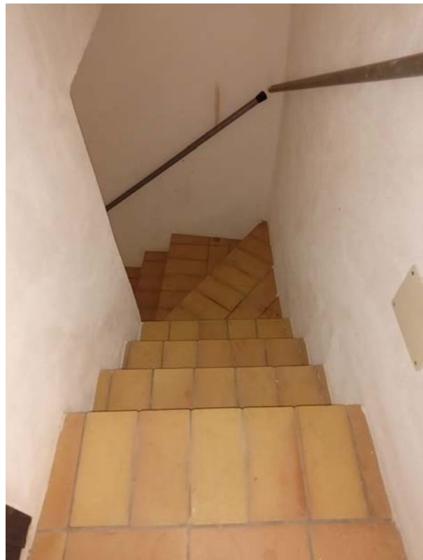
VISTA SCALA D'ACCESSO
