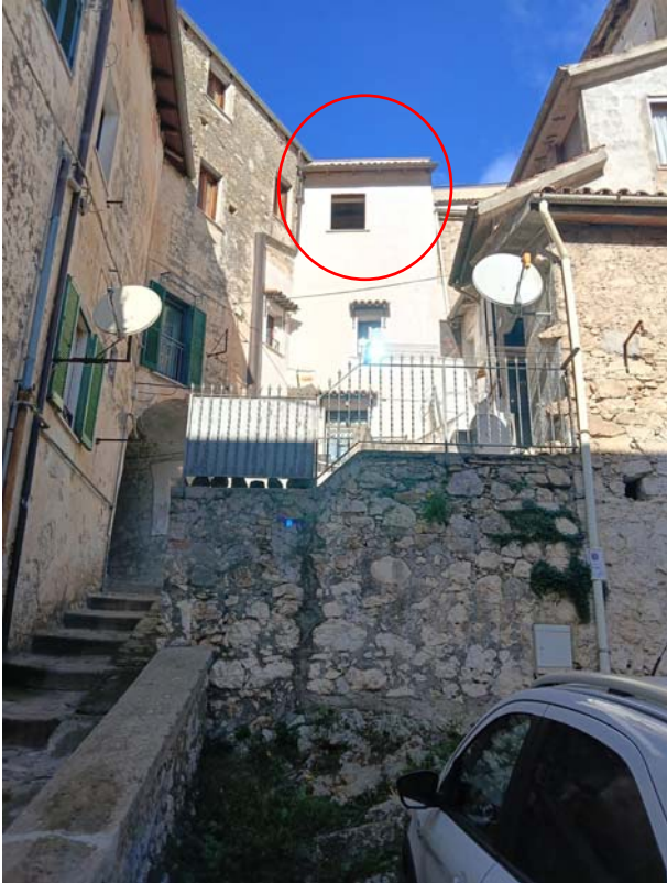
VISTA DA VIA VICO USO CAMERA E TERRAZZO
