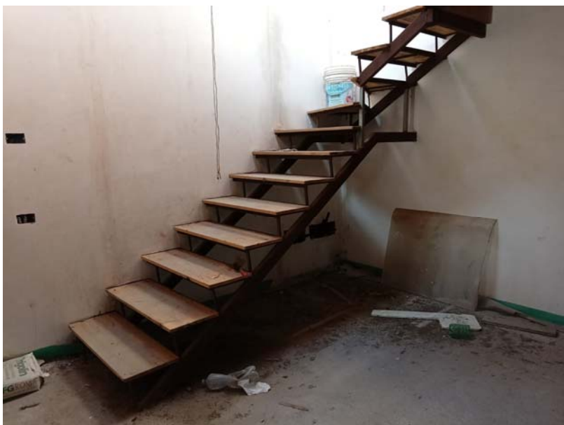
VISTA SCALA IN LEGNO ACCESSO SOPPALCO
