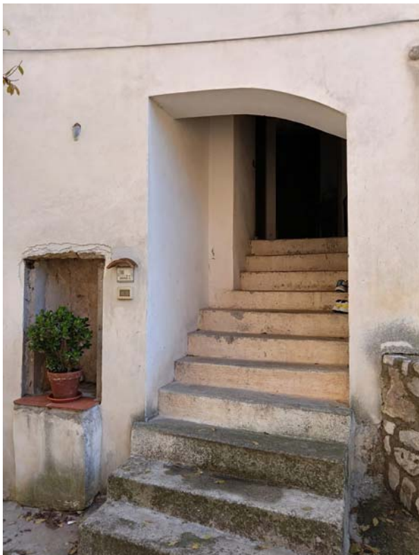
VISTA INGRESSO DA VIA VICO USO N.3
