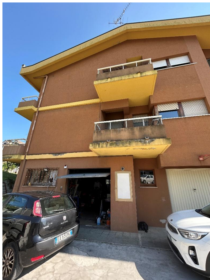
FOTO 2 – PARTICOLARE INGRESSO AL GARAGE (sub 8)
