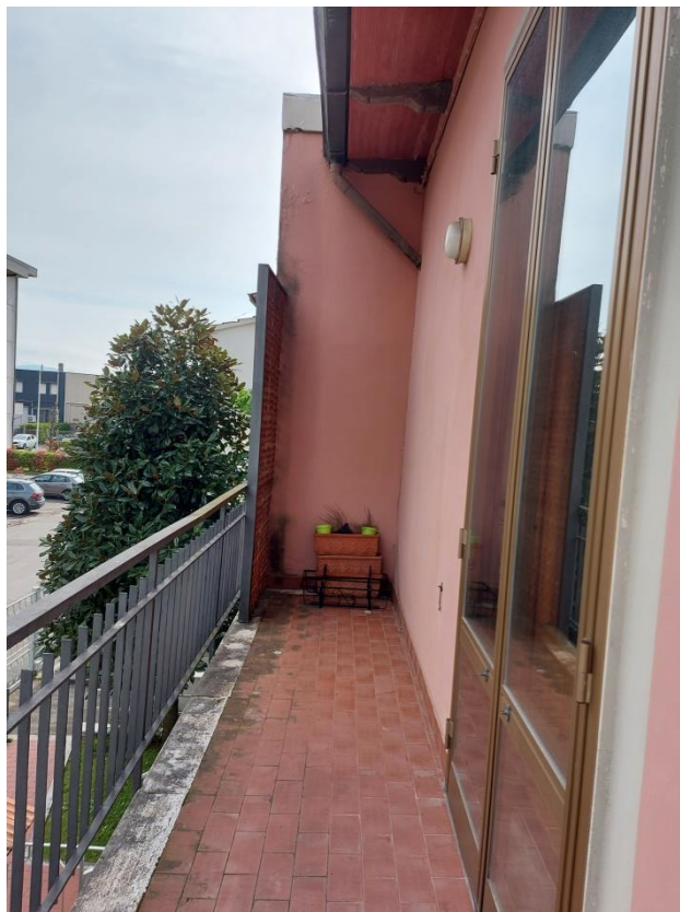
Foto 70: Balcone frontale – Accesso al soggiorno
