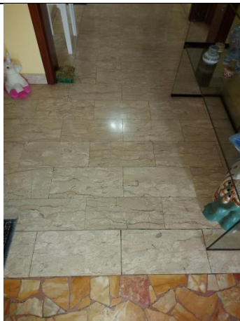
Corridoio ingresso P1°
