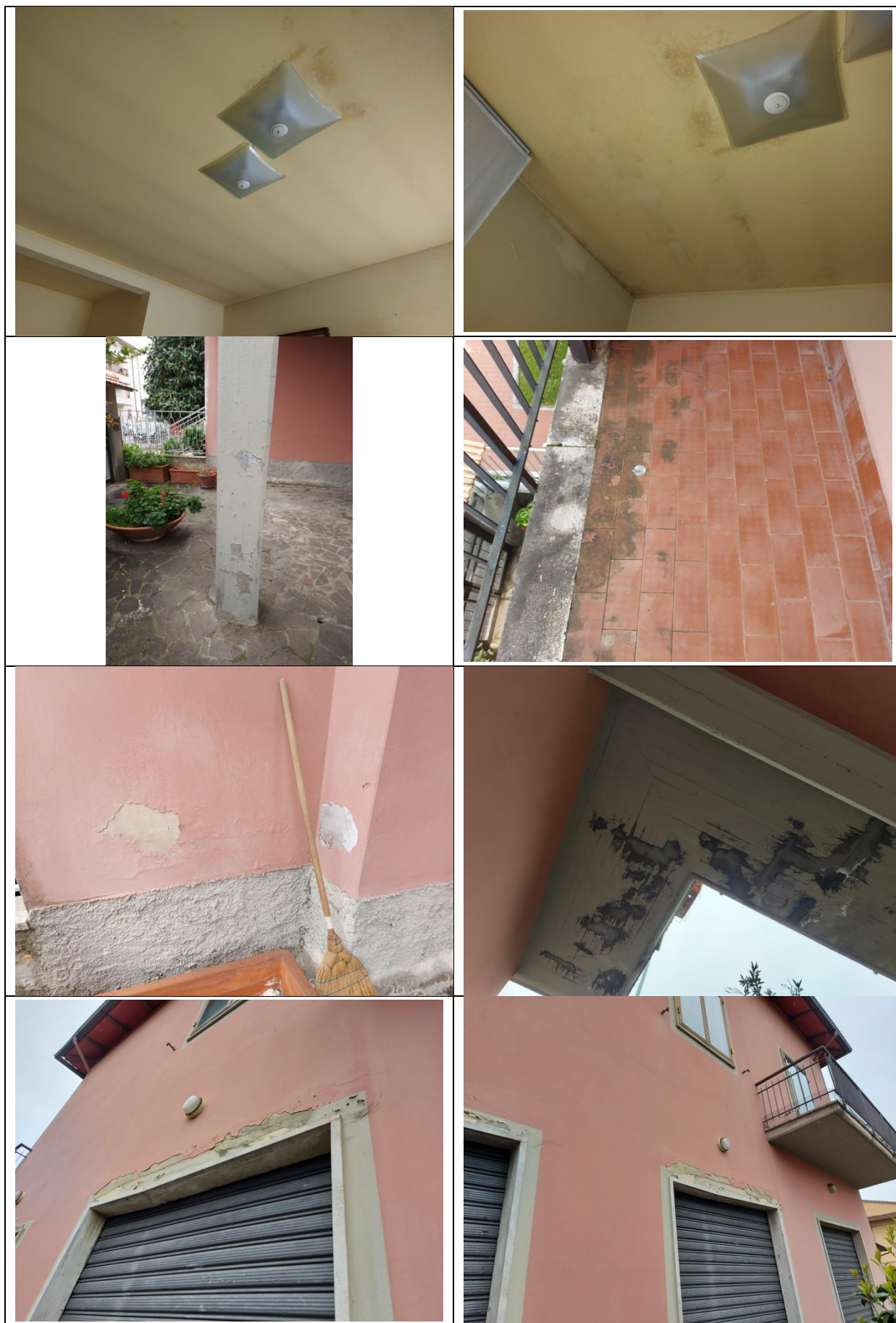
Foto 114: Stato di conservazione
