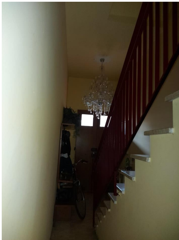
Foto 28: Vano scale di piano terra – corridoio di accesso al sottoscala
