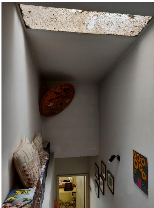
Foto 81: Vano scale di accesso alla soffitta di P2°
