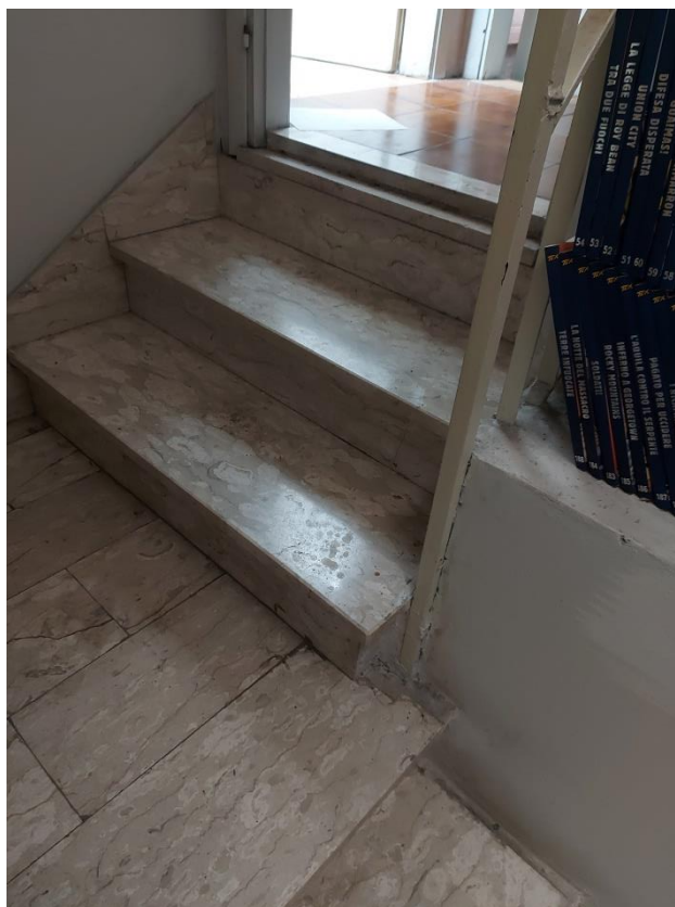
Foto 82: Vano scale di accesso alla soffitta di P2°
