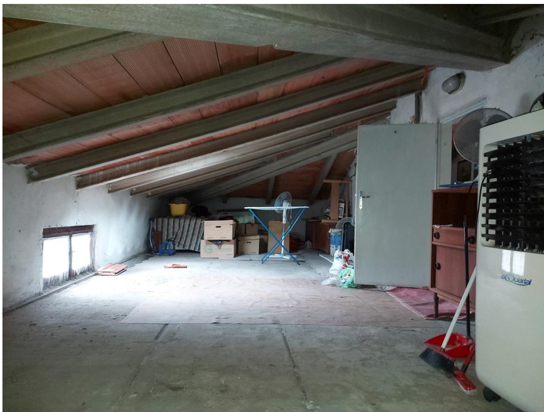
Foto 98: Piano secondo – Soffitta 1
