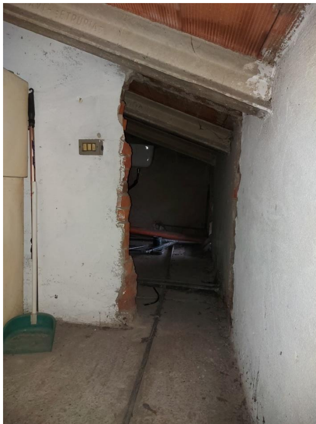
Foto 100: Piano secondo – Soffitta 1 – Accesso soffitta 3
