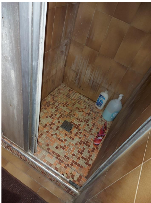
Foto 92: Piano secondo – Bagno
