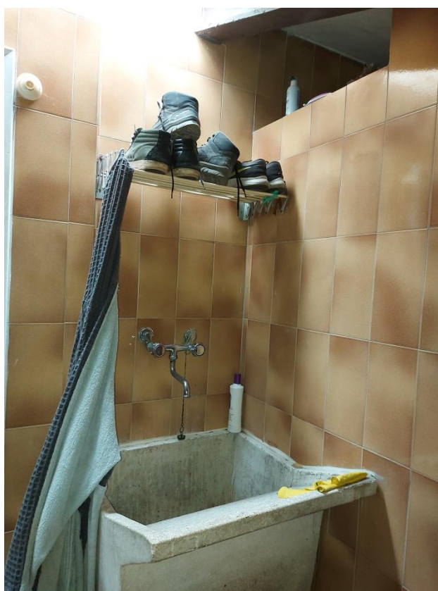
Foto 93: Piano secondo – Bagno
