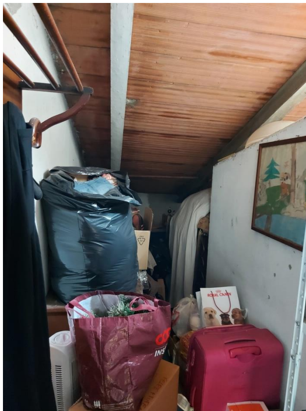
Foto 86: Piano secondo – Soffitta 2
