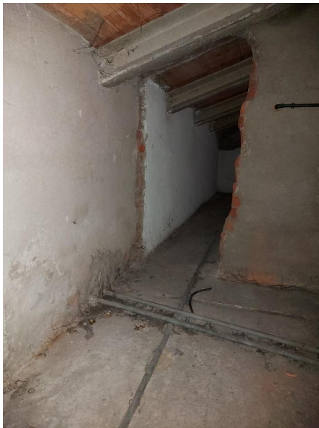
Foto 102: Piano secondo – Soffitta 3 – accesso soffitta 1
