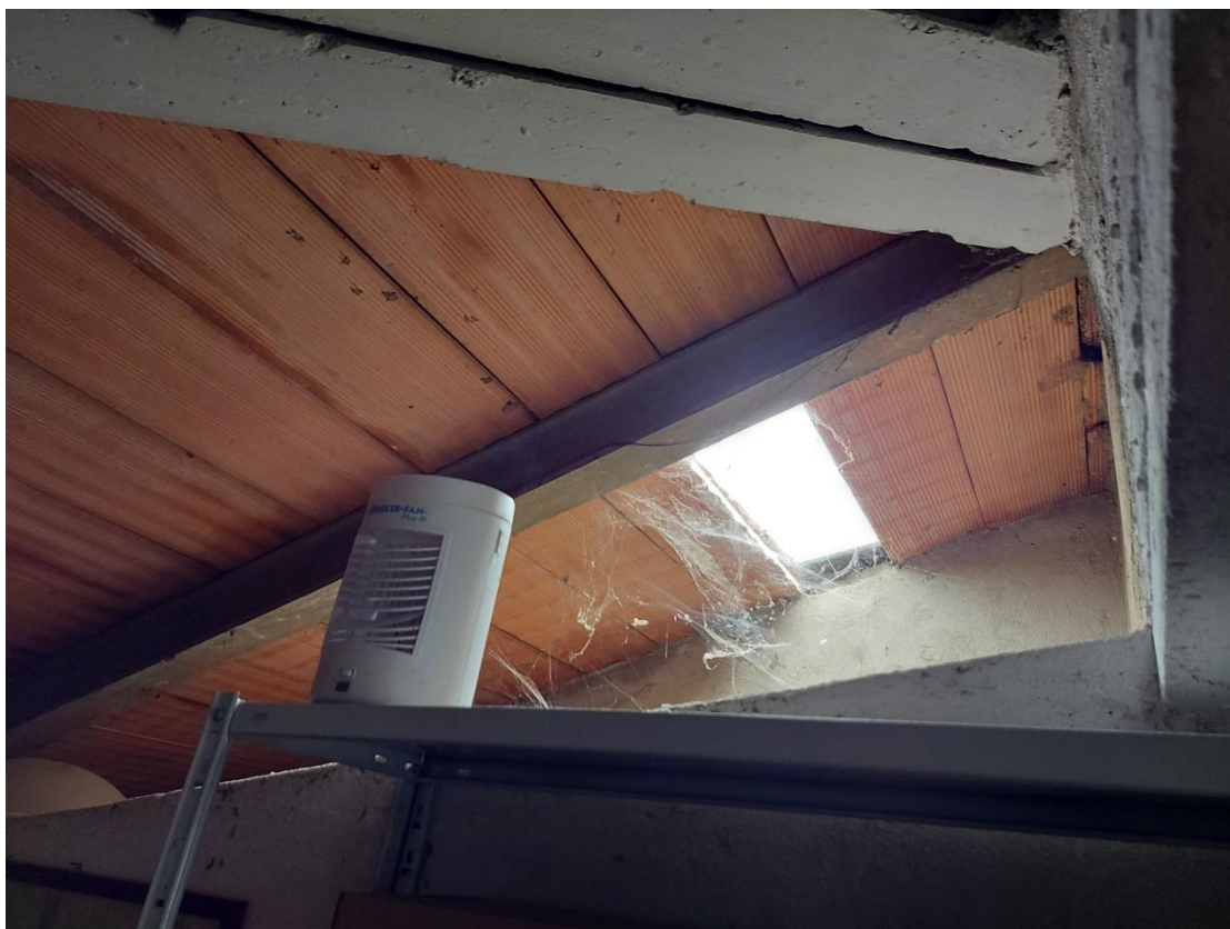
Foto 88: Piano secondo – Soffitta 2
