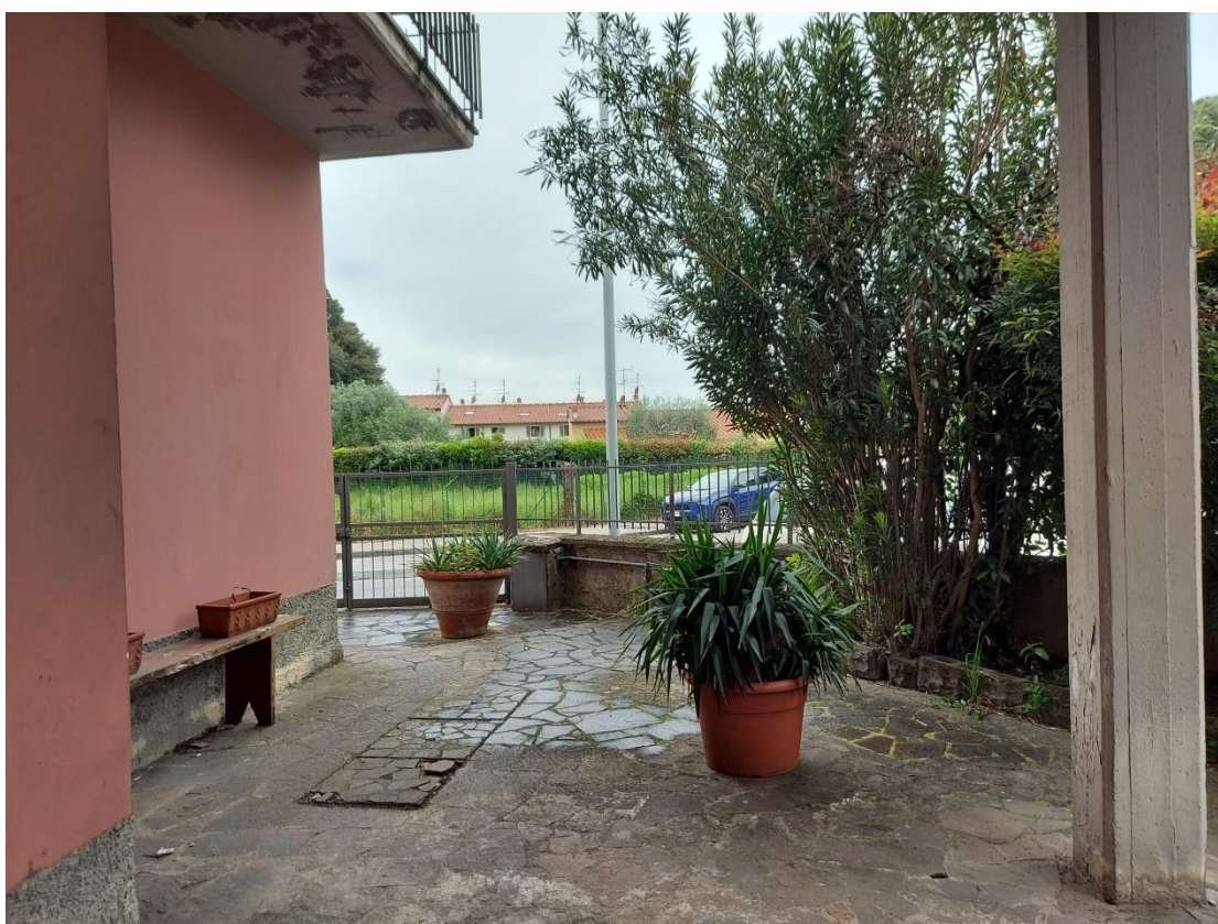
Foto 13: Resede frontale – Sotto loggia
