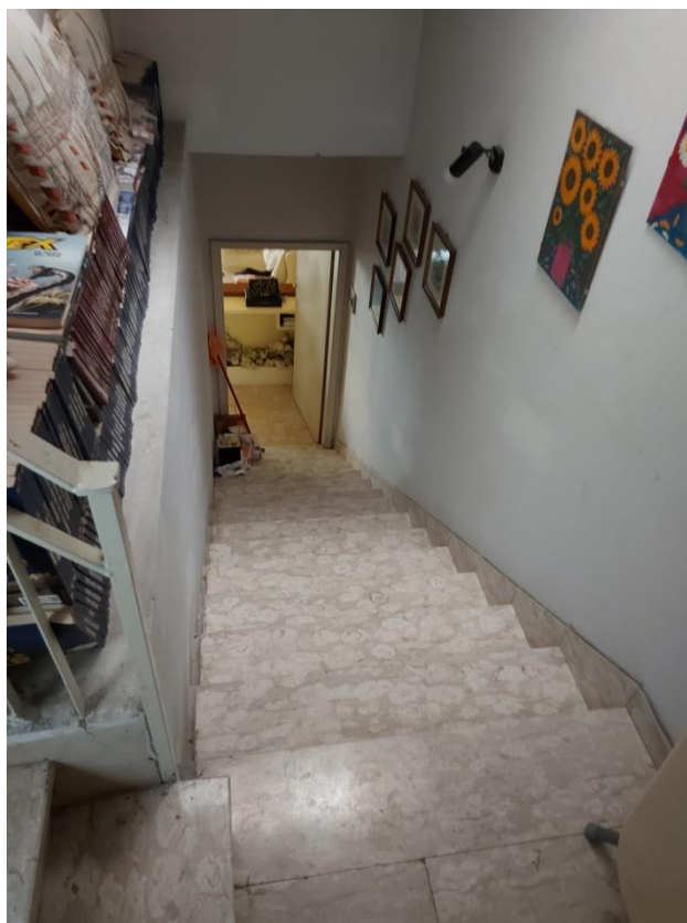
Foto 80: Vano scale di accesso alla soffitta di P2°
