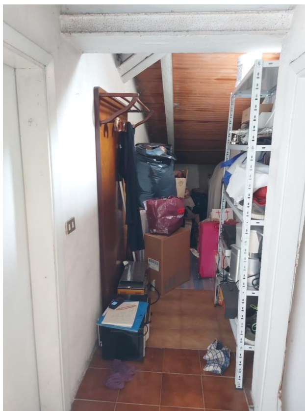
Foto 85: Piano secondo – Soffitta 2
