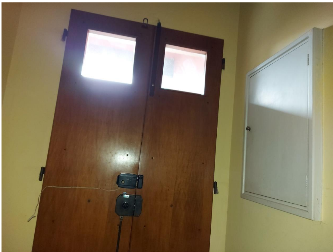
Foto 26: Vano scale di piano terra – ingresso e contatori
