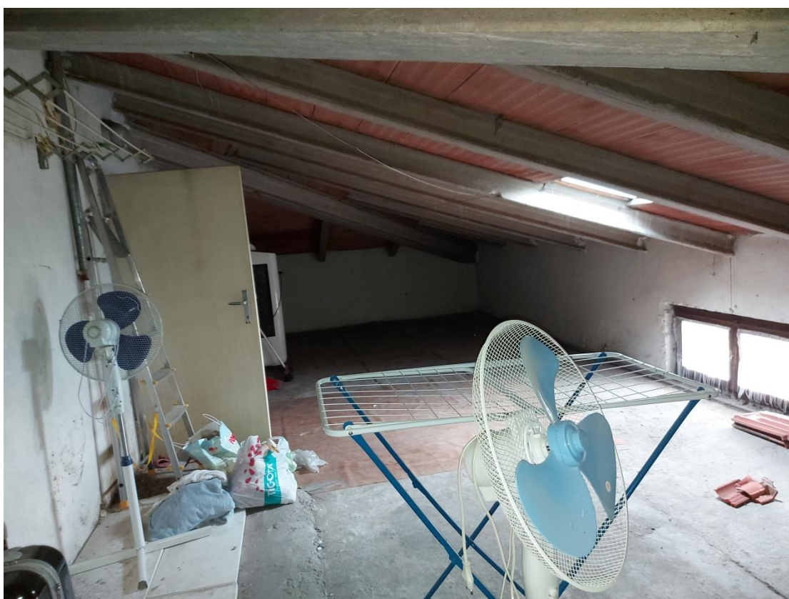
Foto 99: Piano secondo – Soffitta 1
