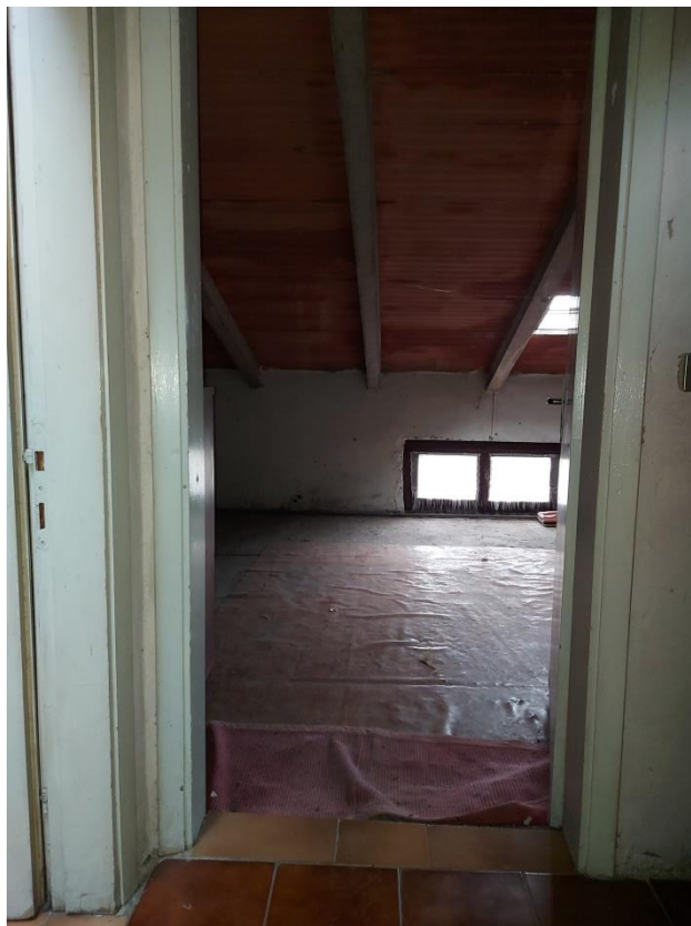
Foto 96: Piano secondo – Disimpegno – Accesso alla soffitta 1
