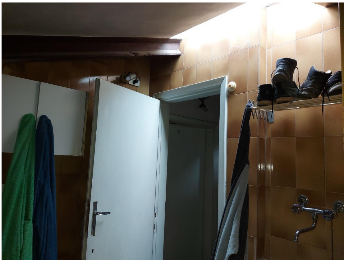
Foto 94: Piano secondo – Bagno
