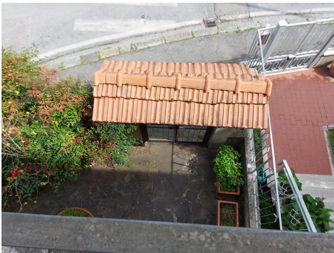
Foto 71: Balcone frontale – Affaccio su ingresso pedonale su Via delle Magnolie
