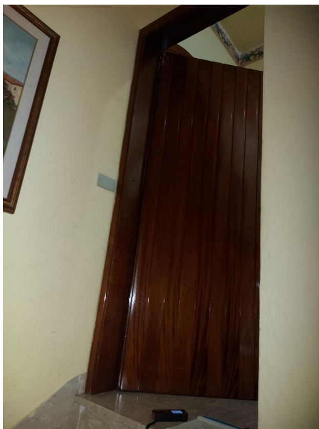
Foto 35: Vano scale di piano primo – accesso all'abitazione
