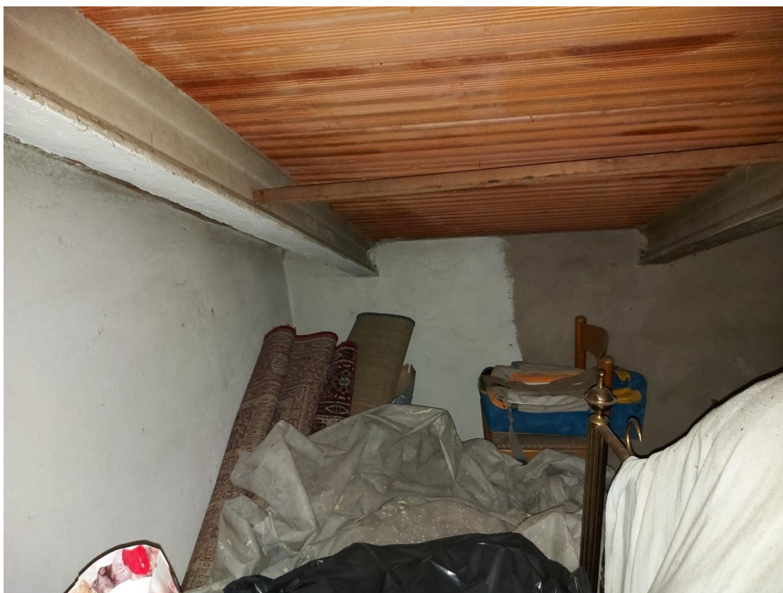
Foto 87: Piano secondo – Soffitta 2
