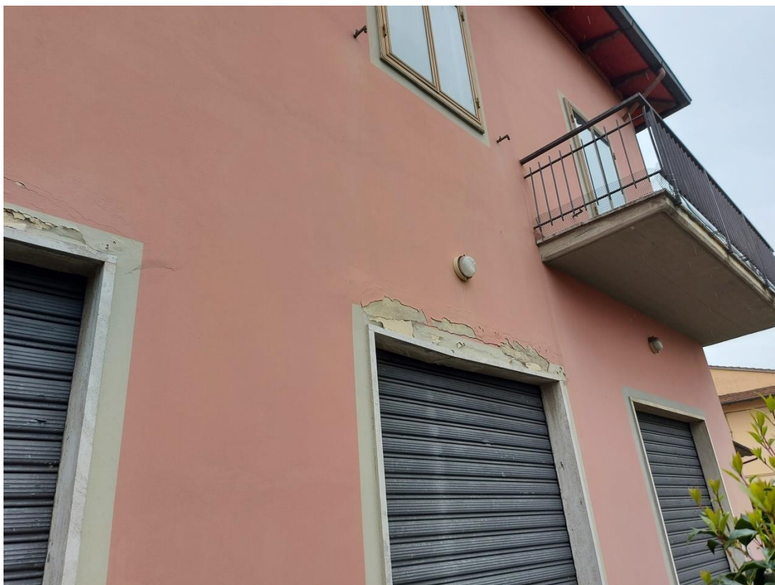
Foto 52: Camera 1 matrimoniale – Balcone laterale
