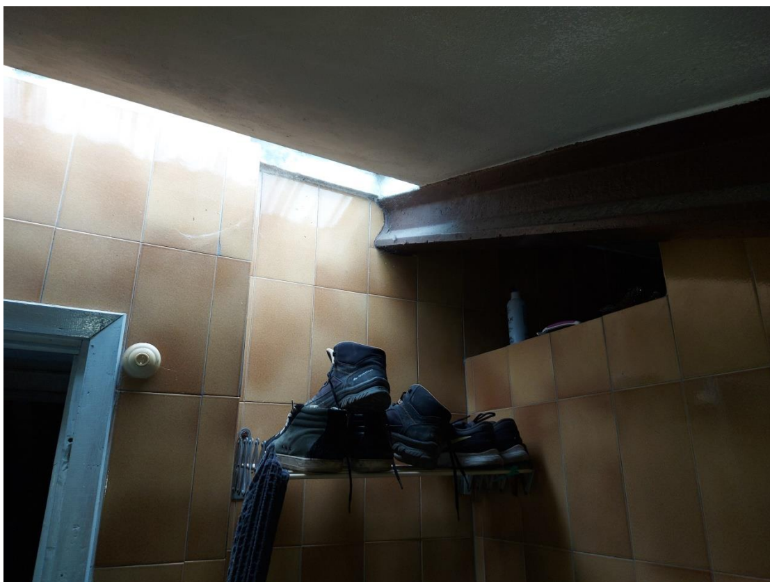
Foto 95: Piano secondo – Bagno
