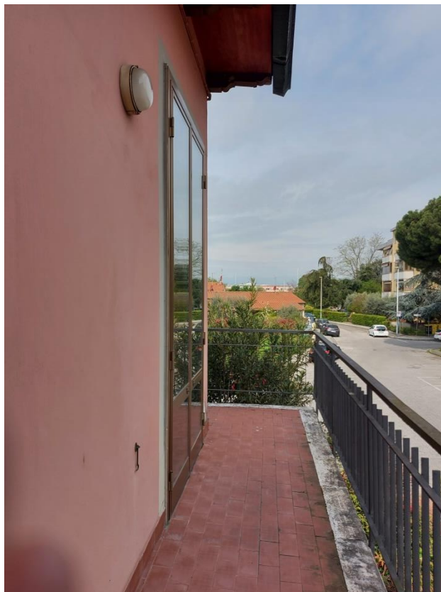
Foto 72: Balcone frontale – Accesso al soggiorno
