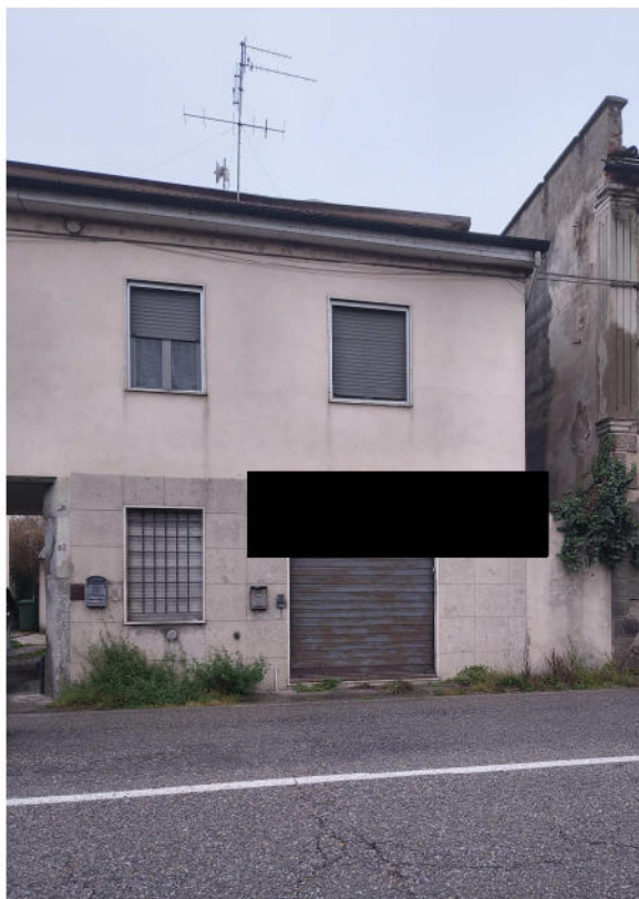
Prospetto principale del negozio
