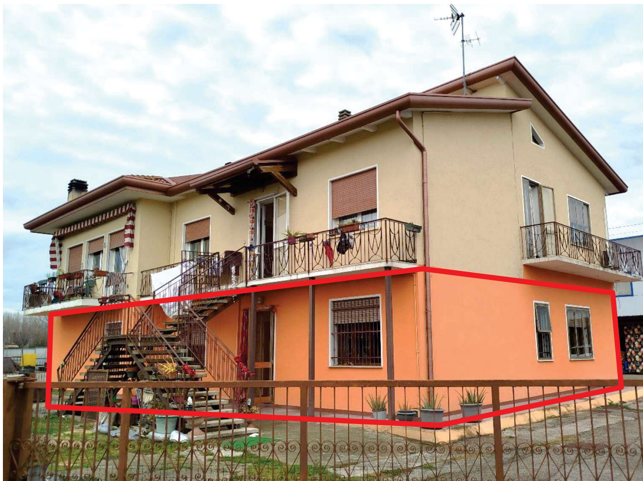
Veduta esterna del complesso bifamiliare
