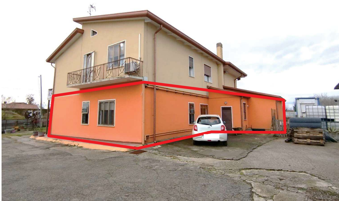
Veduta esterna del complesso bifamiliare
