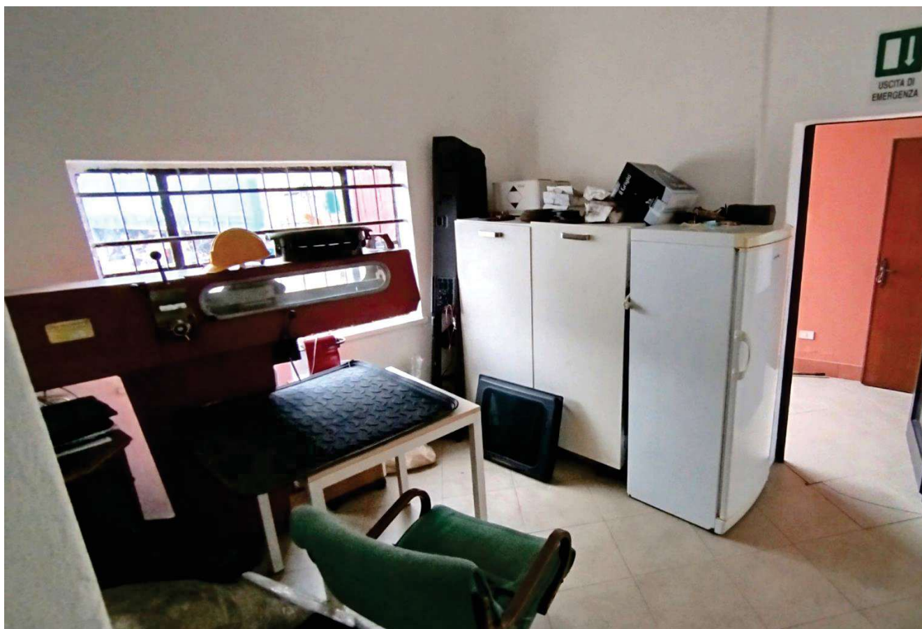
Ufficio - Porzione da demolire
