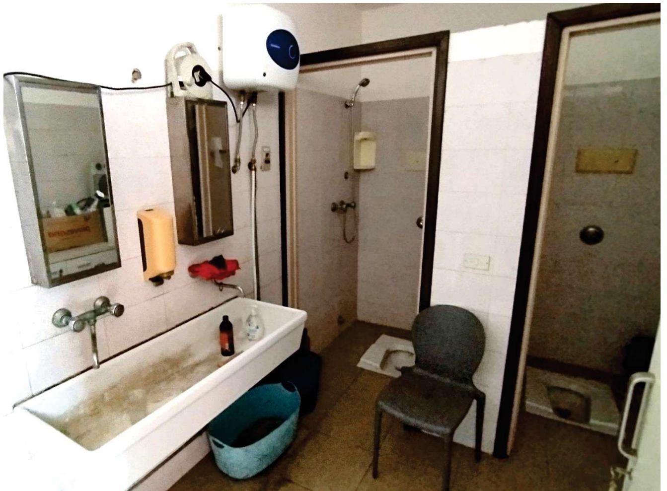
Bagno - Porzione da demolire
