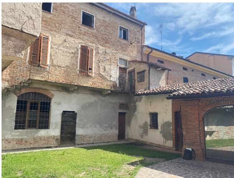
Foto 5 - Prospetto dal cortile interno (non di proprietà)
