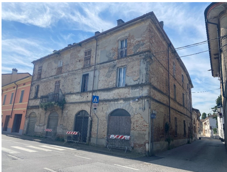
Foto 3 - Prospetto via Roma
