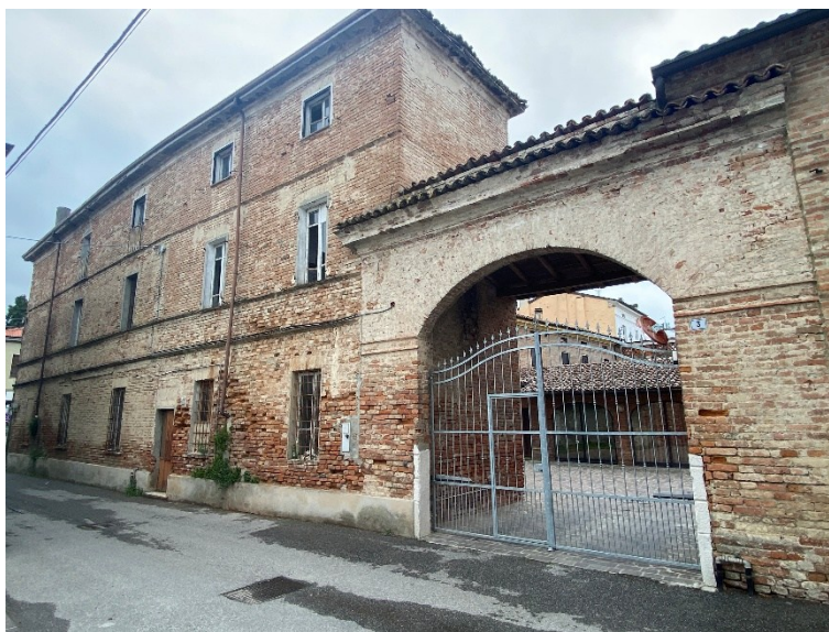
Foto 4 - Ingresso laterale via Gardinazzi
