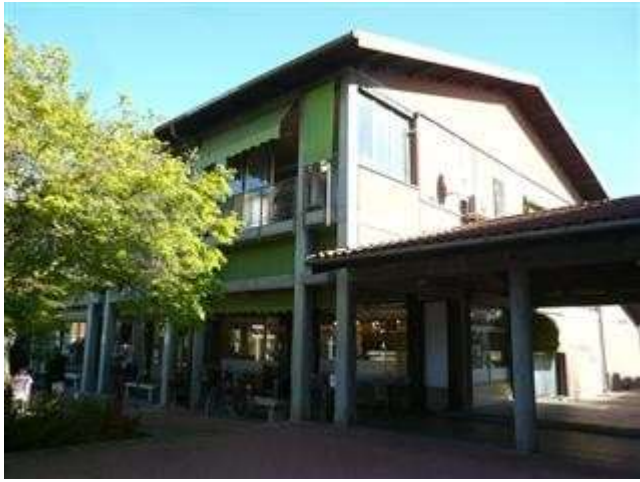
Prospetto esterno con veranda
