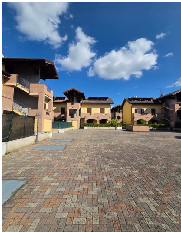
Ingresso complesso immobiliare
