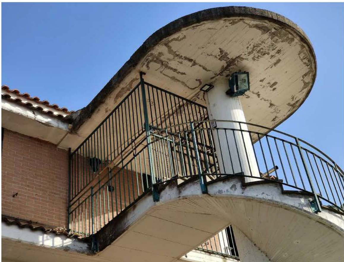
Sopra: particolare del fabbricato in corrispondenza del lato interessato dalla scala in c.a. ad elica di accesso all'U.I. in esecuzione situata al secondo piano. Sotto: dettaglio della scala in c.a. ad elica: in evidenza iniziali patologie interessanti la struttura in c.a. (Foto Ticconi, aprile 2024)
