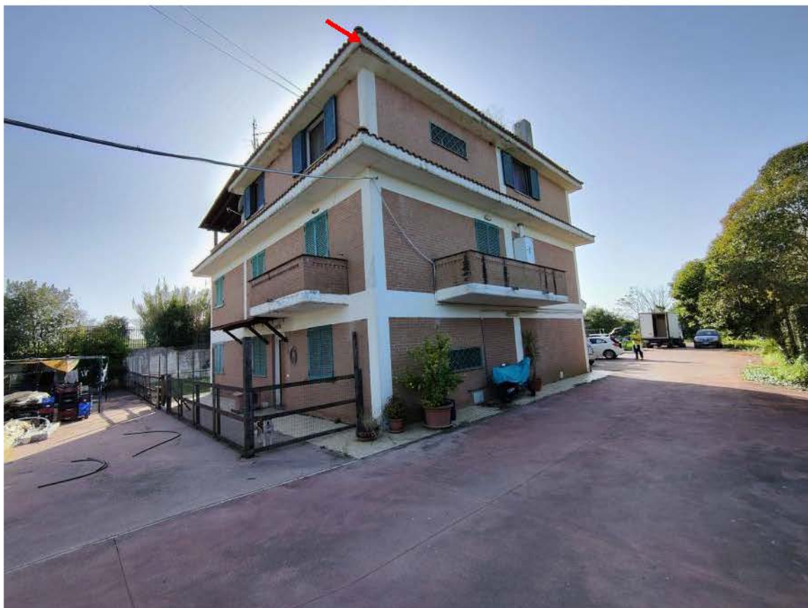
Sopra e sotto: vedute del due lati contigui del fabbricato verso il cancello di ingresso all'area. La freccia rossa indica patologie degenerative del calcestruzzo armato delle strutture (Foto Ticconi, aprile 2024)
