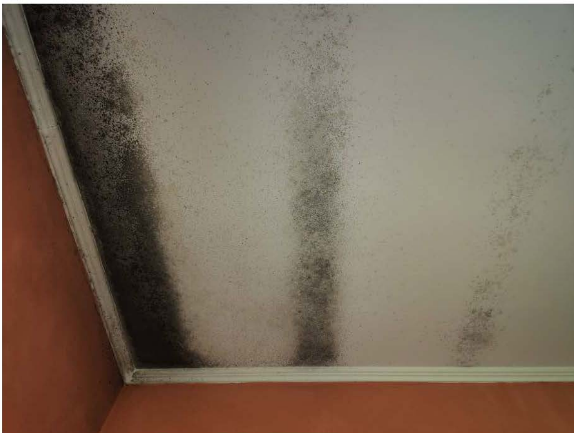
Sopra e sotto: l'U.I. in esecuzione presenta all'interno diffuse problematiche di condensa all'intradosso dei solai e, in particolare nelle zone all'intersezione con le pareti verticali e gli spigoli (Foto Ticconi, aprile 2024)
