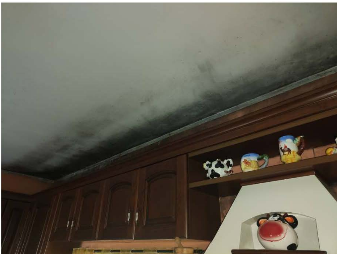
Sopra e sotto: l'U.I. in esecuzione presenta all'interno diffuse problematiche di condensa all'intradosso dei solai e, in particolare nelle zone all'intersezione con le pareti verticali e gli spigoli (Foto Ticconi, aprile 2024)
