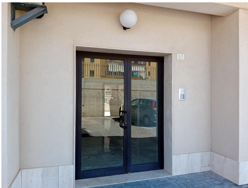
Fot.n°12: Prospetto est – ingresso portone principale
