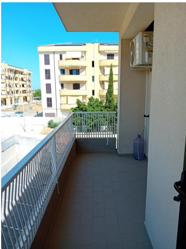
Fot.n°10: Balcone lato est
