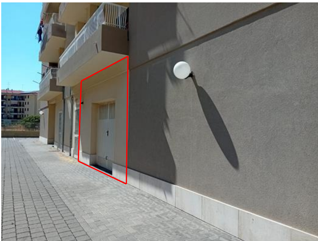
Fot.n°2: prospetto Ovest con il garage sulla destra
