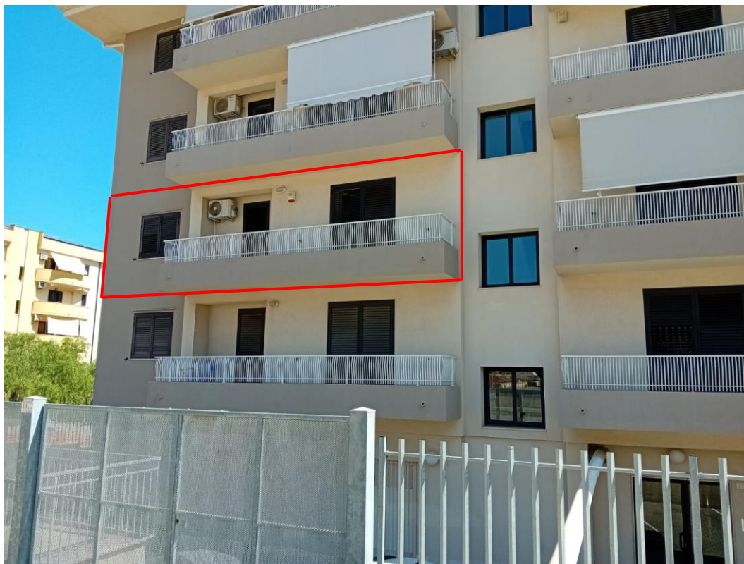
Fot.n°11: Prospetto est
