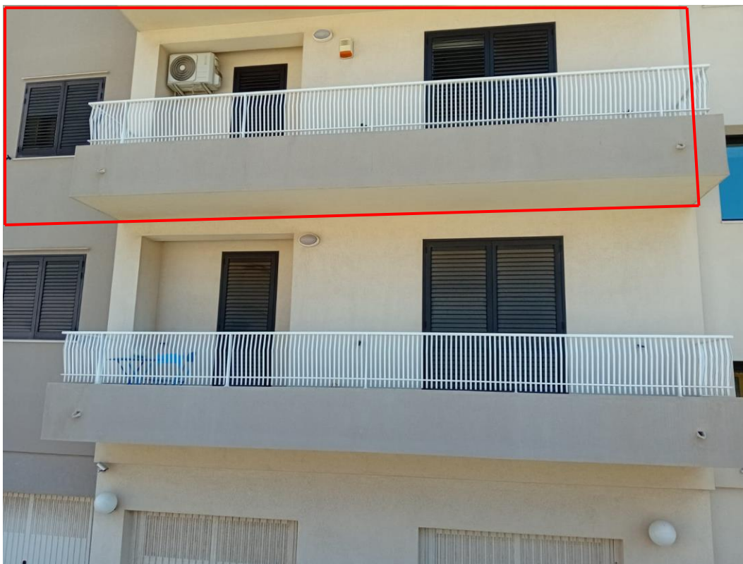
Fot.n°12: Prospetto ovest
