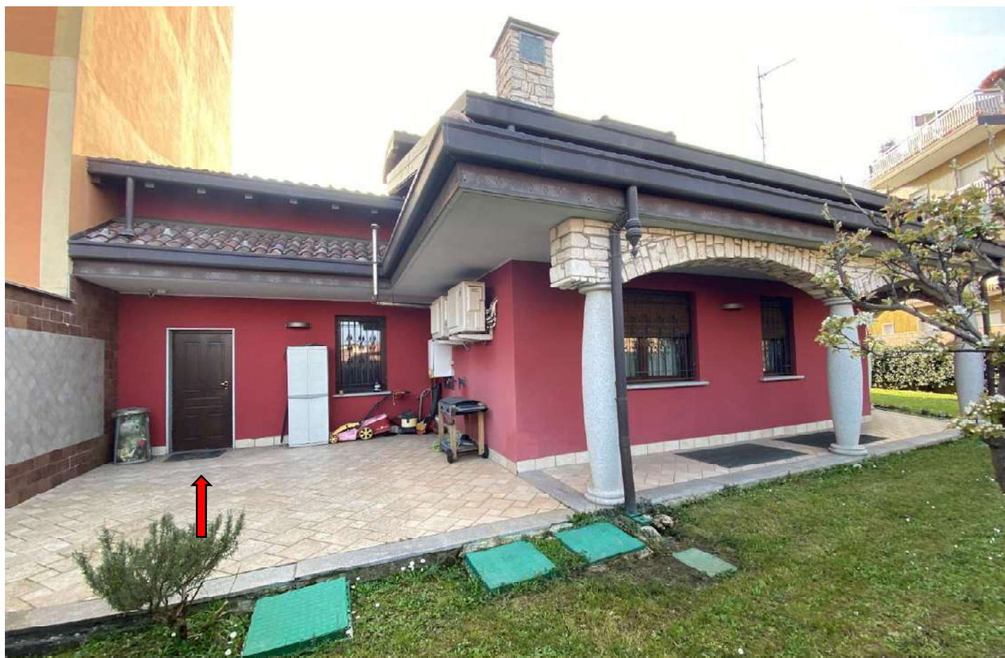
Vista villetta lato Sud/Ovest e vista ingresso Box
