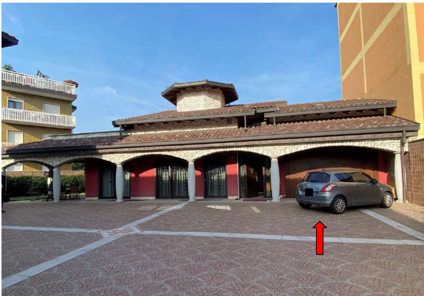
Vista villetta lato Nord/Est e accesso box piano terra
