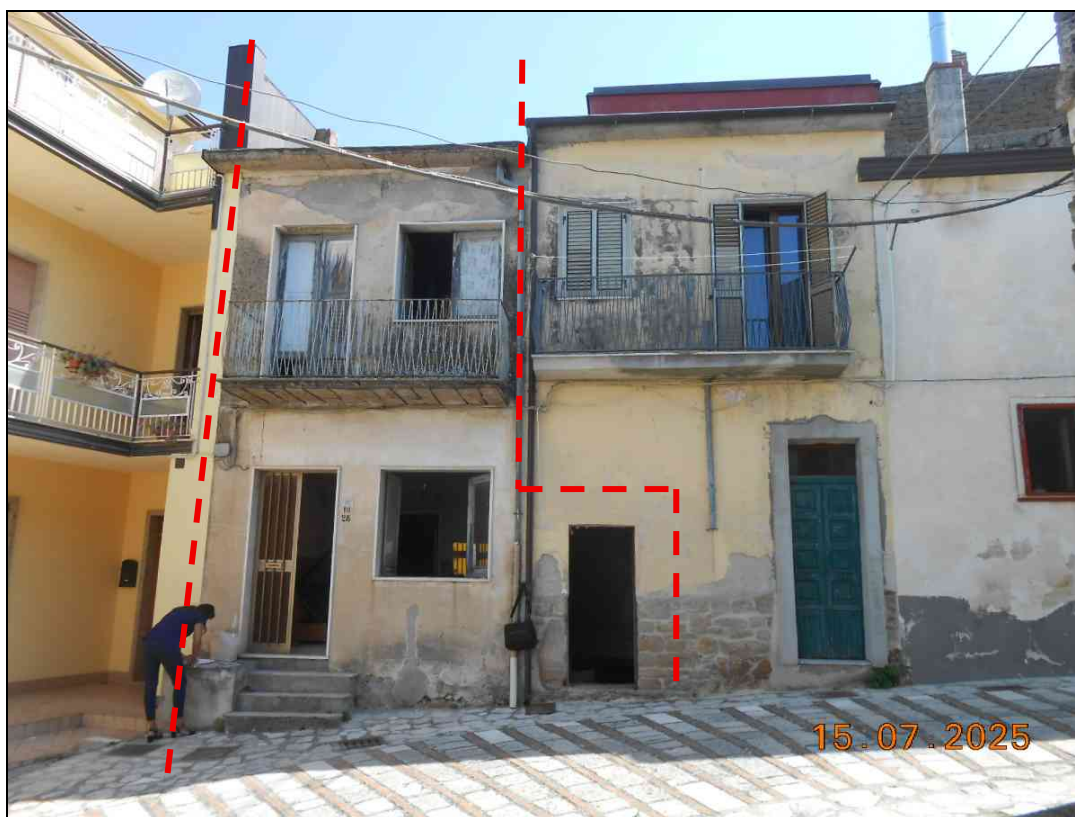
FOTO N. 01 Vista porzione dell'immobile pignorato, su via f.lli Cairoli n. 26-28.
