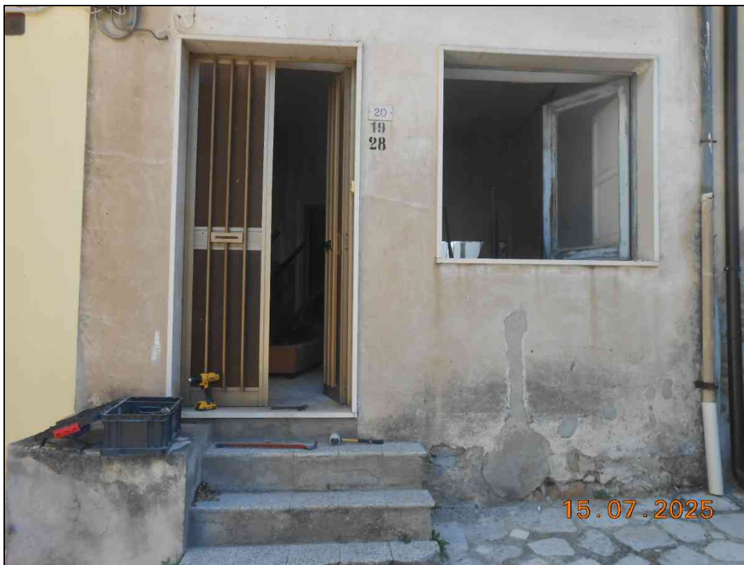
FOTO N. 11 Vista ingresso porzione immobile al piano terra.
