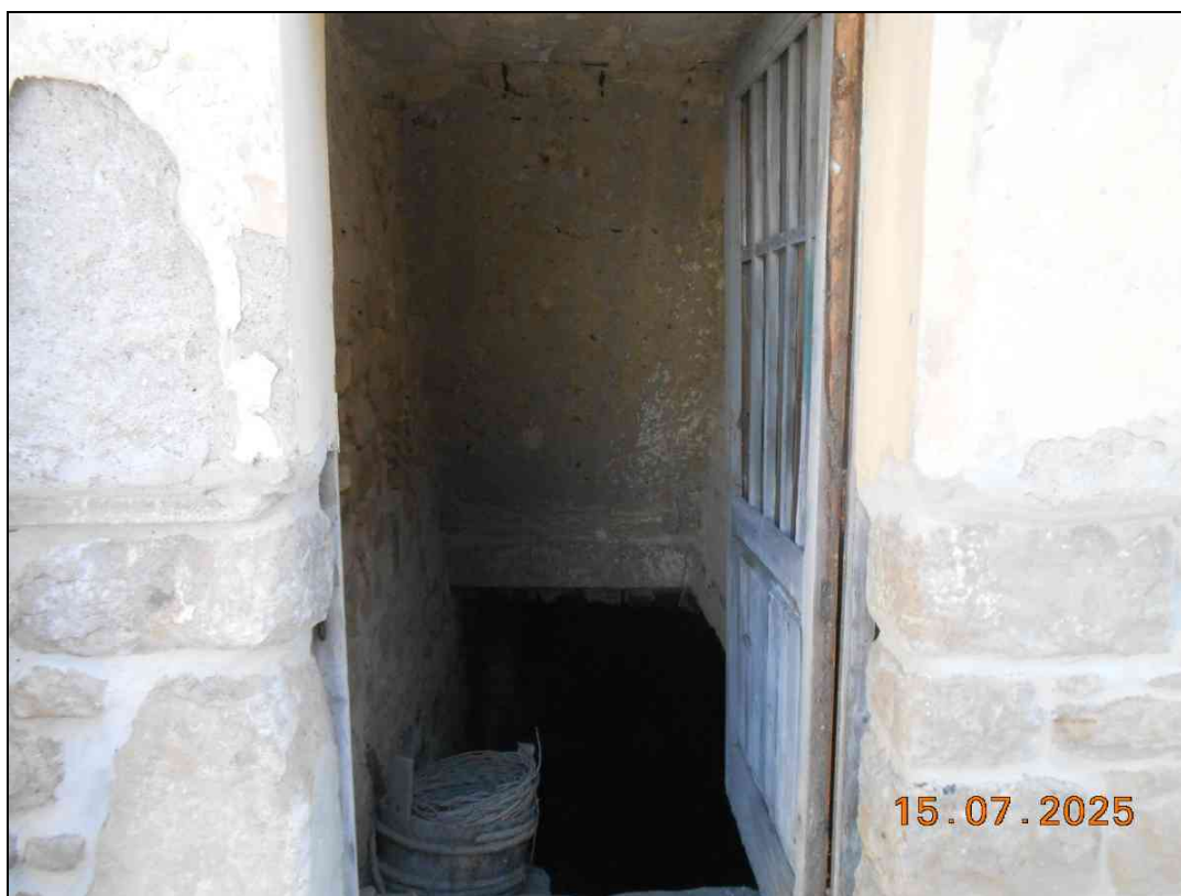
FOTO N. 05 Vista del locale al piano interrato.
