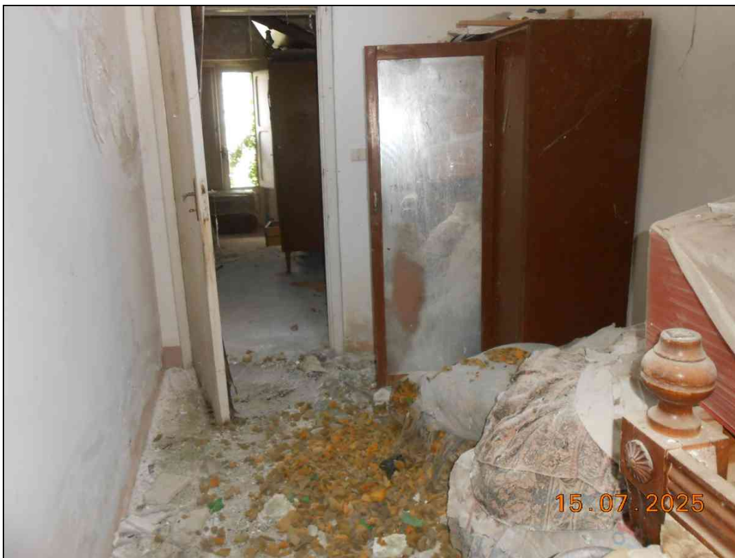
FOTO N. 31 Vista interna del piano primo. Si notano arredi e rifiuti di ogni genere.
