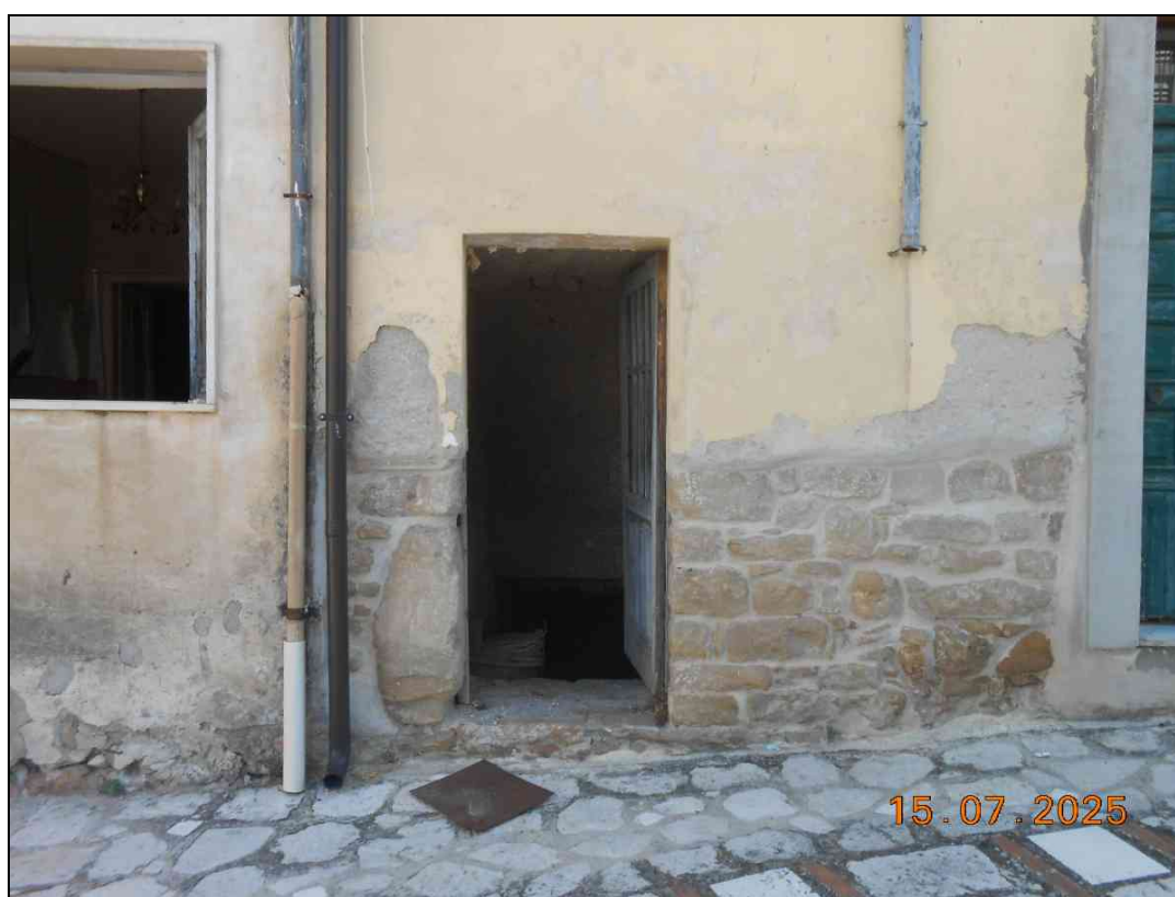
FOTO N. 04 Vista ingresso del locale al piano interrato.
