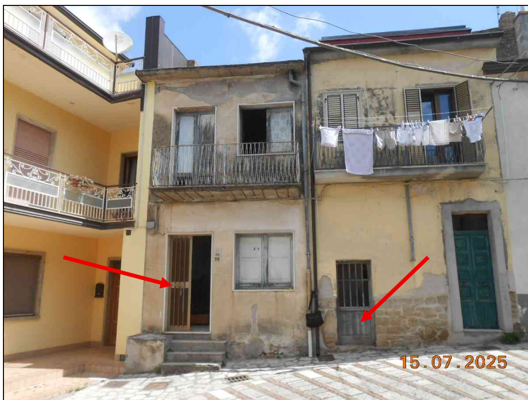
FOTO N. 03 Vista porzione dell'immobile pignorato. Si notano gli accessi al locale al piano interrato e al piano terra.
