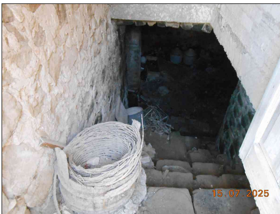
FOTO N. 06 Vista scala di accesso del locale al piano interrato.
