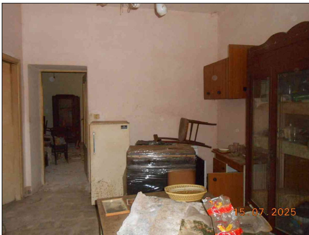
FOTO N. 19 Vista interna immobile al piano terra.
