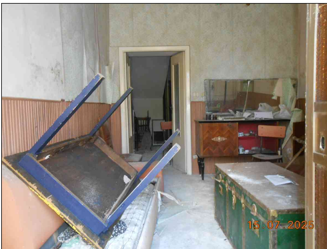
FOTO N. 12 Vista interna immobile al piano terra.
