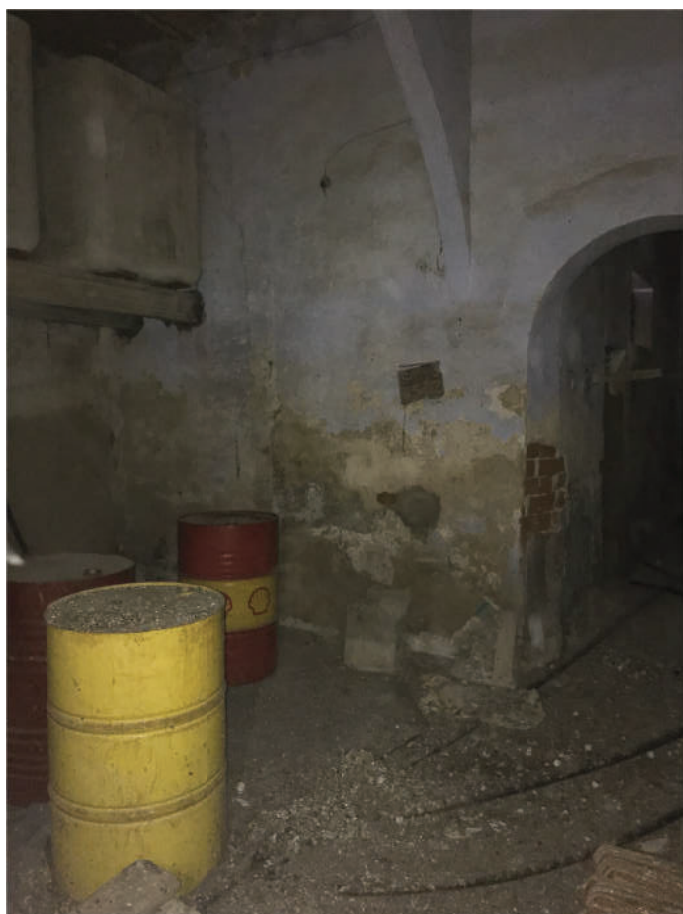
FOTO 17 - INTERNO DEL PIANO TERRENO
