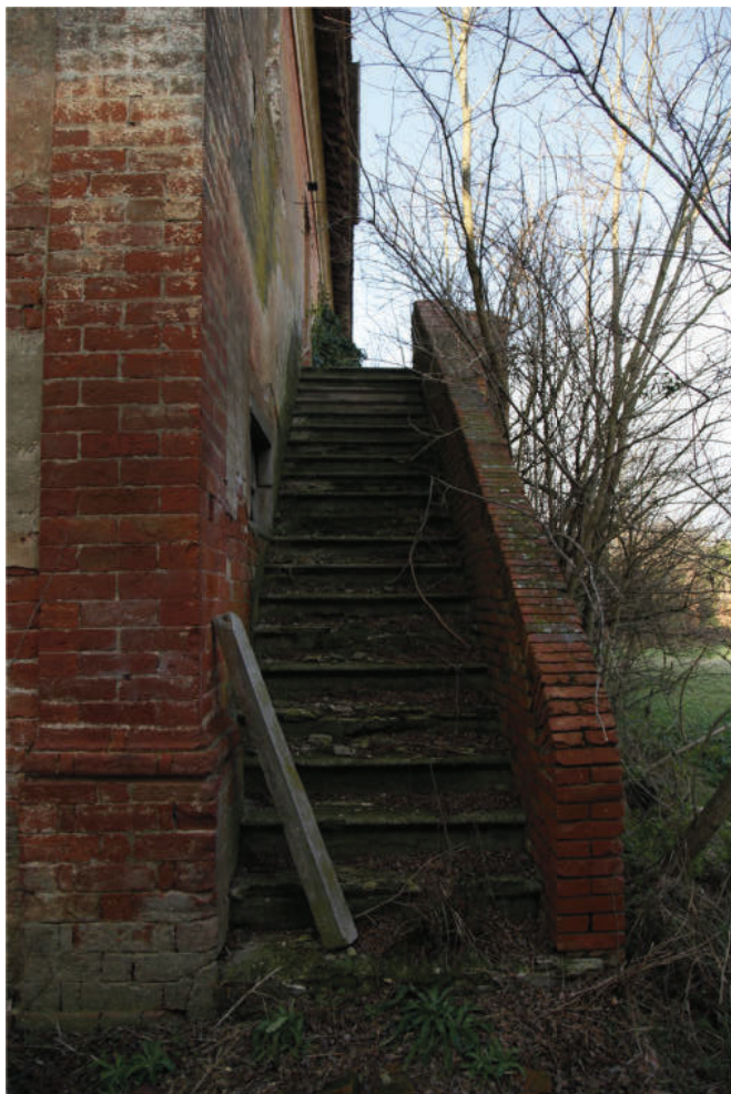
FOTO 15 - VISTA DELLA SCALA ESTERNA
