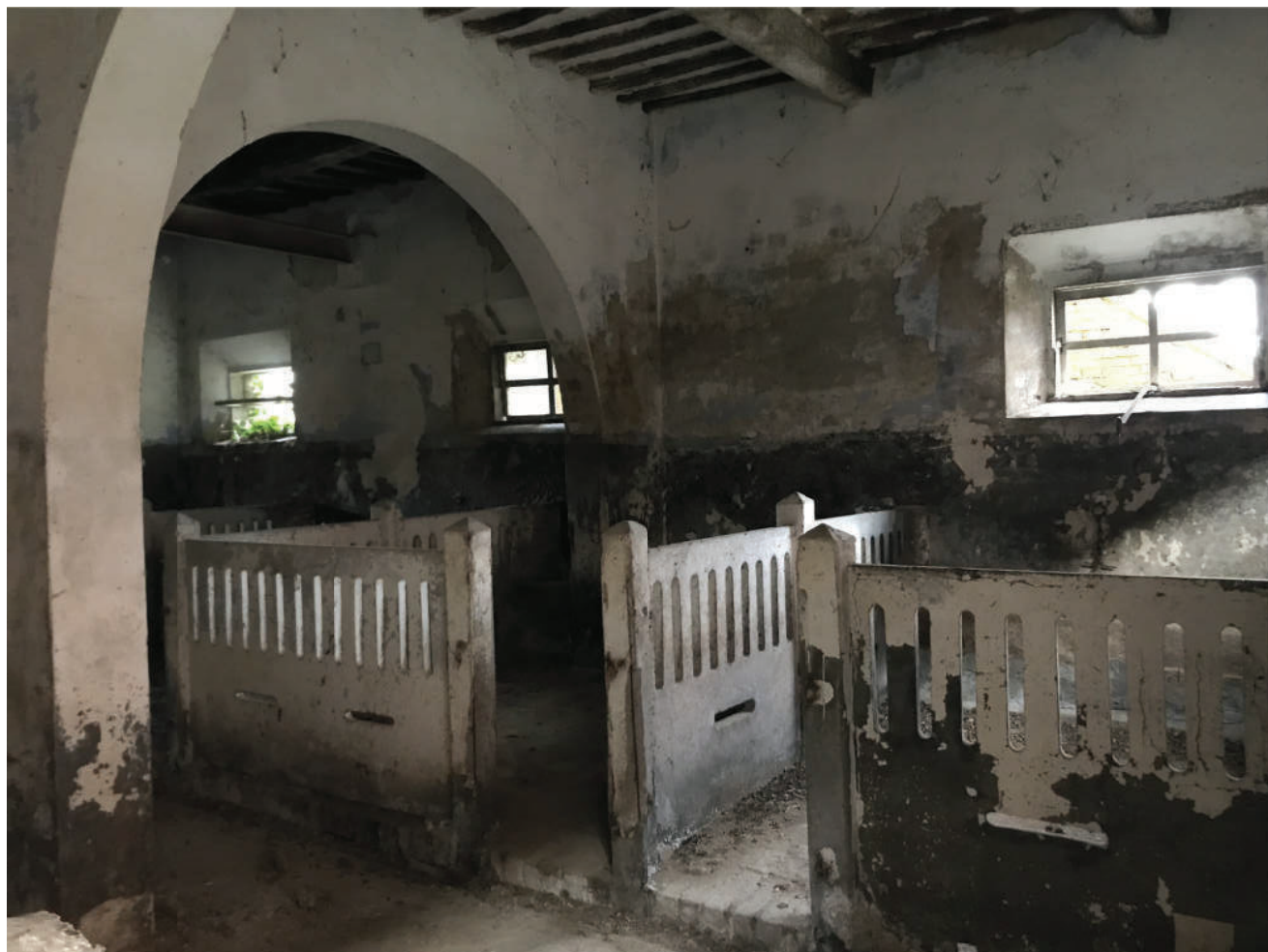
FOTO 20 - INTERNO DEL PANO TERRENO
