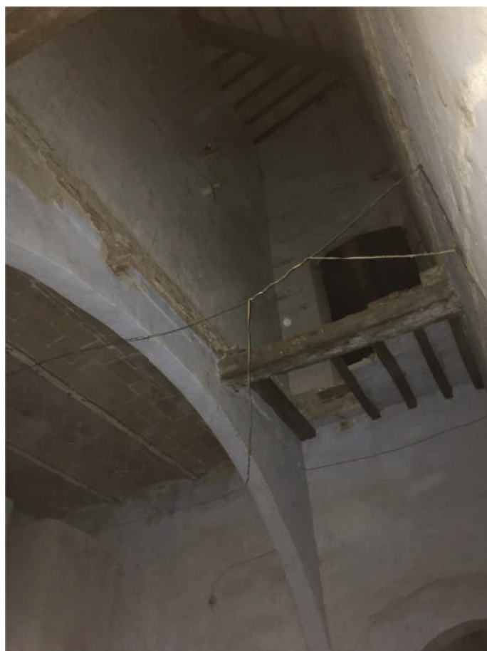
FOTO 18 - INTERNO DEL PIANO PRIMO
