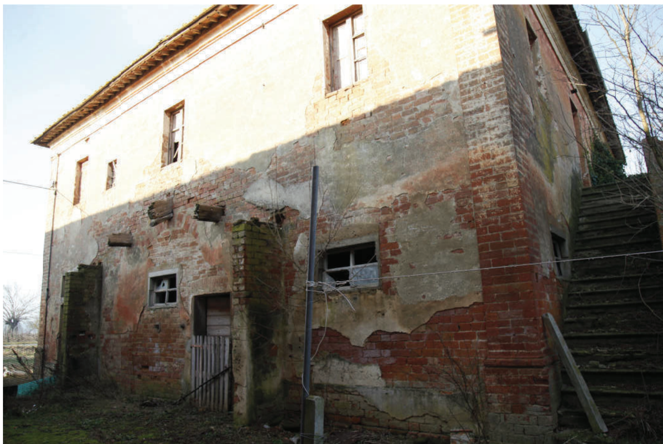
FOTO 14 - VISTA DEL FABBRICATO PRINCIPALE DA SUD
