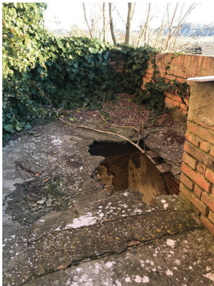
FOTO 16 - VISTA DEL TERRAZZO AL PIANO 1°
