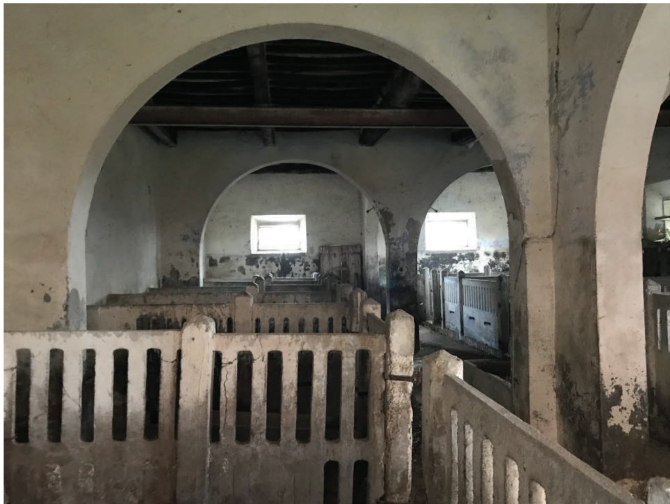
FOTO 19 - INTERNO DEL PANO TERRENO
