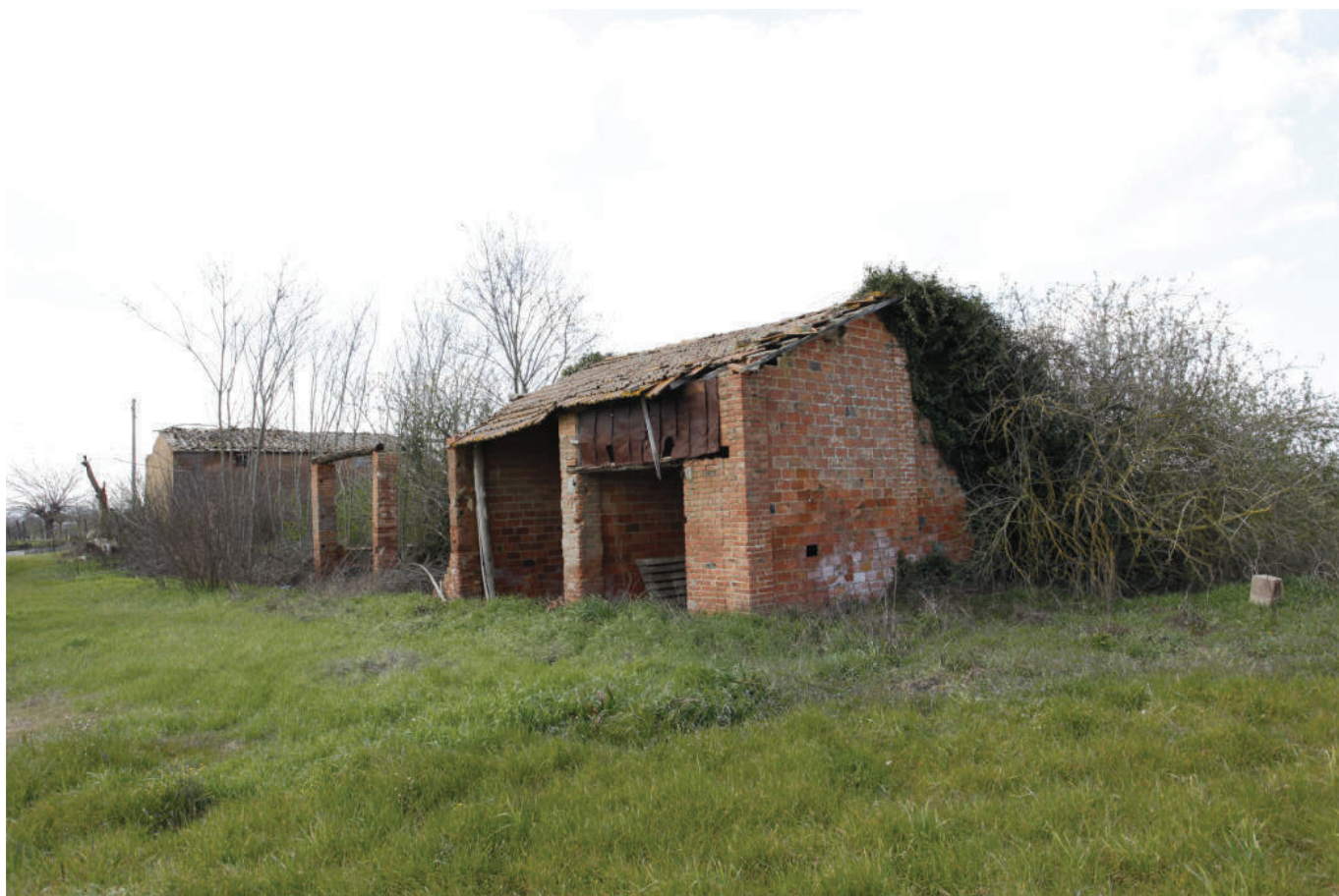
FOTO 30 - VISTA DELL'ANNESSO 3 DA EST
