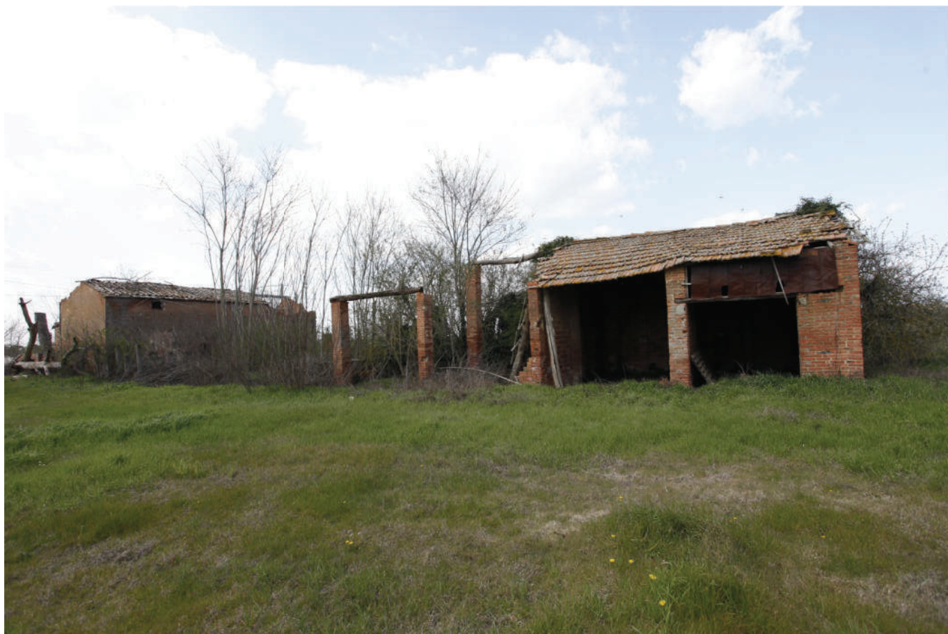
FOTO 29 - VISTA DEGLI ANNESSI 2 E 3 DA SUD
