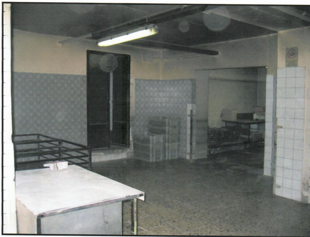
Foto 1: Zona di stoccaggio con accesso al locale tecnico.
