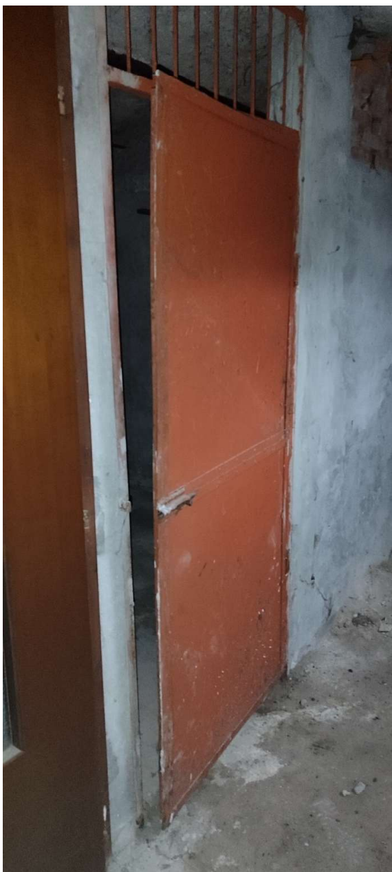
PORTA DI ACCESSO ALLA CANTINA
