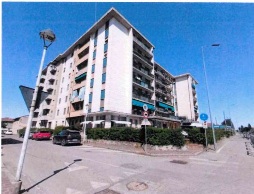
COMUNE di SORESINA, incrocio tra via IV novembre e via Paulli
