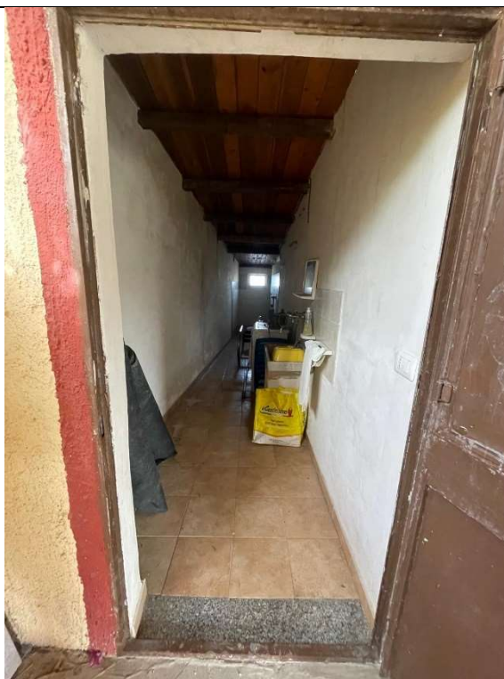
Vano adiacente la casa
