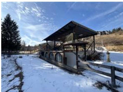
Vista su p.ed. 979 (da demolire) - prospetto nord/est
