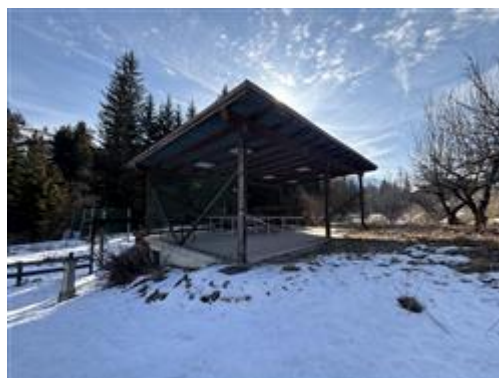
Vista su p.ed. 979 (da demolire) - prospetto ovest
