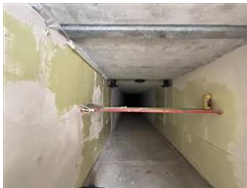
Vista su tunnel di sparo - piano interrato p.ed. 1548
