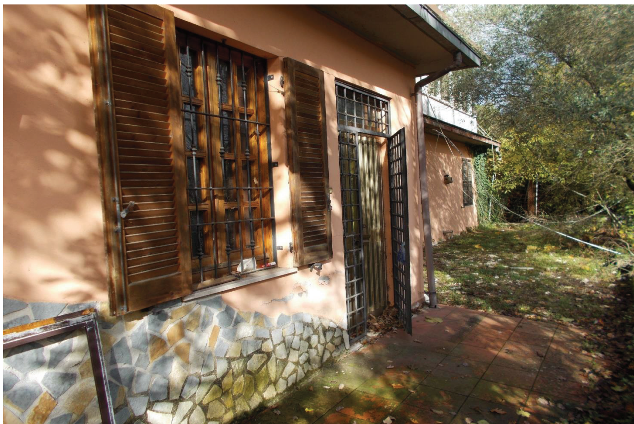
FOTO 4 – ESTERNO FABBRICATO CON CORTE
