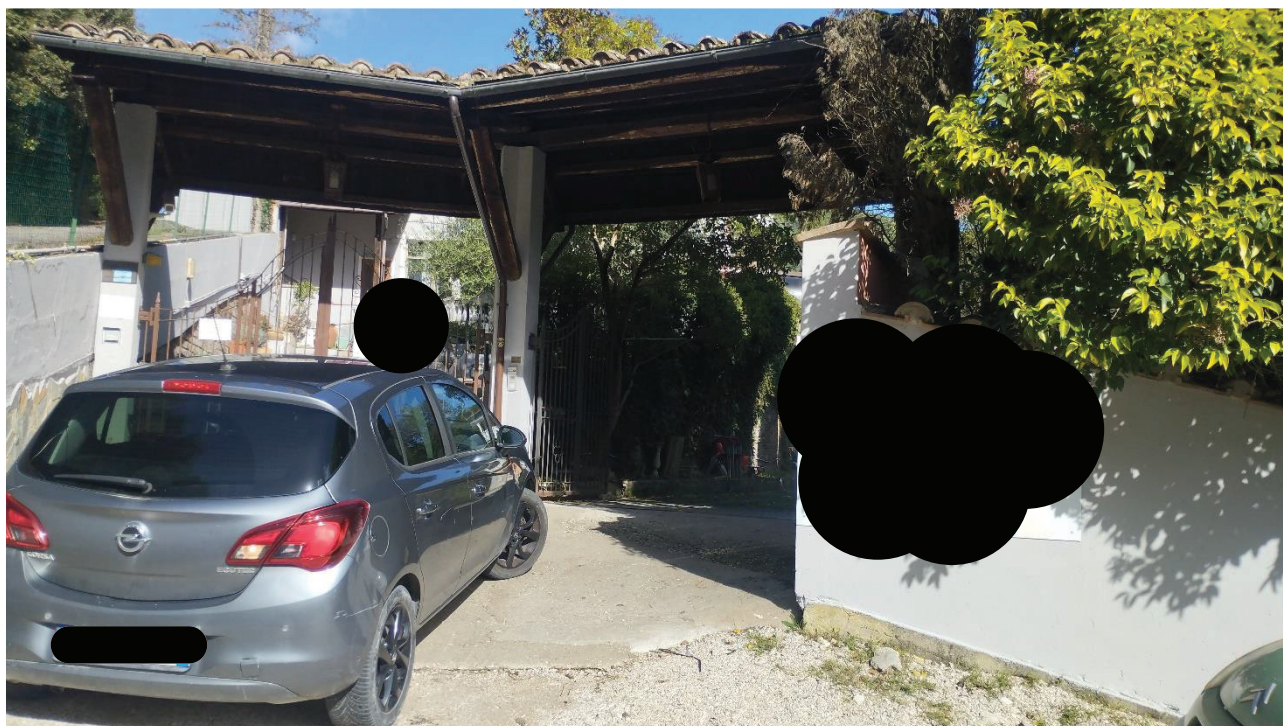
FOTO 1 – CANCELLO INGRESSO PRORIETA'
