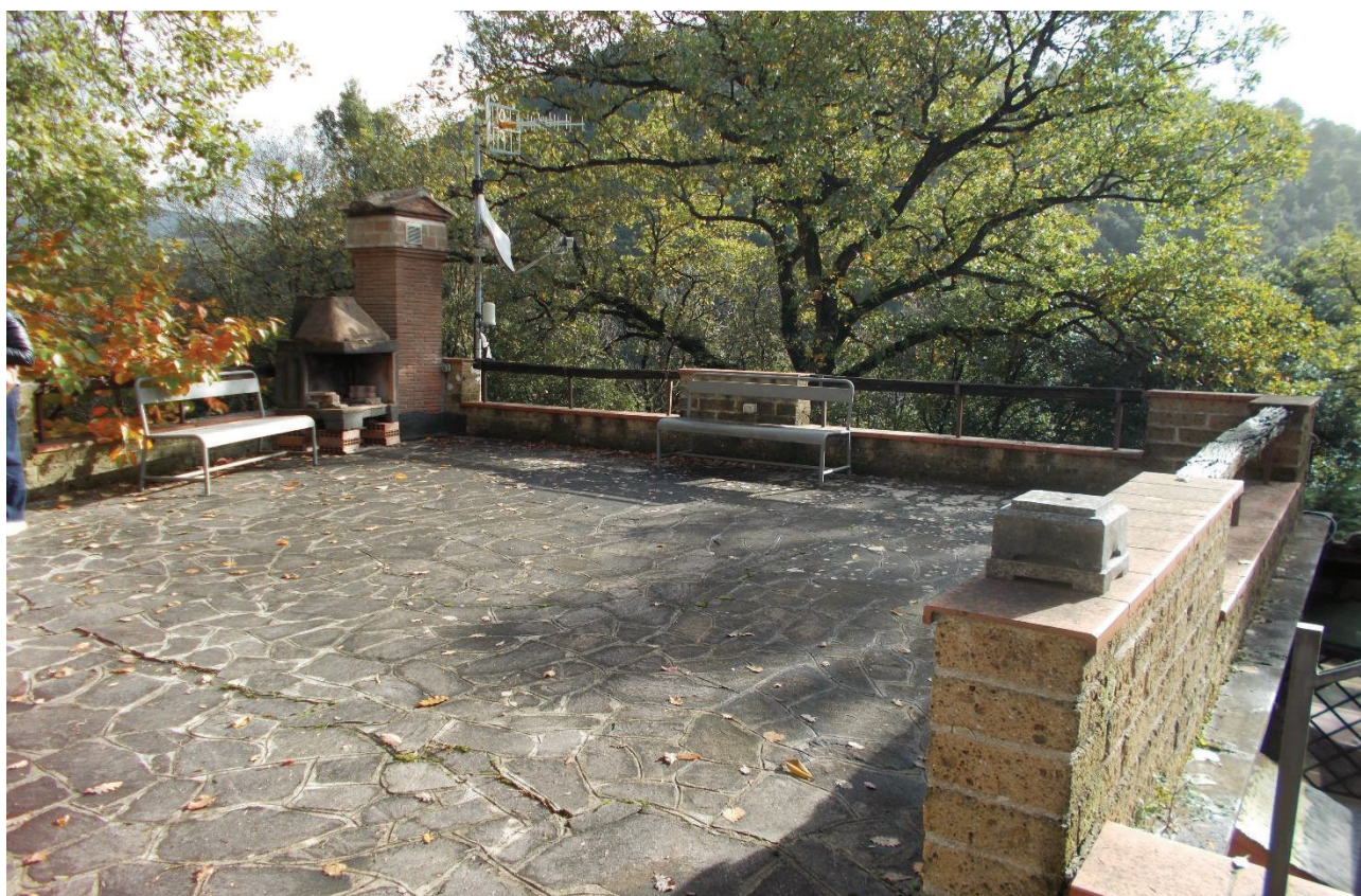
FOTO 6 – LASTRICO SOLARE (P.LLA 328 SUB 2)
