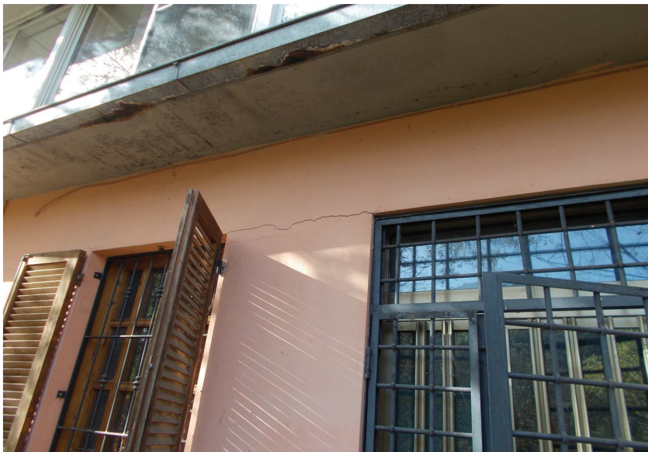
FOTO 7 – LESIONE NEL MURO
