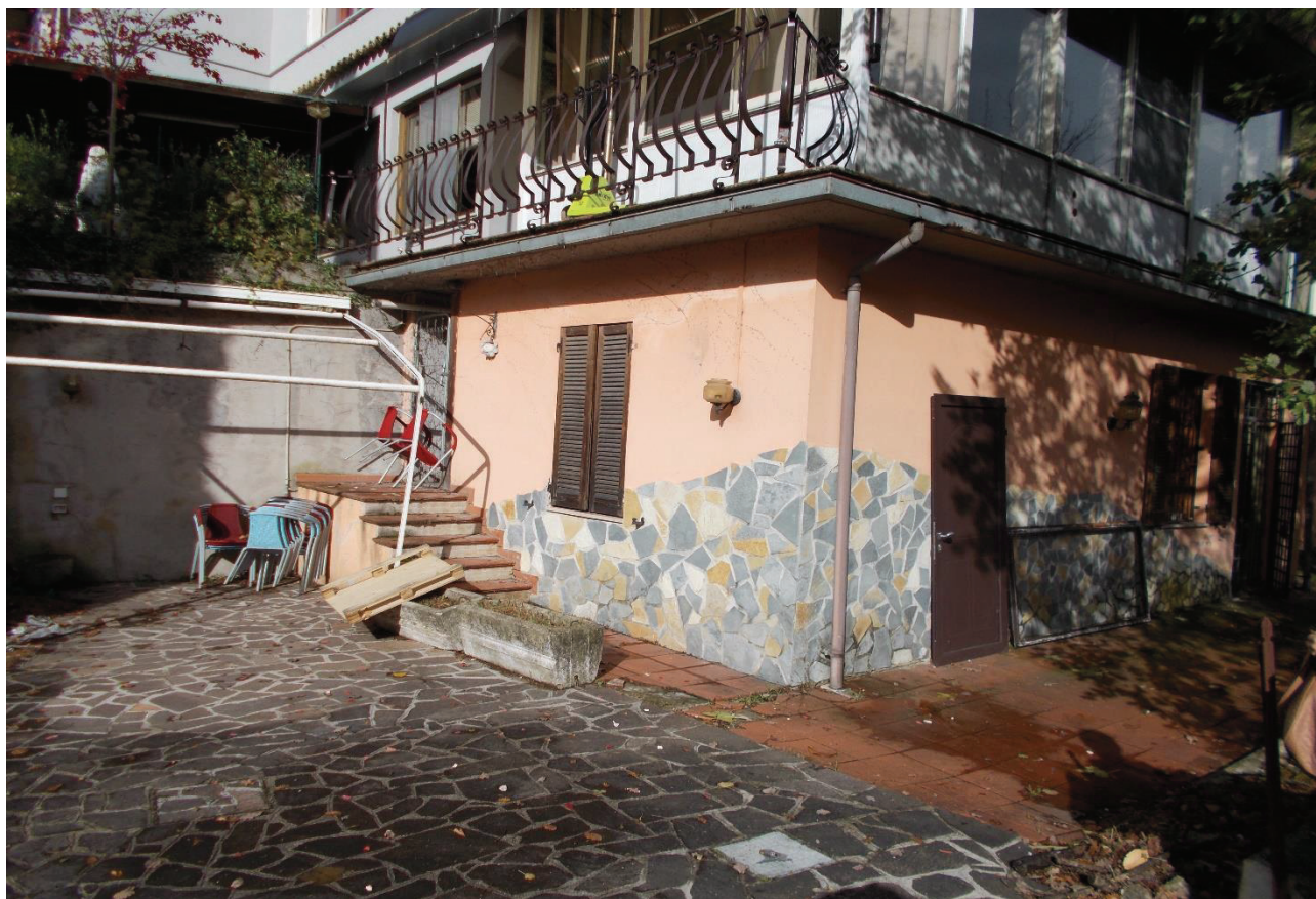
FOTO 3 – ESTERNO FABBRICATO CON CORTE
