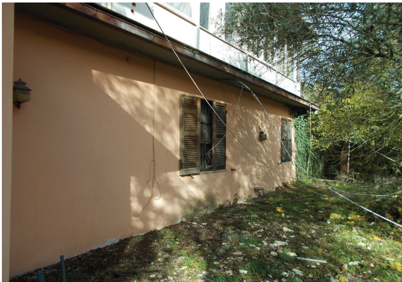
FOTO 5 – ESTERNO FABBRICATO CON CORTE
