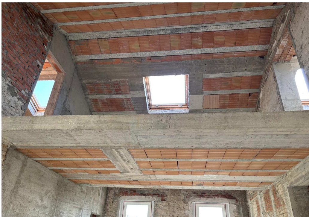
FOTO N. 10 SOTTOTETTO (PORZIONE CHE SI AFFACCIA SU SOGGIORNO)
