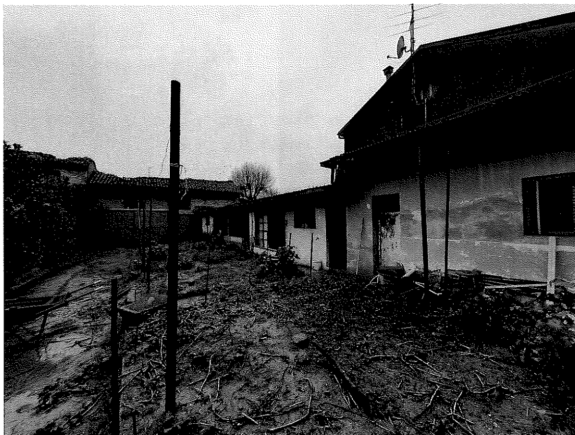
FOTOGRAFIA 26: vista dell'area esterna.
