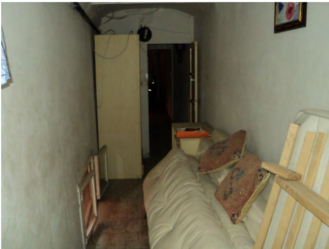
CANTINA PIANO INTERRATO
