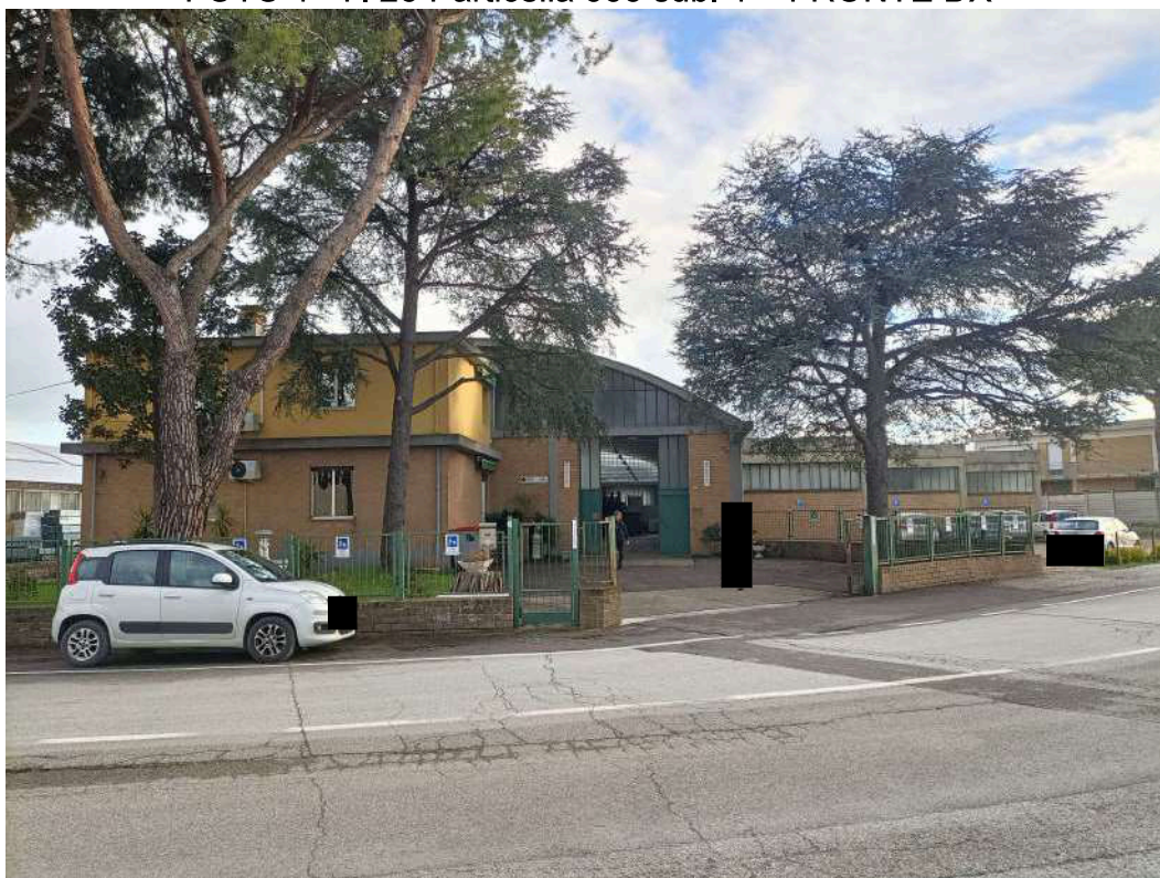
FOTO 1 - F. 25 Particella 665 sub. 1 – FRONTE DX
