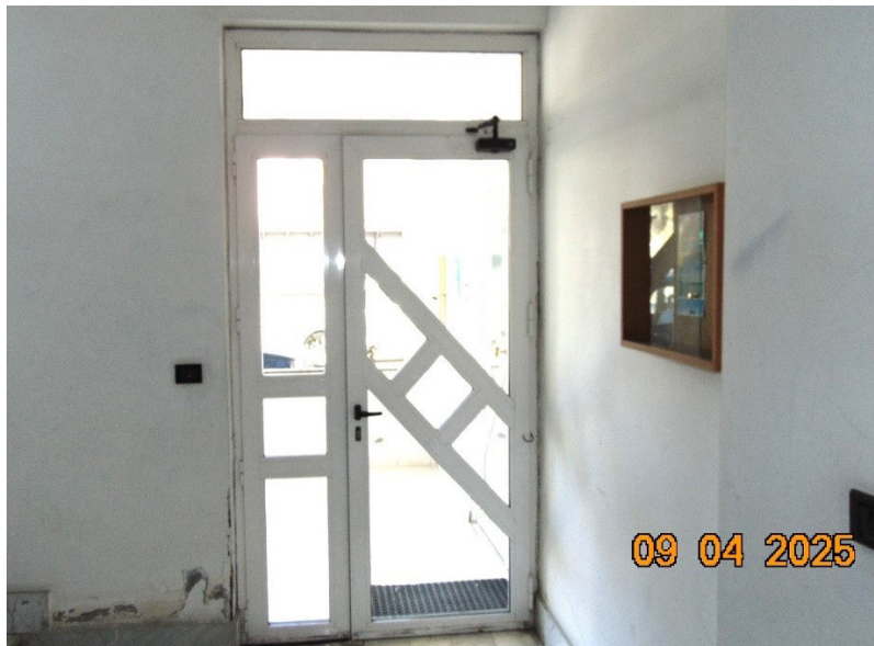
Particolare portone ingresso (vista dall'interno)
