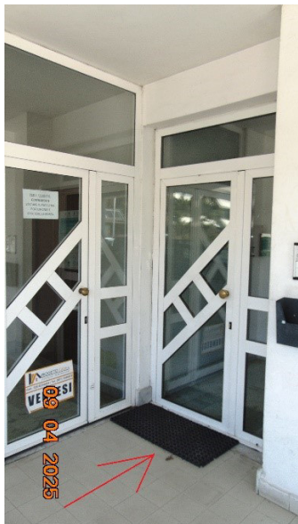
Ingresso portone androne Condominiale (vista esterna)
