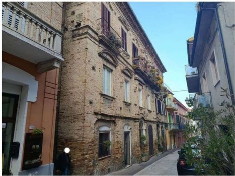
Veduta ingresso principale Corso Vittorio Emanuele
