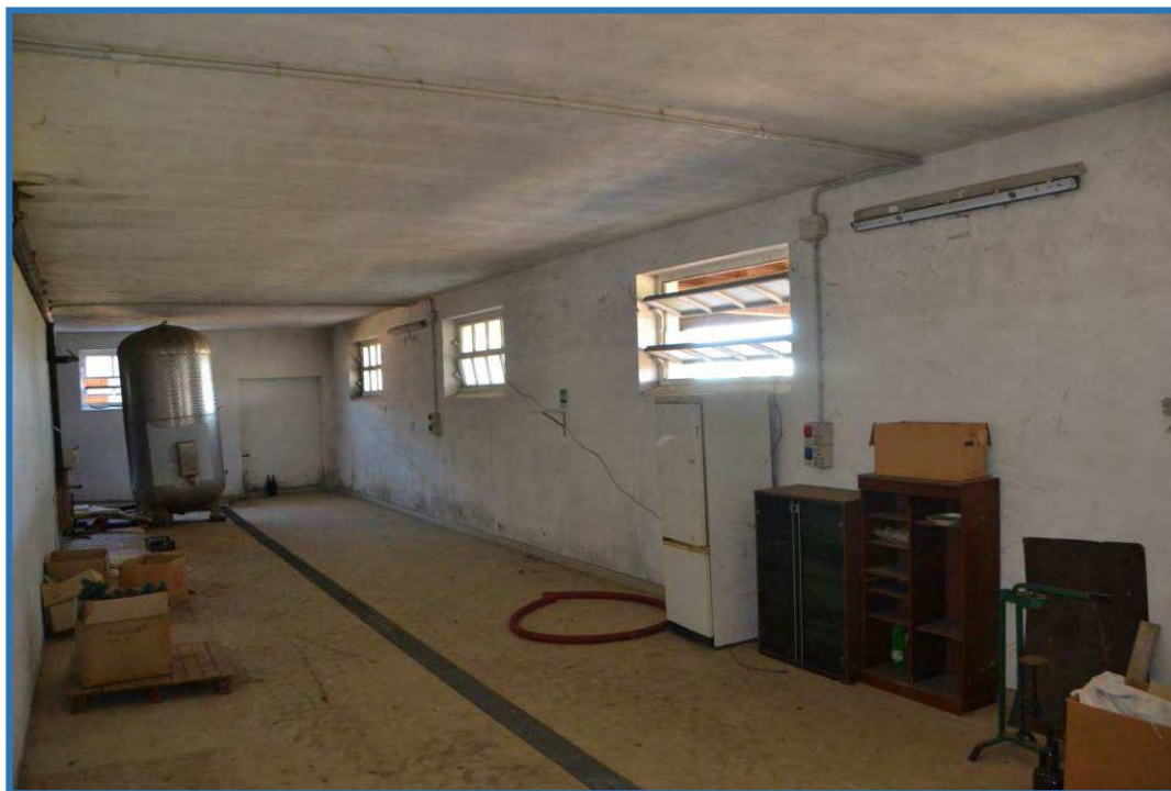
IMMAGINE 35: locale piano terra
