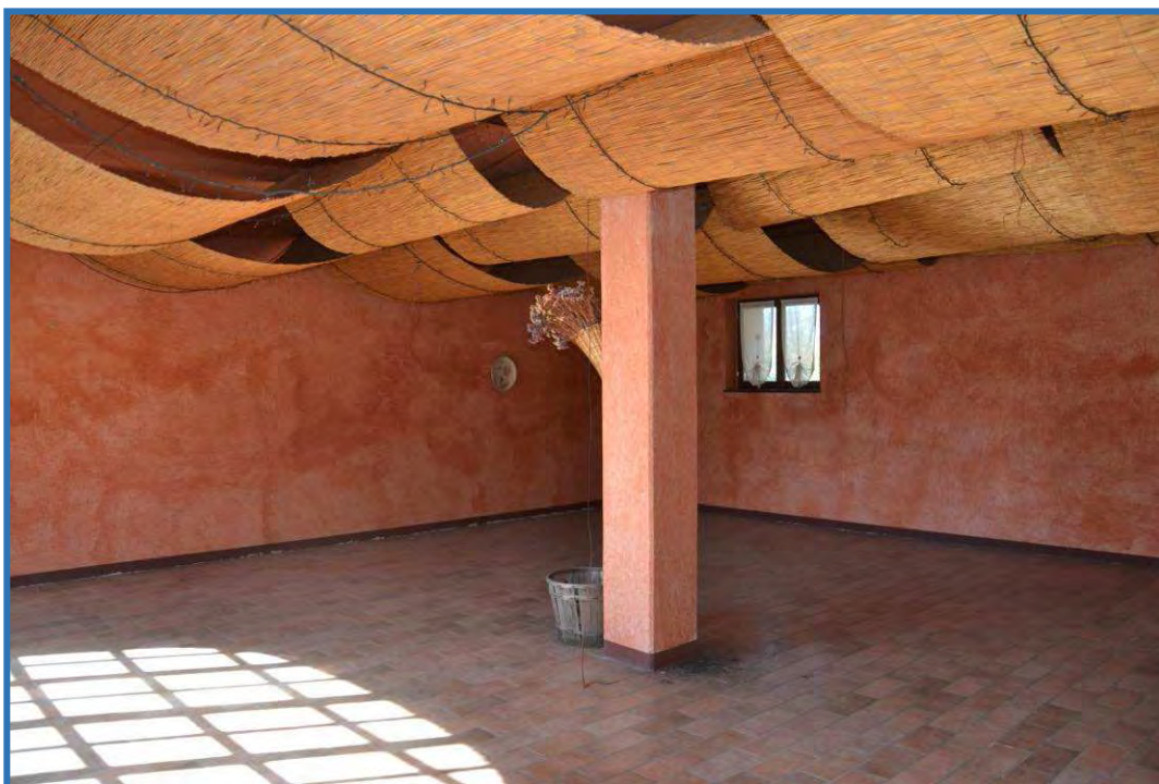
IMMAGINE 27: locale piano terra
