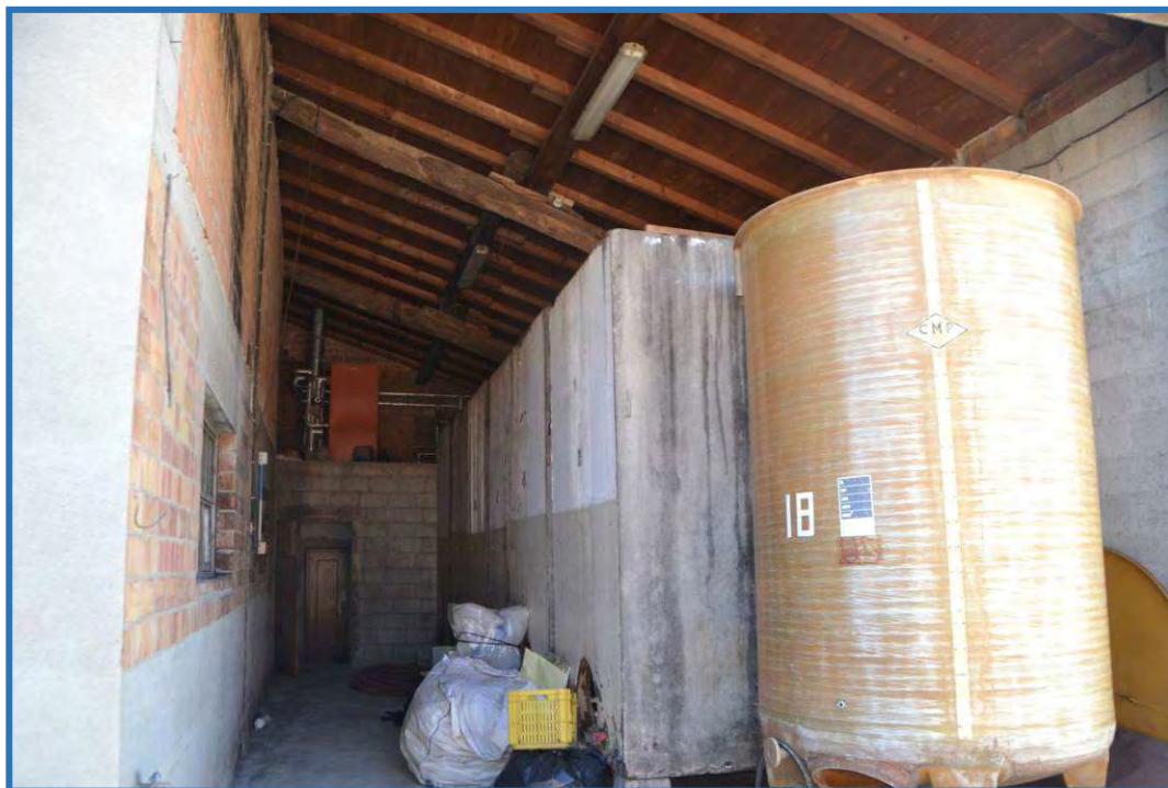
IMMAGINE 37: locale piano terra
