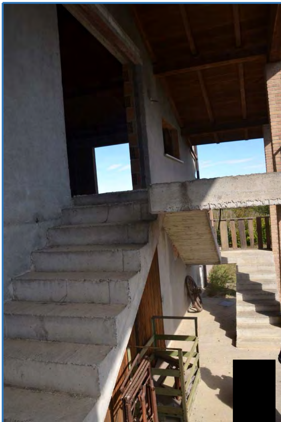
IMMAGINE 30: scala d'accesso piano primo al rustico
