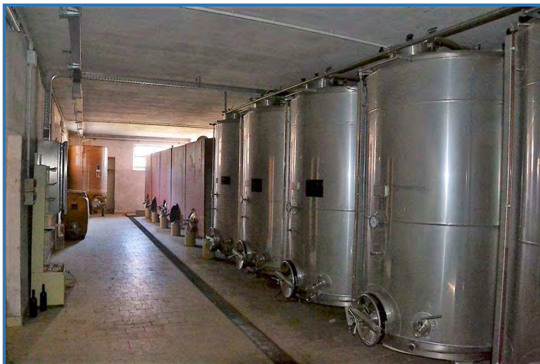
IMMAGINE 36: locale piano terra
