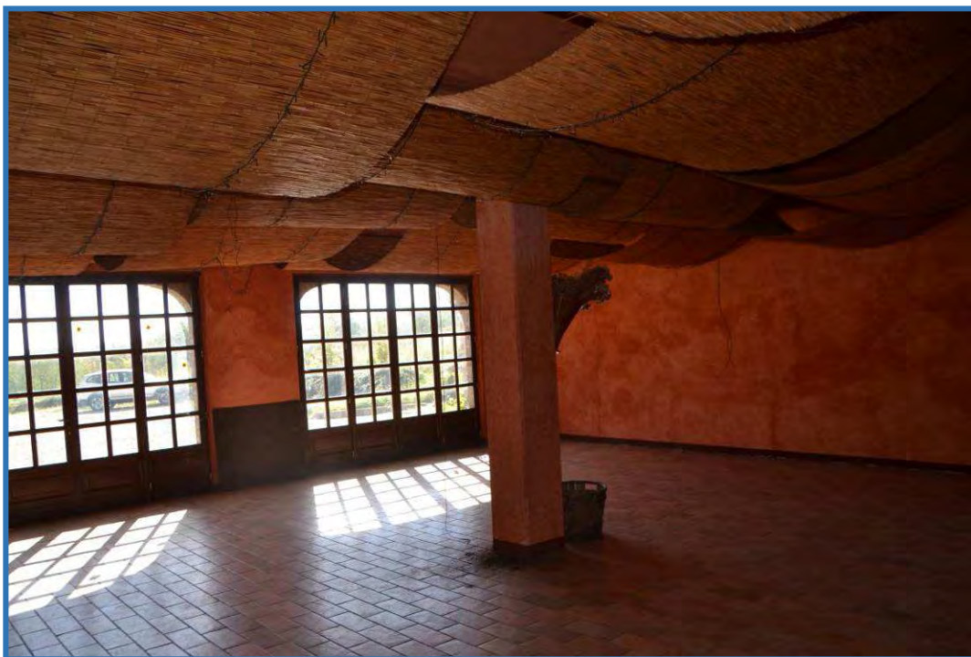
IMMAGINE 28: locale piano terra
