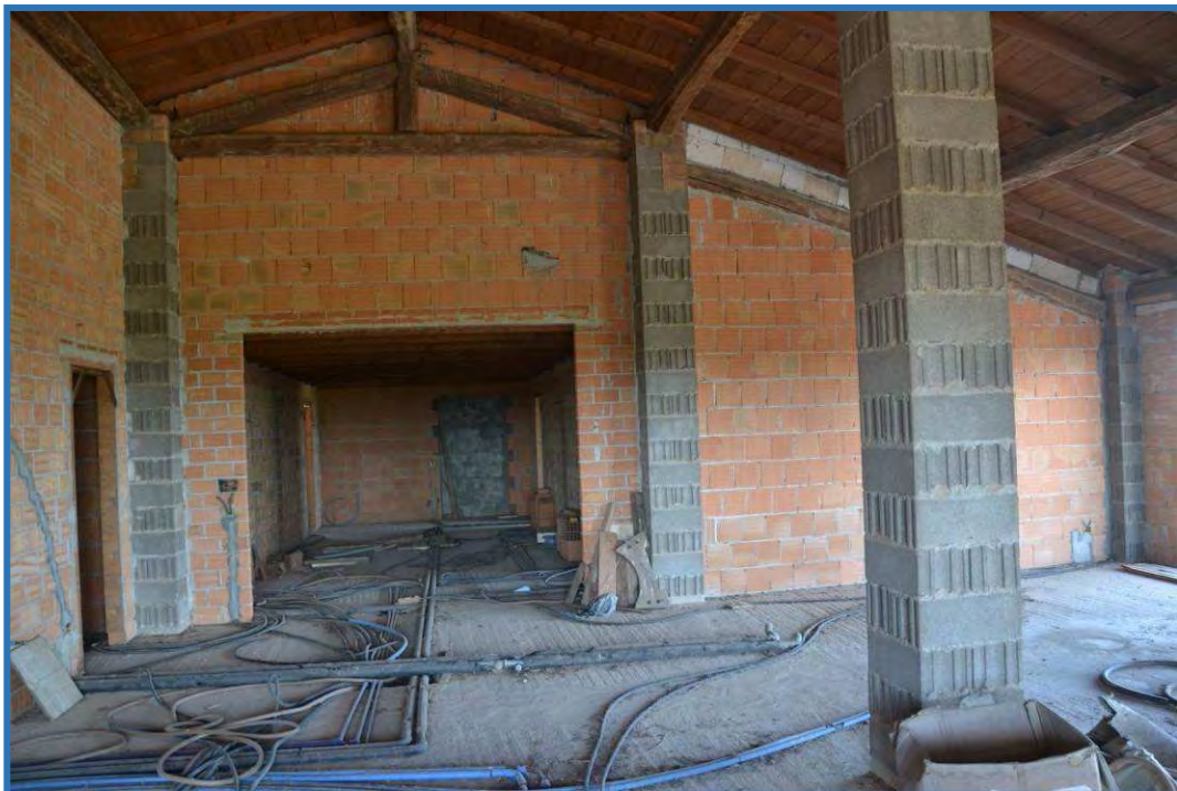
IMMAGINE 32: locale piano primo
