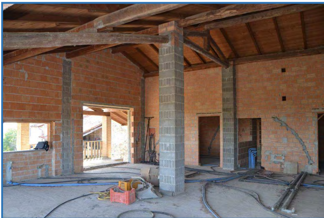
IMMAGINE 31: locale piano primo
