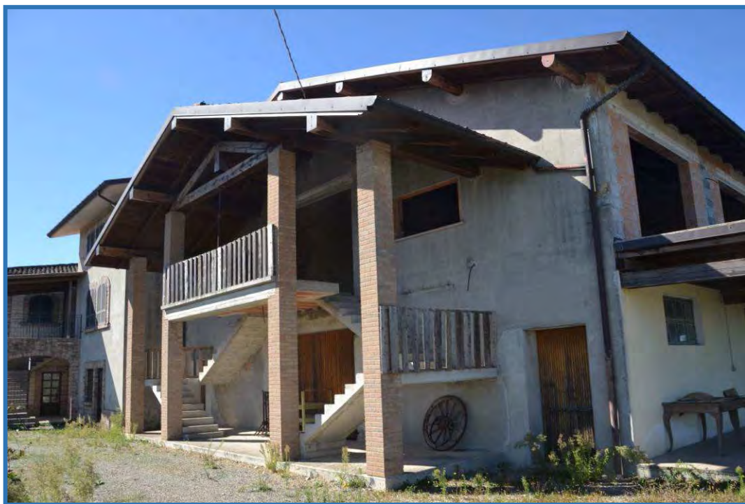
IMMAGINE 04: vista esterna lotto 01
