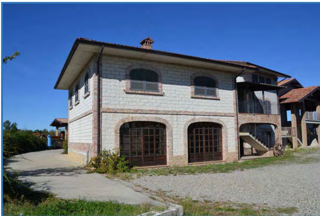
IMMAGINE 03: vista esterna lotto 01
