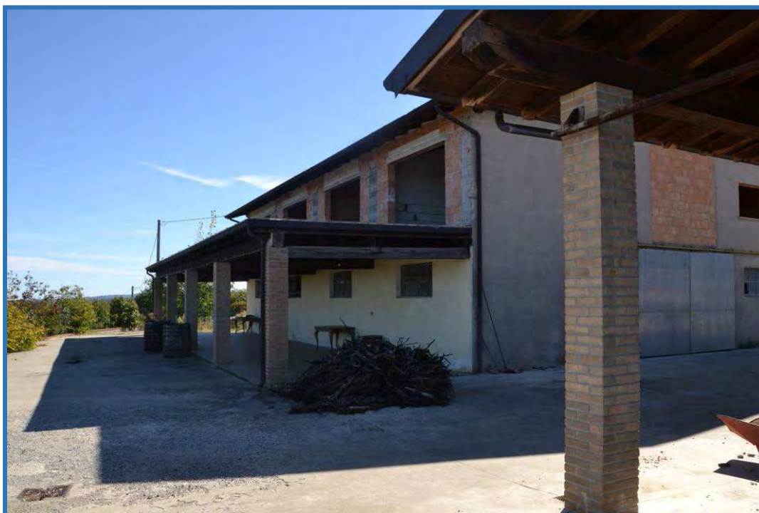
IMMAGINE 05: vista esterna lotto 01
