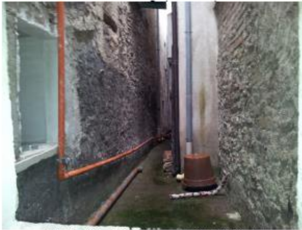
Foto 6 – Cavedio di distacco da altri fabbricati
