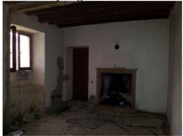
Foto 7 - Vano in ristrutturazione
