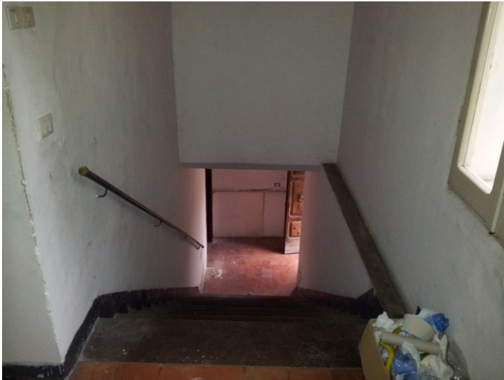
Foto 8 – Scala d'accesso al Piano Primo
