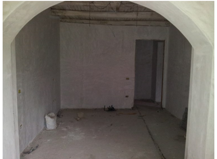
Foto 5 – Ingresso appartamento in ristrutturazione
