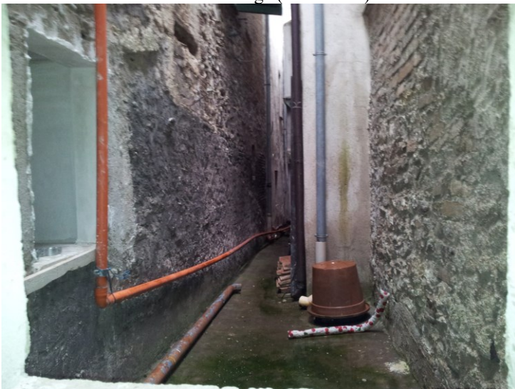
Foto 6 – Cavedio di distacco da altri fabbricati
