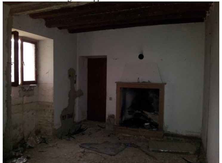
Foto 7 - Vano in ristrutturazione
