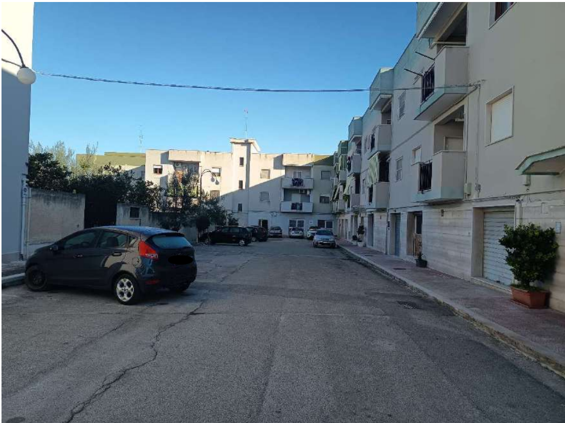
Foto n°2: Area condominiale destinato al parcheggio.
