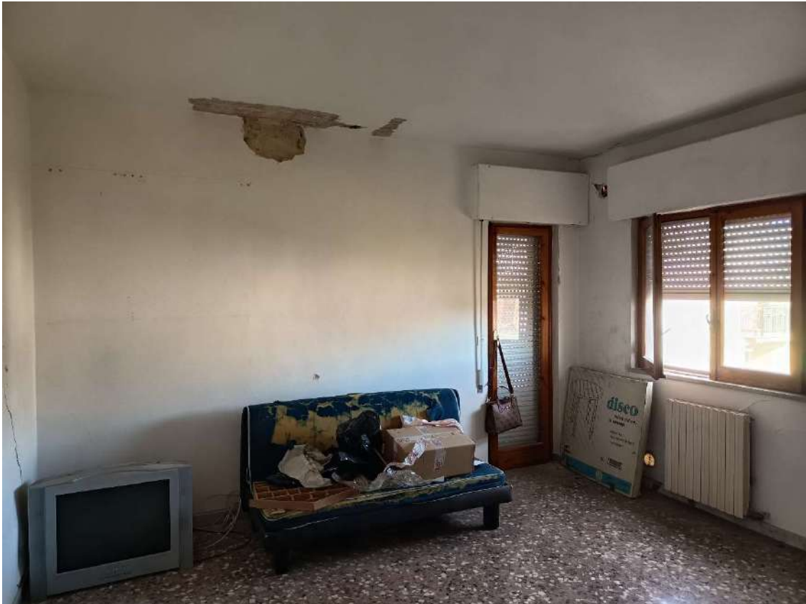
Foto n°12: Vista della cucina dell'appartamento oggetto di stim
