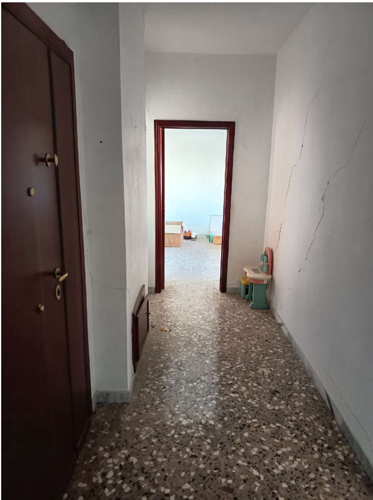
Foto n°10: Vista dell'ingresso dell'appartamento oggetto di stima.
