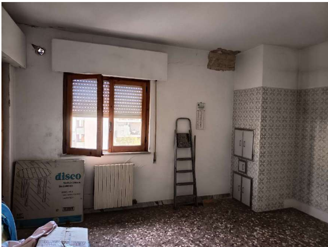
Foto n°14: Vista della cucina dell'appartamento oggetto di stima.
