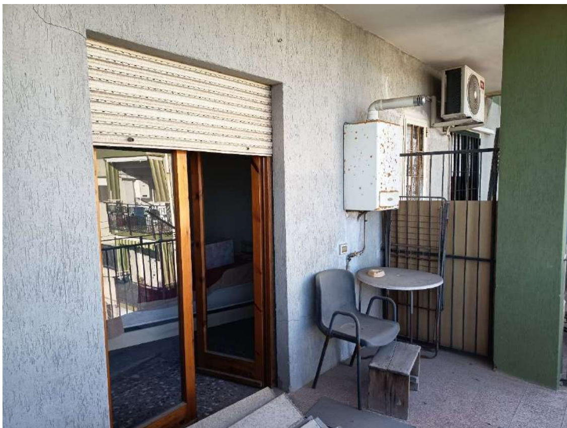
Foto n°25: Vista del balcone dell'appartamento oggetto di stima.
