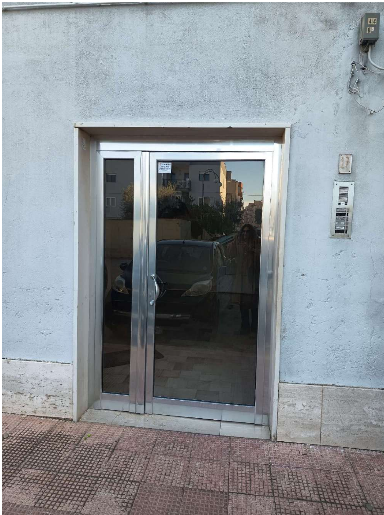
Foto n°5: Vista del portone di accesso al fabbricato in cui insiste l'immobile oggetto di stima.
