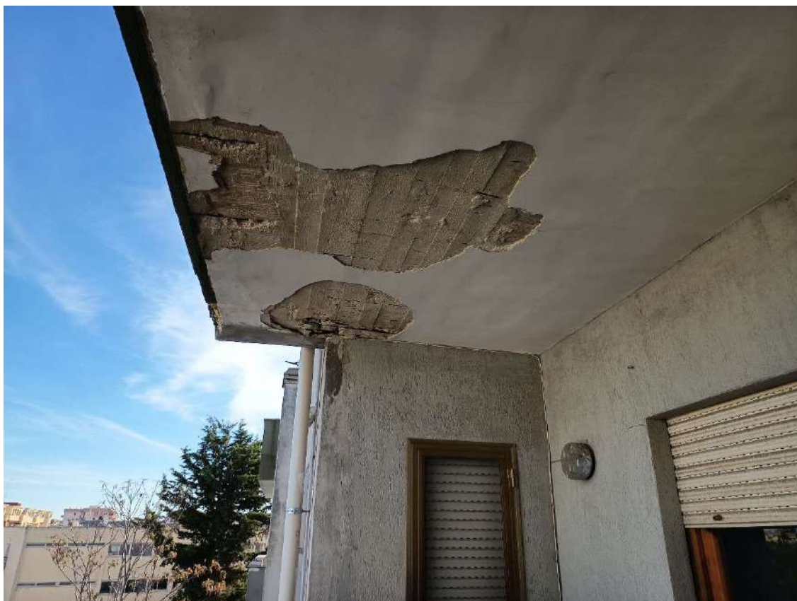
Foto n°24: Vista del balcone dell'appartamento oggetto di stima.
