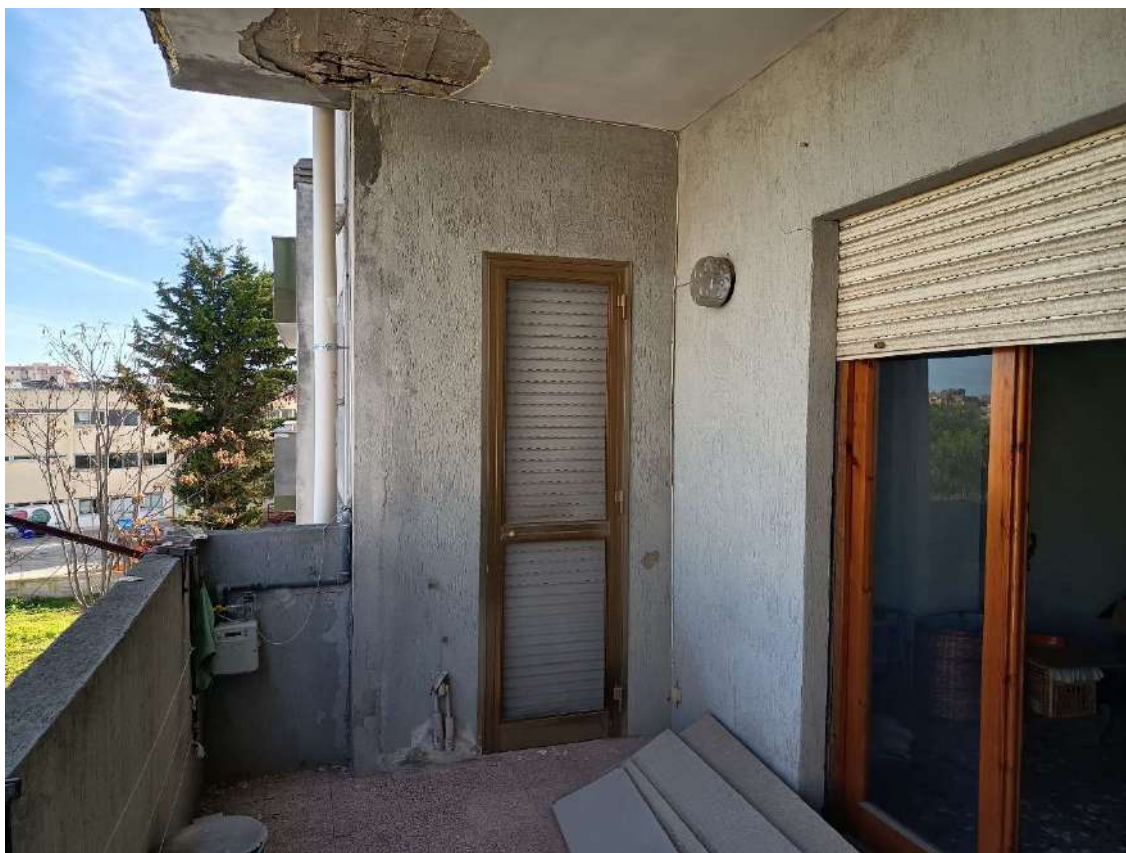
Foto n°22: Vista del balcone dell'appartamento oggetto di stima.
