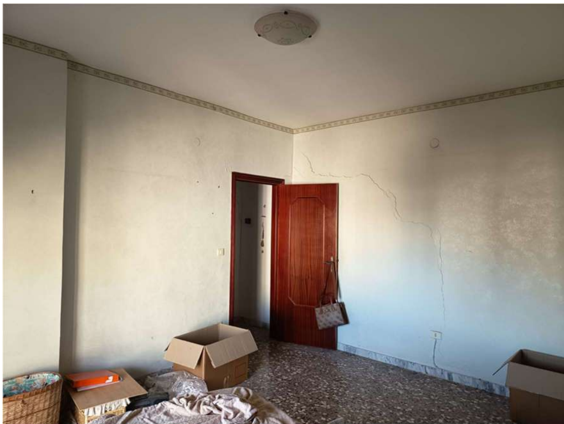
Foto n°18: Vista della camera da letto singola dell'appartamento oggetto di stima.
