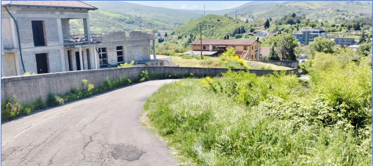
Strada di Accesso via della Genziana
