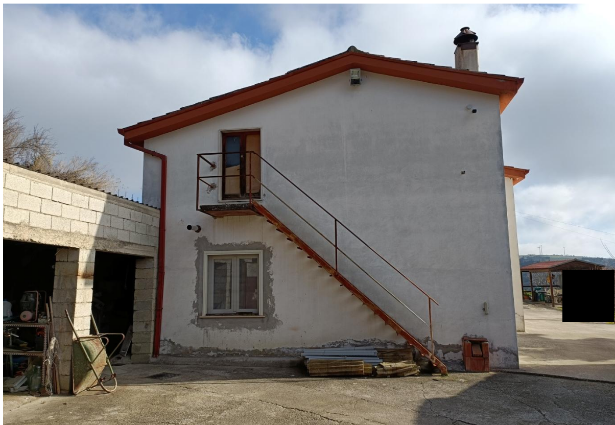
Figura 2 – Panoramica Abitazione in Via Donnadezio, n. 149, Potenza (PZ).
