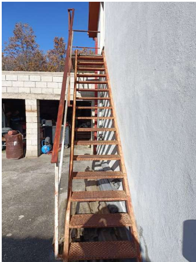
Figura 15 – Scala Accesso Piano Primo.
