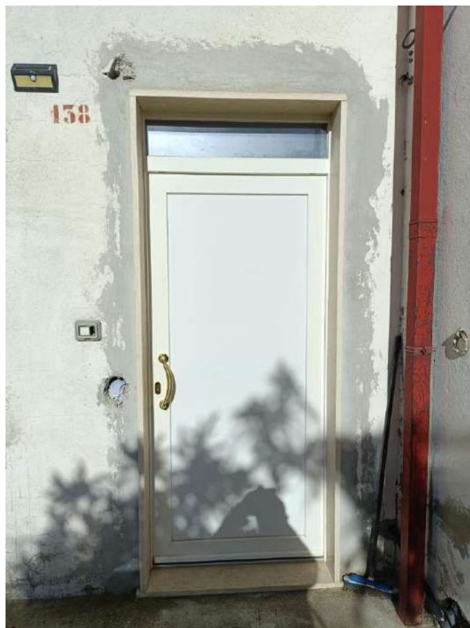
Figura 7 – Portone Ingresso Abitazione Piano Terra.
