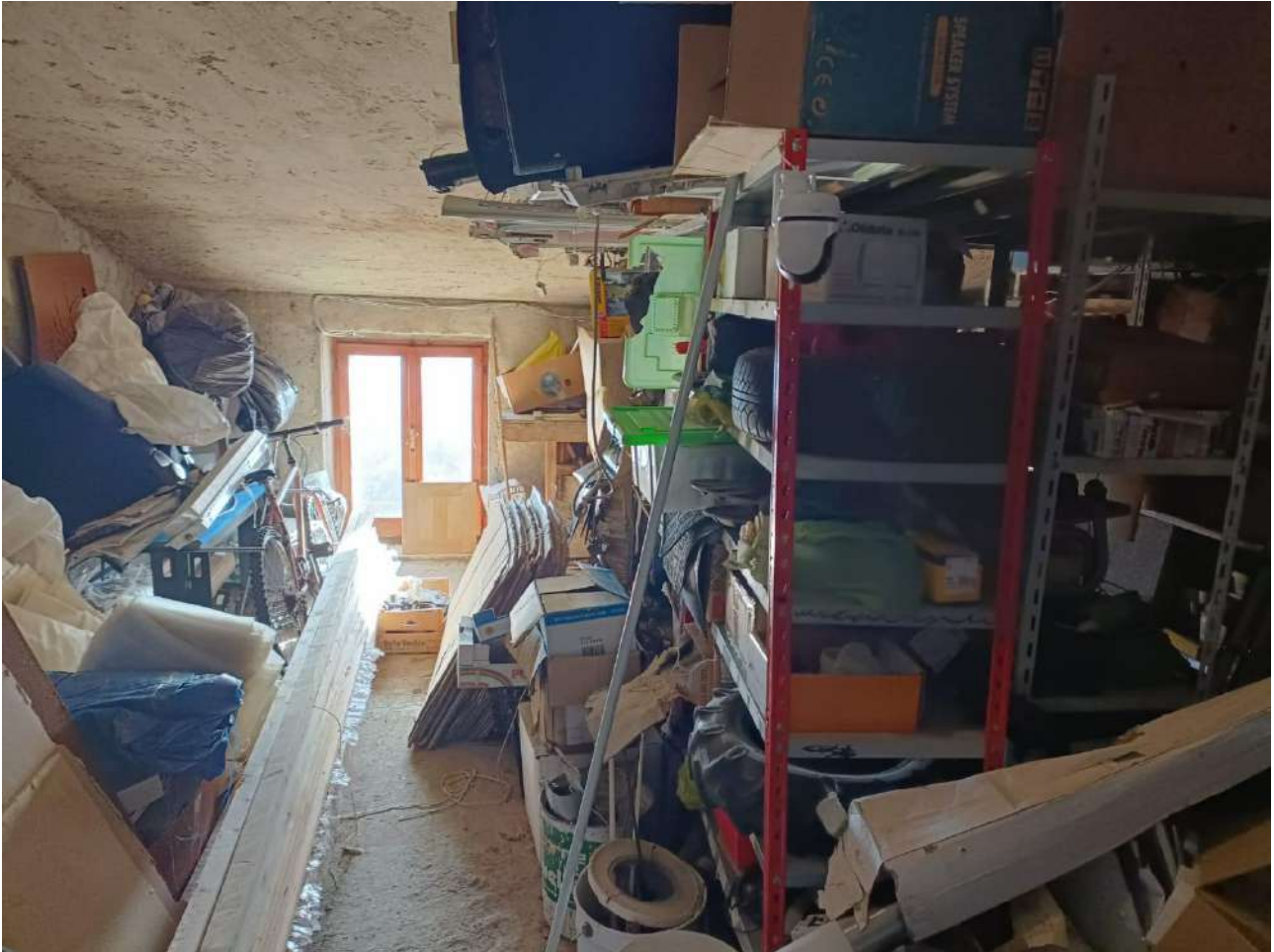
Figura 17 – Interno Deposito Piano Primo.
