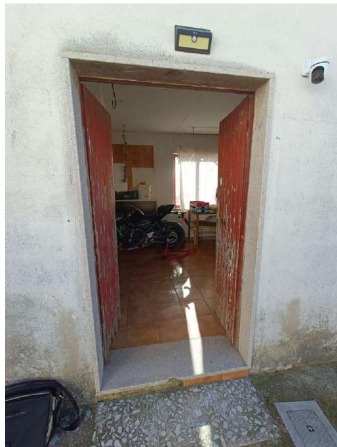
Figura 22 – Particolare Portone Accesso Deposito Piano Terra.
