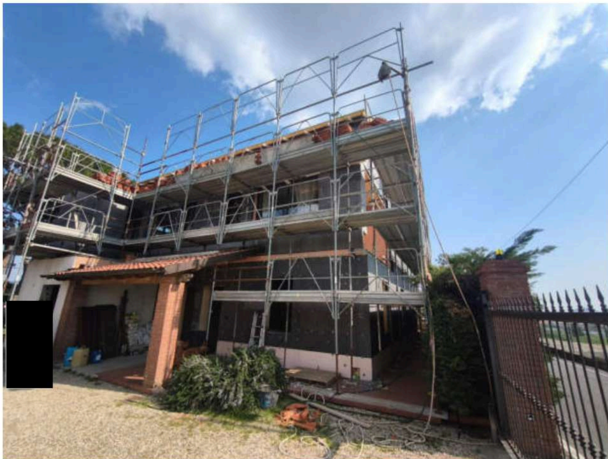
Fotografia 3: vista del fabbricato da nord-ovest
