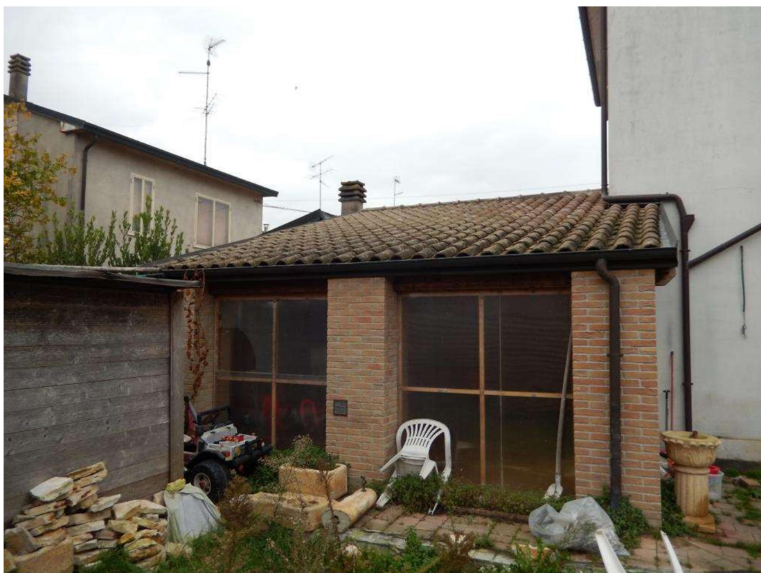
TETTOIA / PORTICATO O VERANDA
