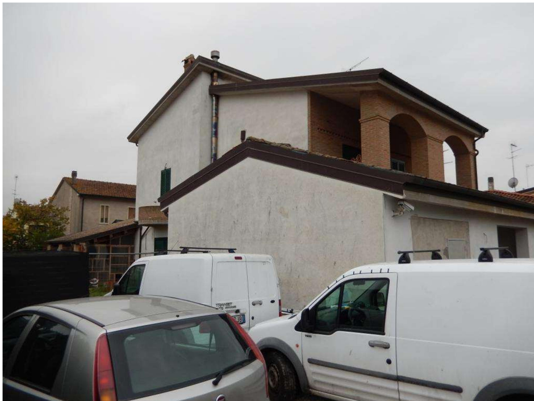
VISTA LATO EST E PARTICOLARE ZONA DI PERTINENZA DELLO STRADELLO COMUNALE (UTILIZZATO IMPROPRIAMENTE COME PARCHEGGIO...)
