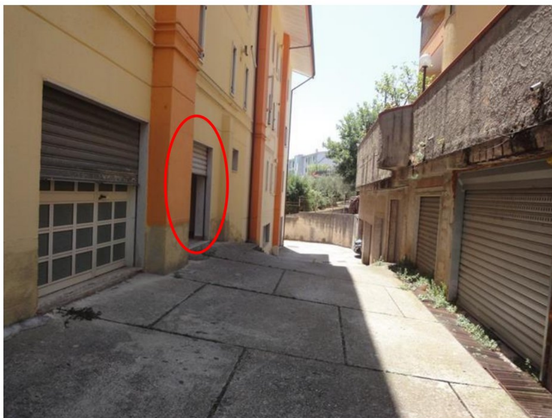
FOTO 64- LOTTO 4- ABITAZIONE in NCEU FL 16, P. LLA 299, SUB 36 PIANO SEMINTERRATO- ACCESSO AL LOCALE SEMINTERRATO DAL PROSPETTO OVEST DEL FABBRICATO B
