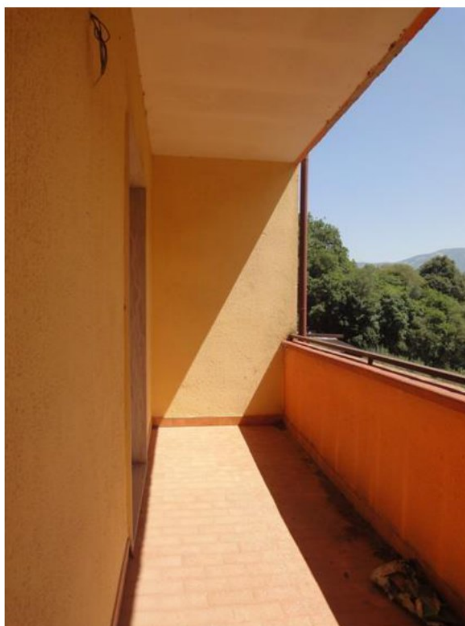
FOTO 23- LOTTO 1- ABITAZIONE in NCEU FL 16, P. LLA 299, SUB 4 PIANO PRIMO- BALCONE EST
