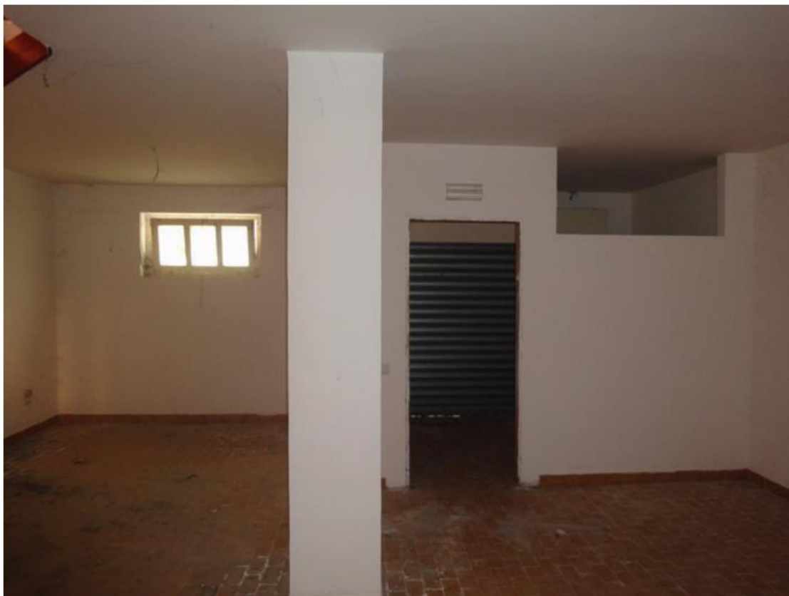
FOTO 8- LOTTO 1- ABITAZIONE in NCEU FL 16, P. LLA 299, SUB 4 PIANO SEMINTERRATO
