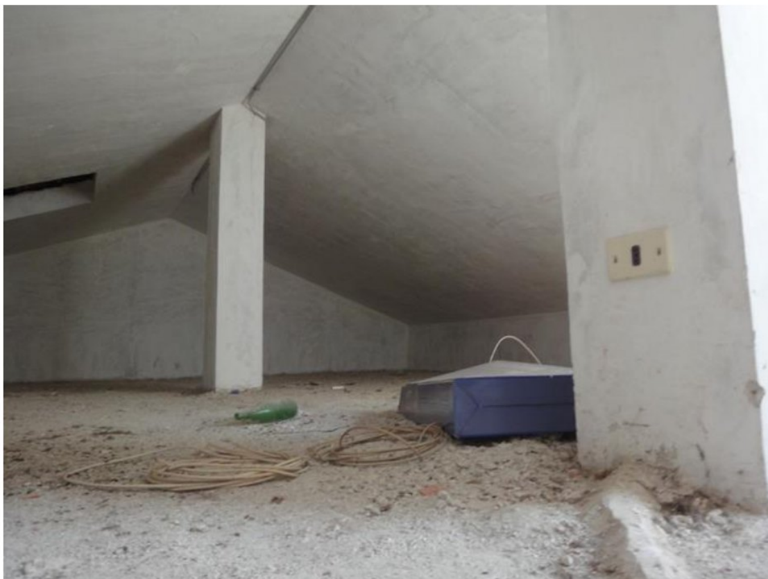
FOTO 39- LOTTO 2- ABITAZIONE in NCEU FL 16, P. LLA 299, SUB 8 PIANO TERZO- SOTTOTETTO GREZZO
