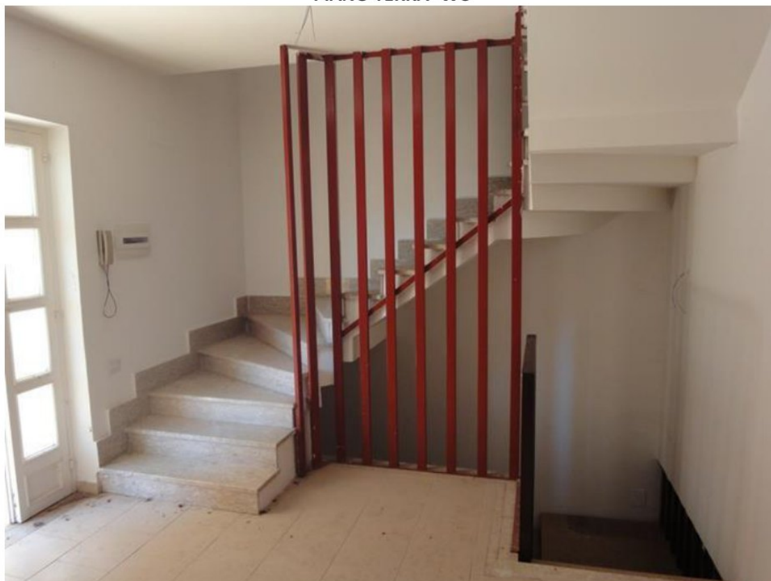
FOTO 17- LOTTO 1- ABITAZIONE in NCEU FL 16, P. LLA 299, SUB 4 PIANO TERRA- AREA INGRESSO SCALE DI COLLEGAMENTO PER IL PIANO PRIMO
