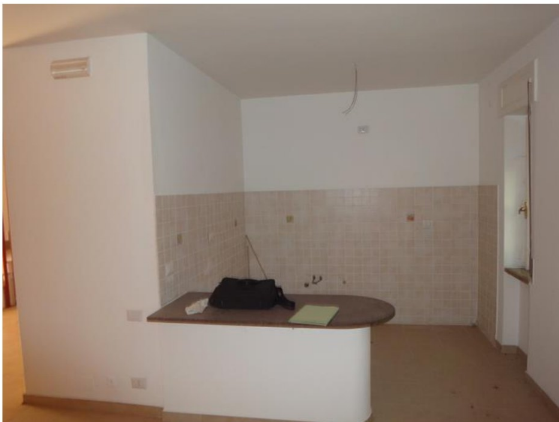
FOTO 15- LOTTO 1- ABITAZIONE in NCEU FL 16, P. LLA 299, SUB 4 PIANO TERRA- AREA CUCINA
