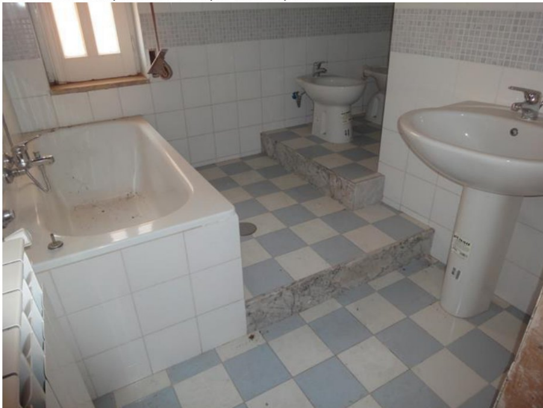
FOTO 22- LOTTO 1- ABITAZIONE in NCEU FL 16, P. LLA 299, SUB 4 PIANO PRIMO- WC
