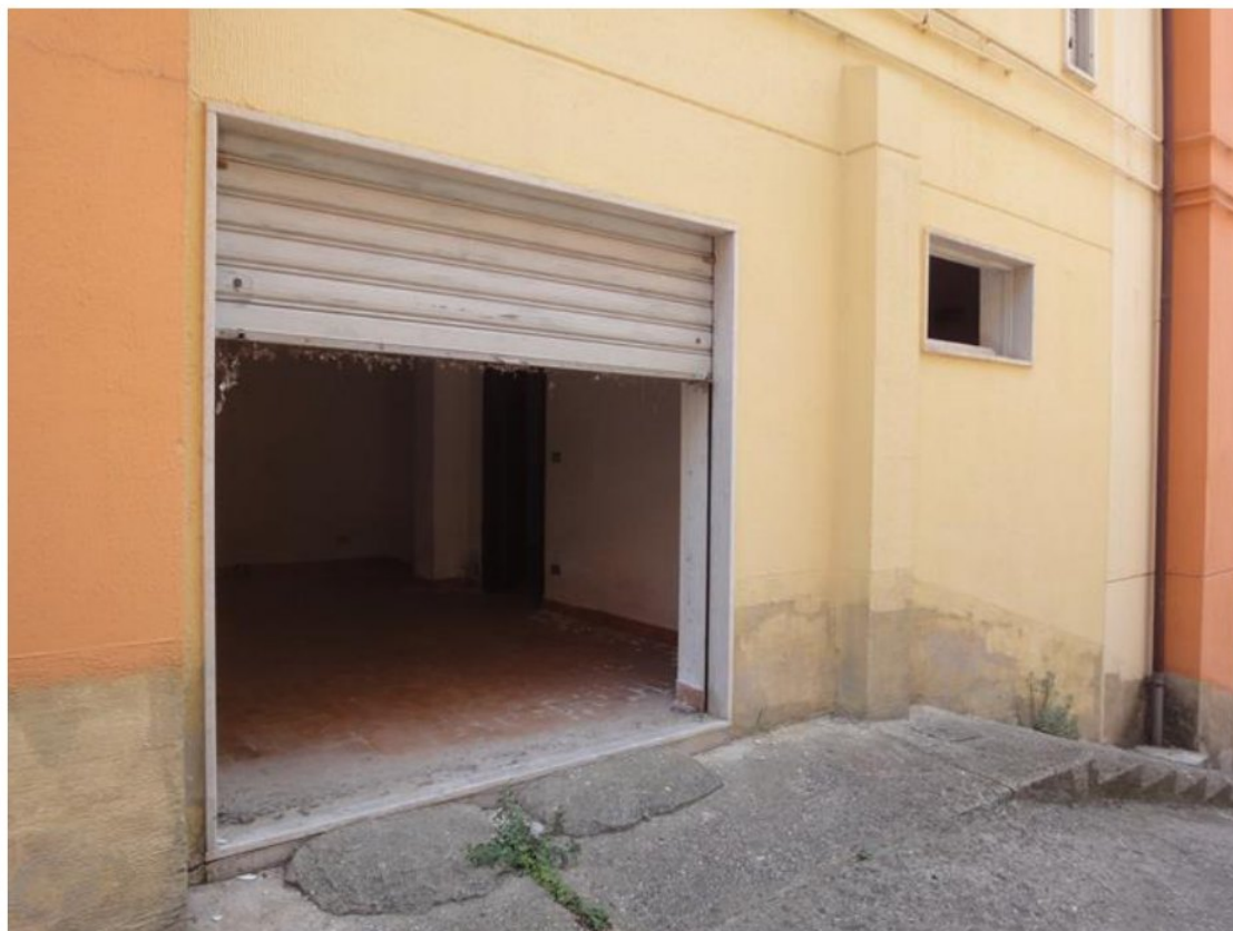
FOTO 65- LOTTO 4- ABITAZIONE in NCEU FL 16, P. LLA 299, SUB 36 PIANO SEMINTERRATO- ACCESSO AL LOCALE SEMINTERRATO
