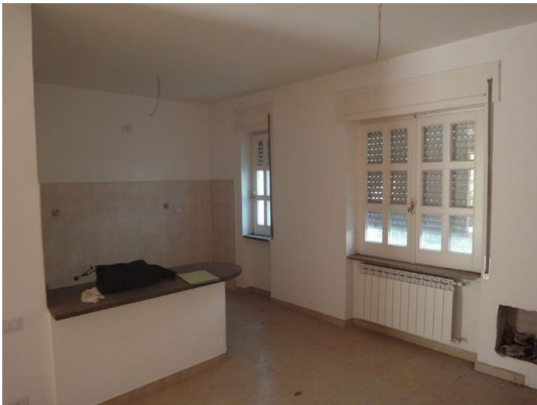
FOTO 14- LOTTO 1- ABITAZIONE in NCEU FL 16, P. LLA 299, SUB 4 PIANO TERRA- AREA INGRESSO/CUCINA
