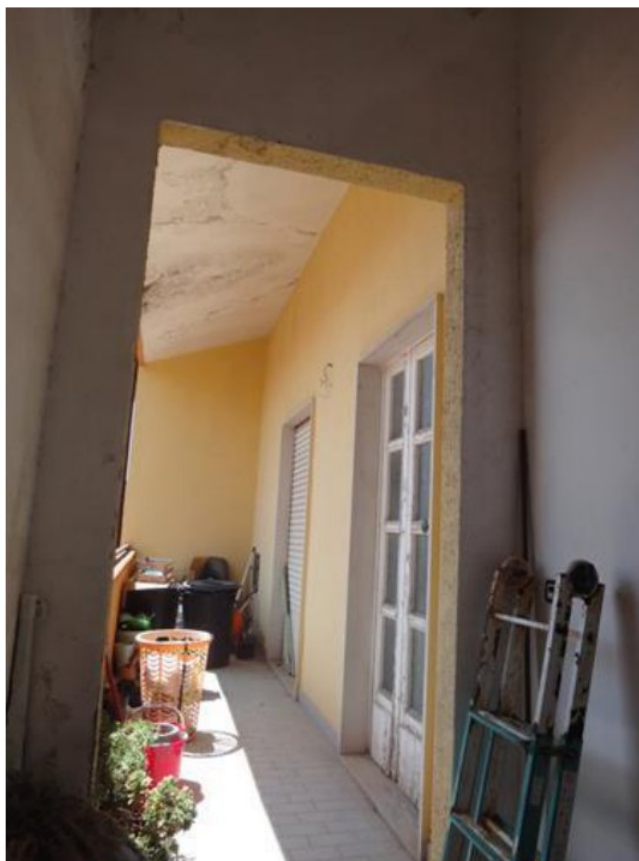
FOTO 25- LOTTO 2- ABITAZIONE in NCEU FL 16, P. LLA 299, SUB 8 PIANO TERZO- INGRESSO ALL'ABITAZIONE DAL BALLATOIO EST
