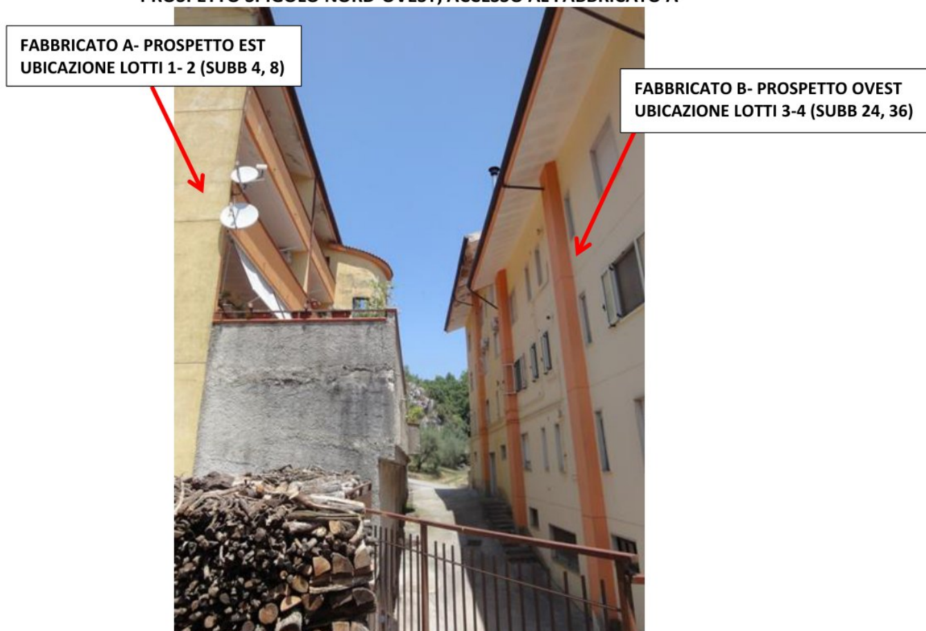
FOTO 2- INDIVIDUAZIONI FABBRICATI A e B DI UBICAZIONE DEI LOTTI ESECUTATI PROSPETTO SPIGOLO NORD-OVEST
