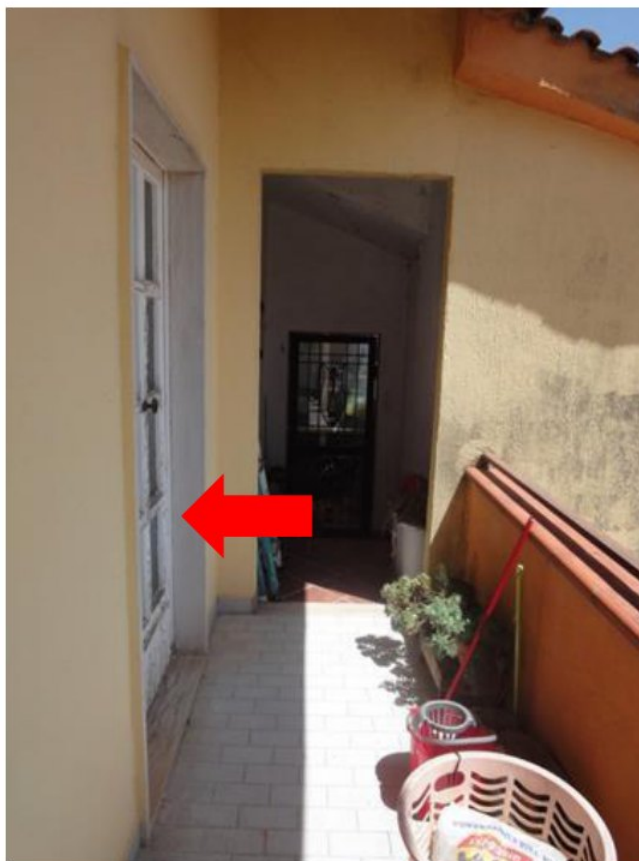
FOTO 24- LOTTO 2- ABITAZIONE in NCEU FL 16, P. LLA 299, SUB 8 PIANO TERZO- INGRESSO ALL'ABITAZIONE DAL BALLATOIO EST
