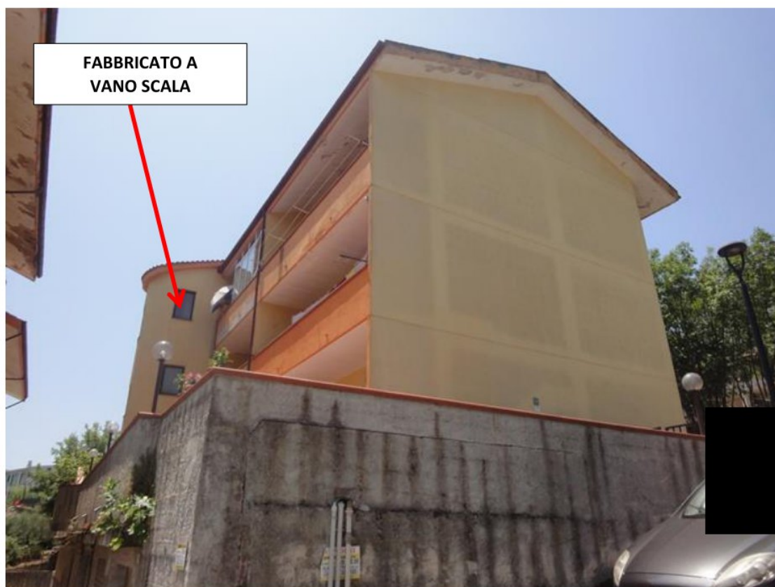
FOTO 4- FABBRICATO A DI UBICAZIONE DEI LOTTI 1-2 (SUBB 4, 8) PROSPETTO RETROSTANTE EST
