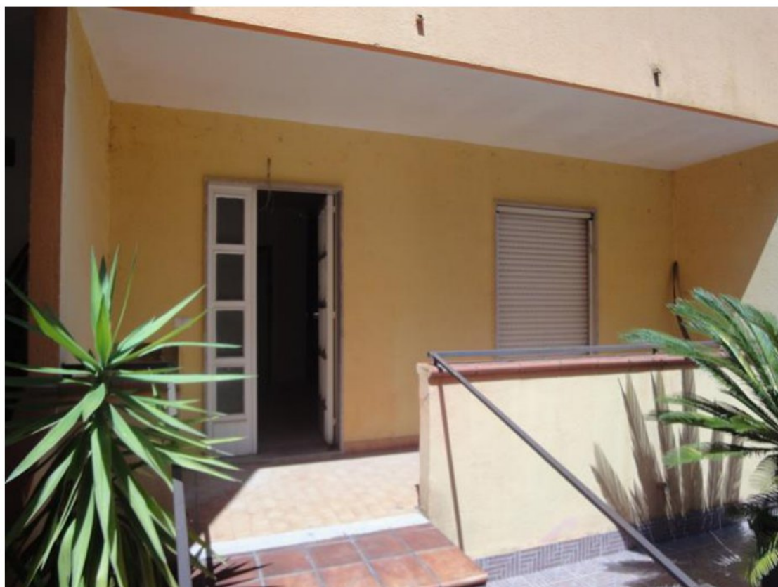
FOTO 11- LOTTO 1- ABITAZIONE in NCEU FL 16, P. LLA 299, SUB 4 BALCONE D'INGRESSO AL PIANO TERRA
