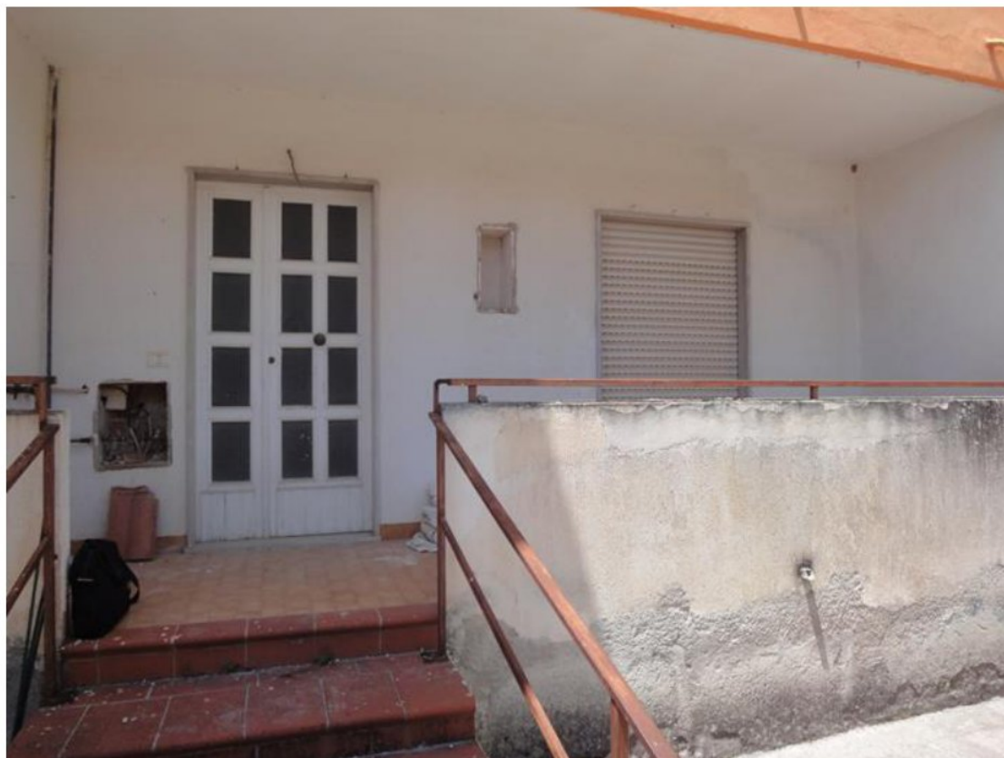
FOTO 55- LOTTO 4- ABITAZIONE in NCEU FL 16, P. LLA 299, SUB 36 PIANO TERRA- ACCESSO AL PIANO TERRA DAL PROSPETTO EST
