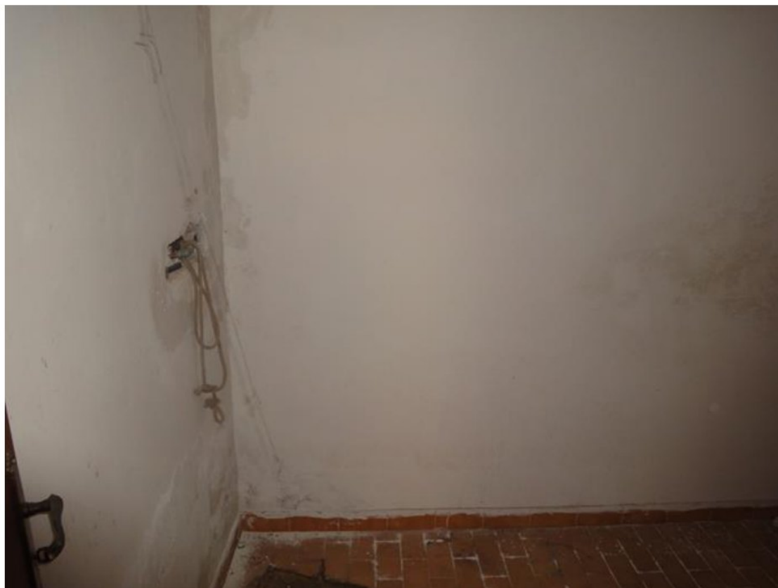
FOTO 68- LOTTO 4- ABITAZIONE in NCEU FL 16, P. LLA 299, SUB 36 PIANO SEMINTERRATO- RIPOSTIGLIO
