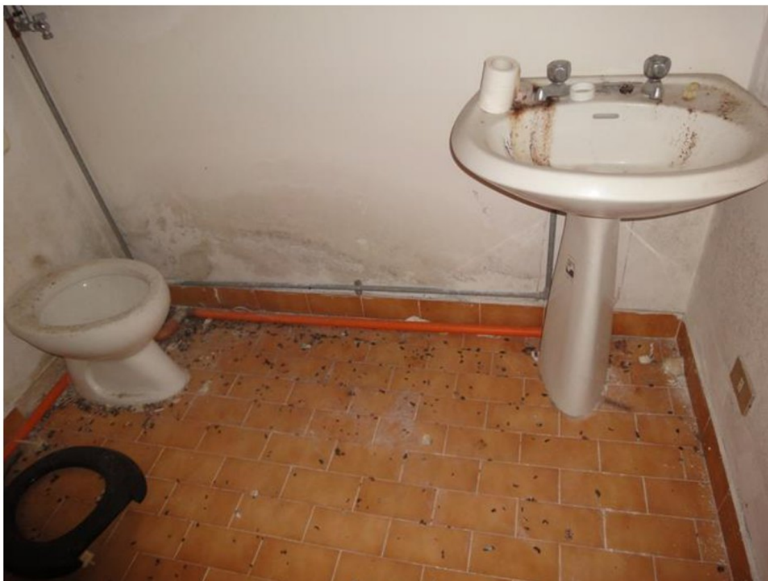
FOTO 69- LOTTO 4- ABITAZIONE in NCEU FL 16, P. LLA 299, SUB 36 PIANO SEMINTERRATO- WC
