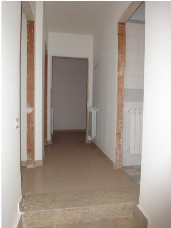
FOTO 18- LOTTO 1- ABITAZIONE in NCEU FL 16, P. LLA 299, SUB 4 PIANO PRIMO- DISIMPEGNO
