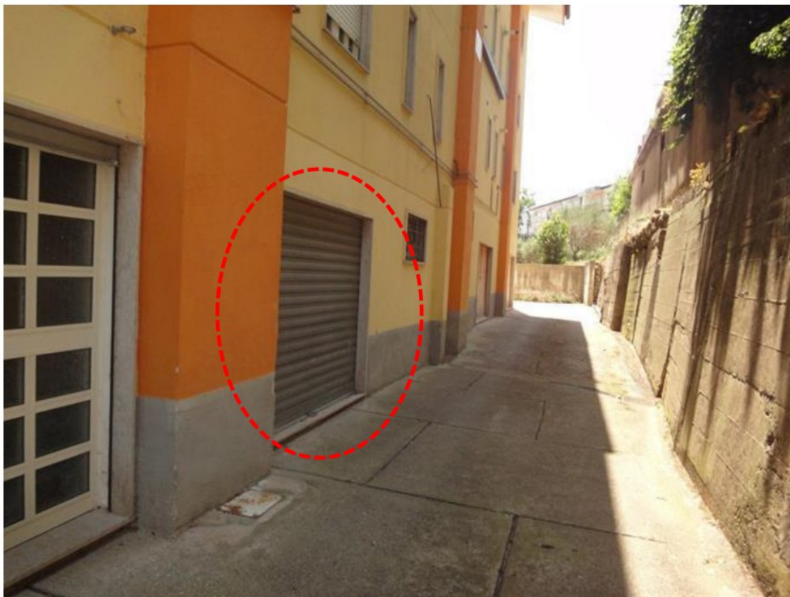
FOTO 6- LOTTO 1- ABITAZIONE in NCEU FL 16, P. LLA 299, SUB 4 ACCESSO AL PIANO SEMINTERRATO DAL PROSPETTO OVEST
