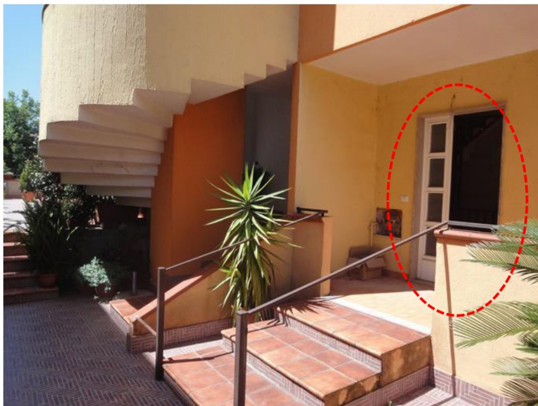
FOTO 10- LOTTO 1- ABITAZIONE in NCEU FL 16, P. LLA 299, SUB 4 ACCESSO AL PIANO TERRA DAL PROSPETTO EST
