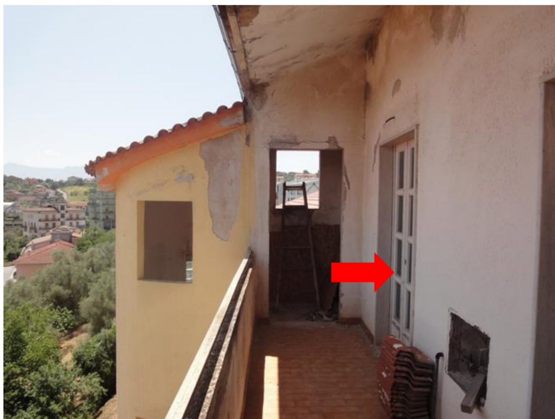
FOTO 41- LOTTO 3- ABITAZIONE in NCEU FL 16, P. LLA 299, SUB 24 PIANO TERZO- BALLATOIO EST DI INGRESSO
