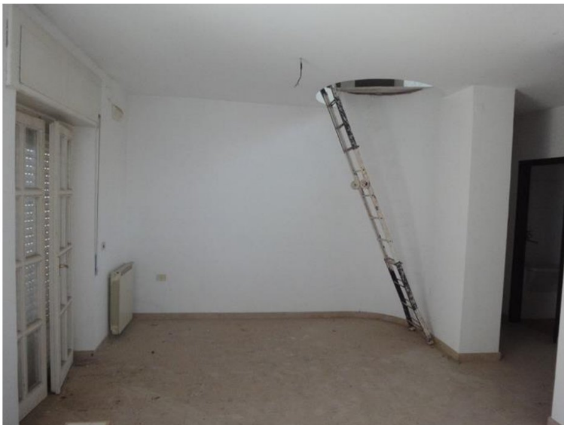
FOTO 27- LOTTO 2- ABITAZIONE in NCEU FL 16, P. LLA 299, SUB 8 PIANO TERZO- AREA INGRESSO / SOGGIORNO- FORO DI ACCESSO AL LOCALE SOTTOTETTO
