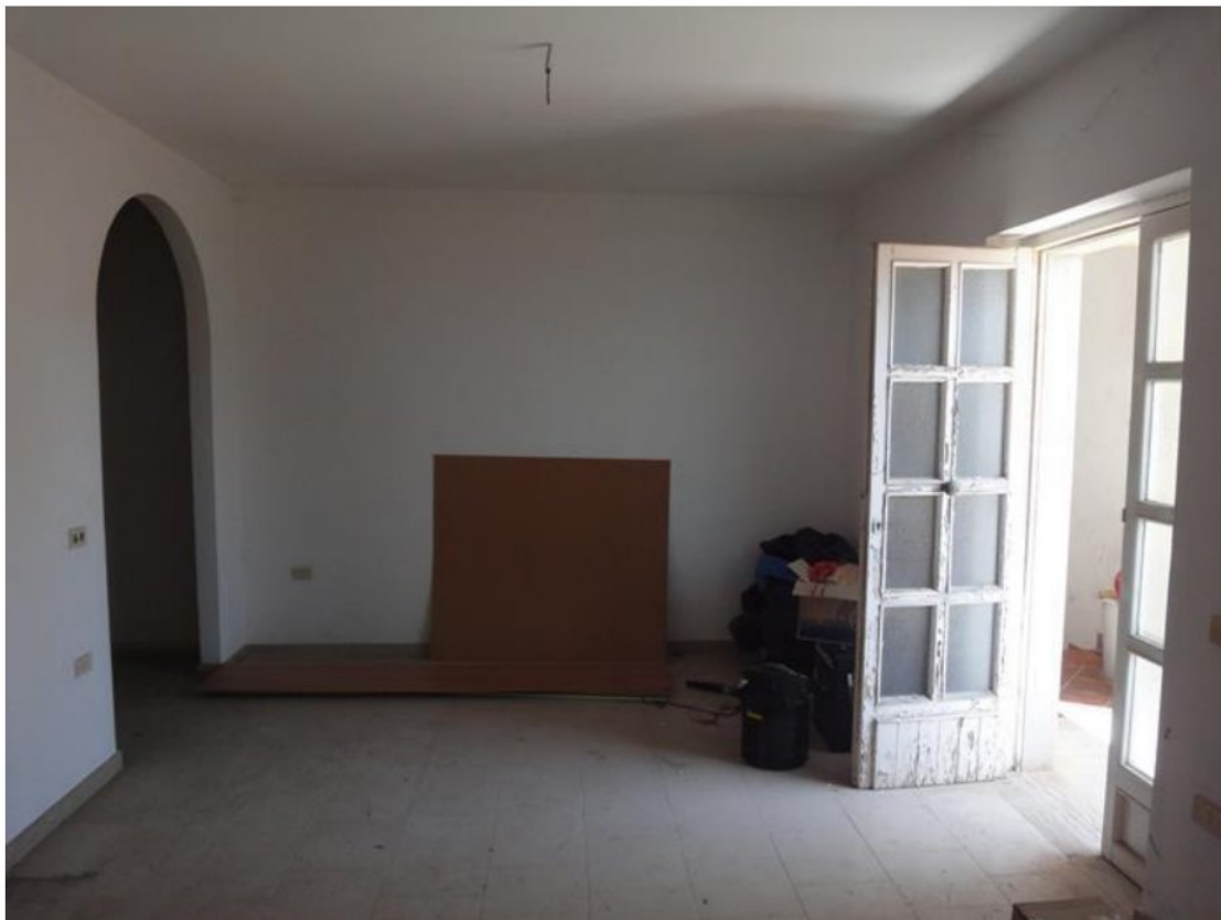
FOTO 26- LOTTO 2- ABITAZIONE in NCEU FL 16, P. LLA 299, SUB 8 PIANO TERZO- AREA INGRESSO / SOGGIORNO
