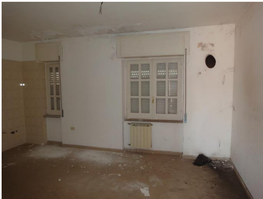
FOTO 28- LOTTO 2- ABITAZIONE in NCEU FL 16, P. LLA 299, SUB 8 PIANO TERZO- CUCINA
