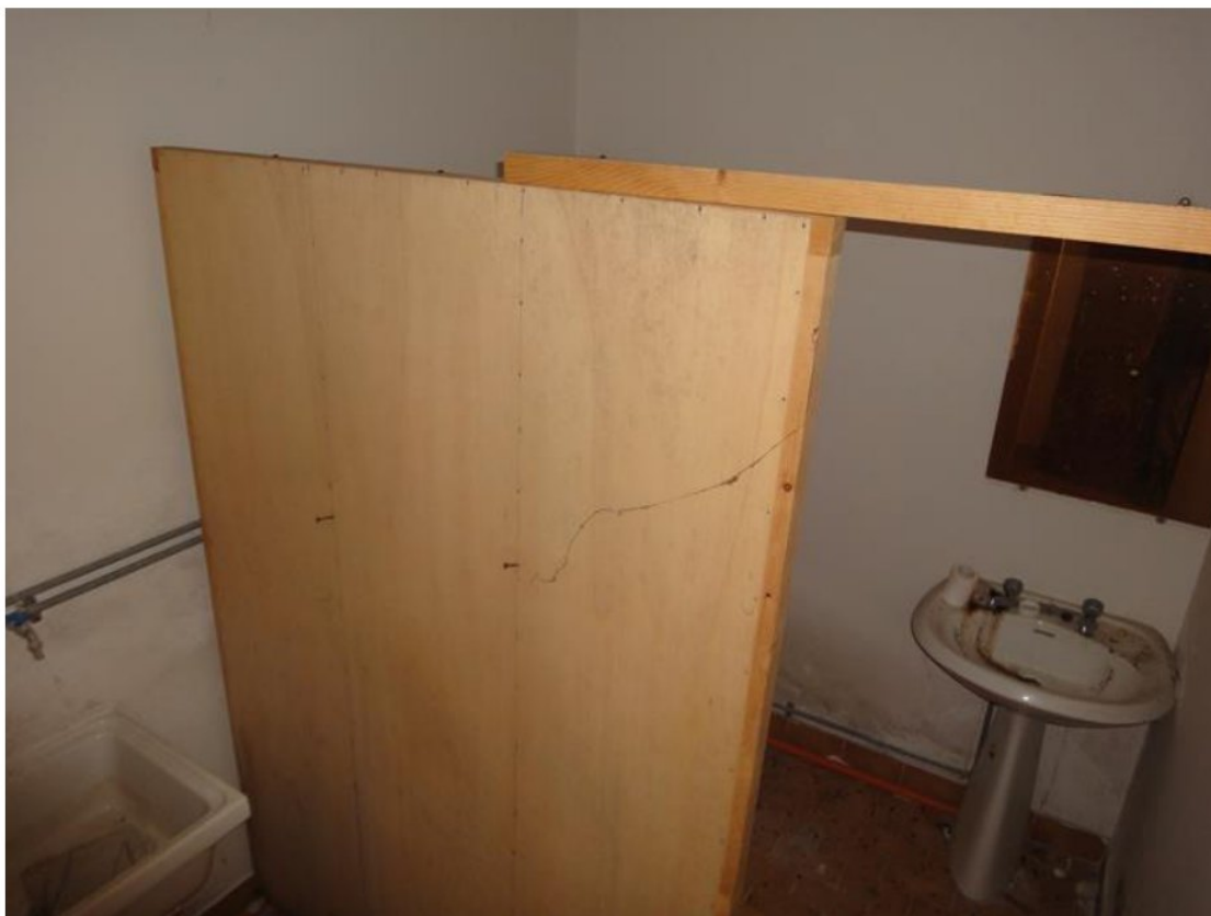
FOTO 70- LOTTO 4- ABITAZIONE in NCEU FL 16, P. LLA 299, SUB 36 PIANO SEMINTERRATO- WC
