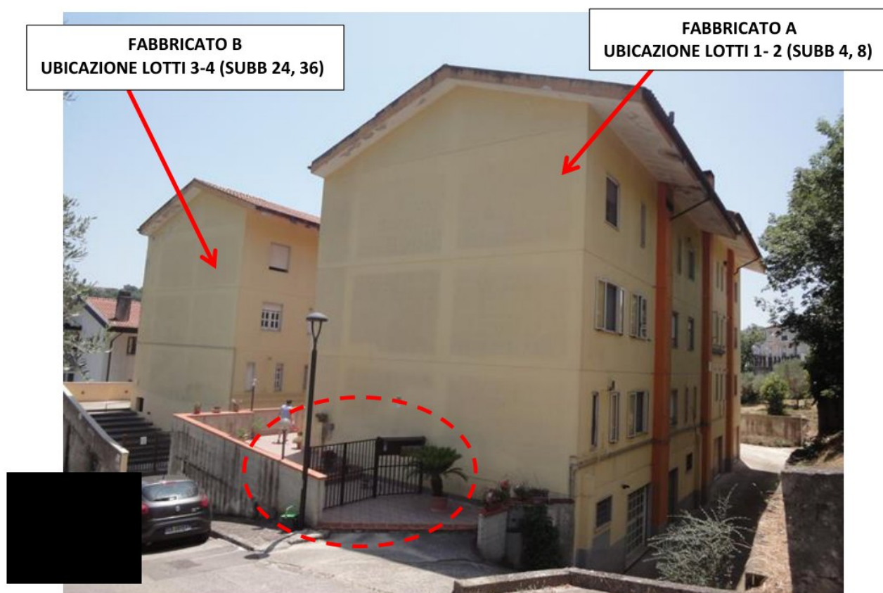
FOTO 1- INDIVIDUAZIONI FABBRICATI A e B DI UBICAZIONE DEI LOTTI ESECUTATI PROSPETTO SPIGOLO NORD-OVEST, ACCESSO AL FABBRICATO A
