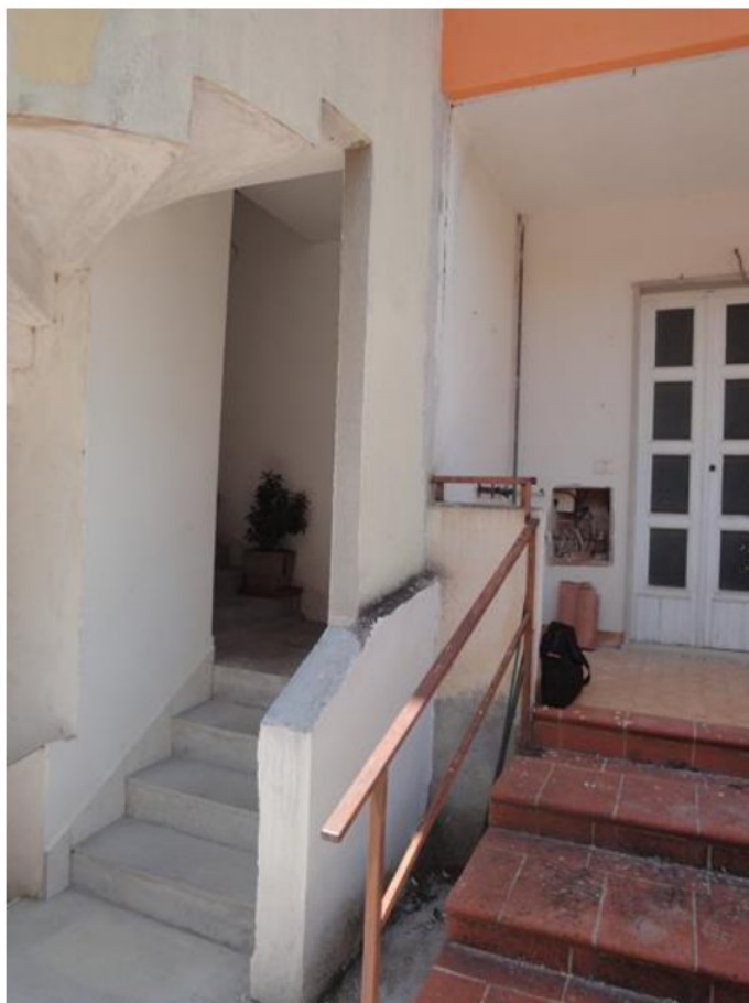
FOTO 40- LOTTO 3- ABITAZIONE in NCEU FL 16, P. LLA 299, SUB 24 ACCESSO DAL VANO SCALA SUL PROSPETTO EST DEL FABBRICATO B
