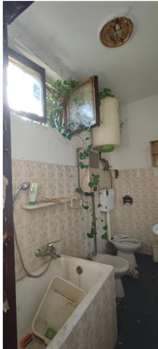
vista interna bagno P1
