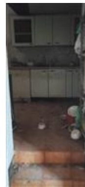
vista interna cucina PT
