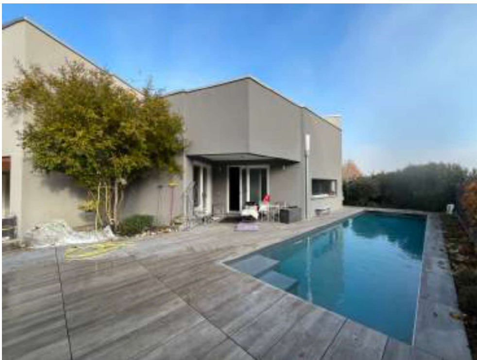
Foto 8 : Prospetto a sudest con piscina
