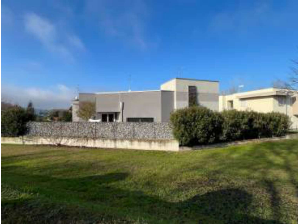
Foto 5 : Facciata a sud - sudest
