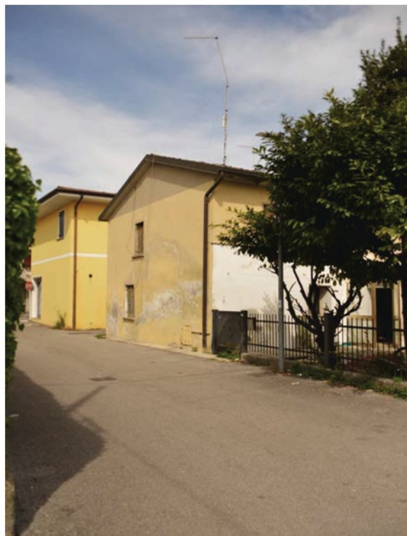
Foto n. 7 - Fronte sud - Via San Martino
