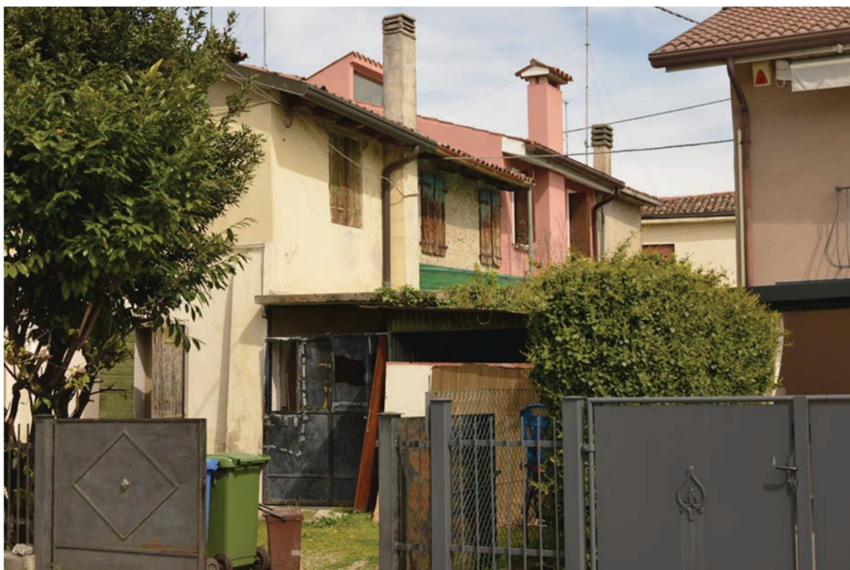
Foto n. 8 - Via San Martino ingresso carraio abitazione
