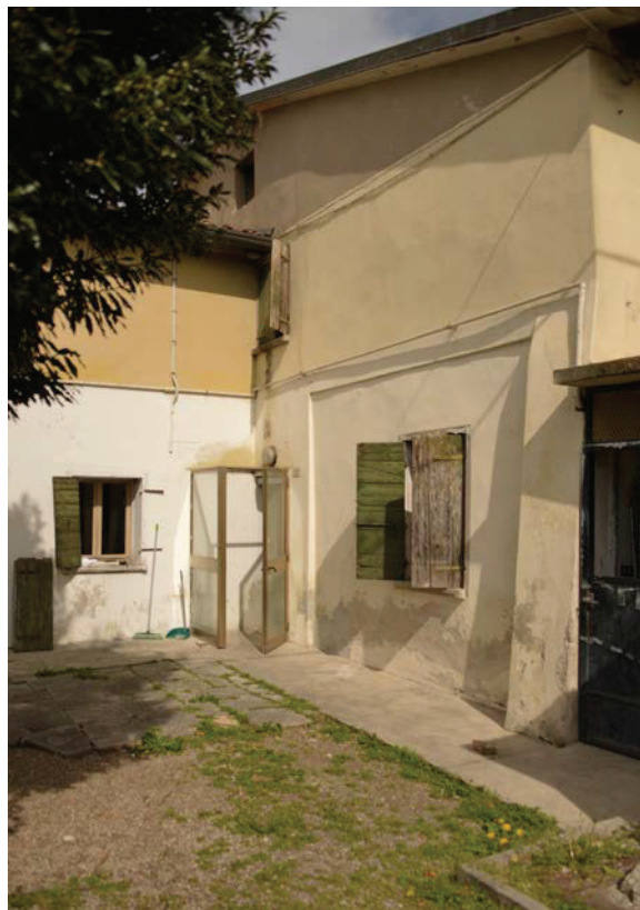
Foto n. 26 – Ingresso sud abitazione
