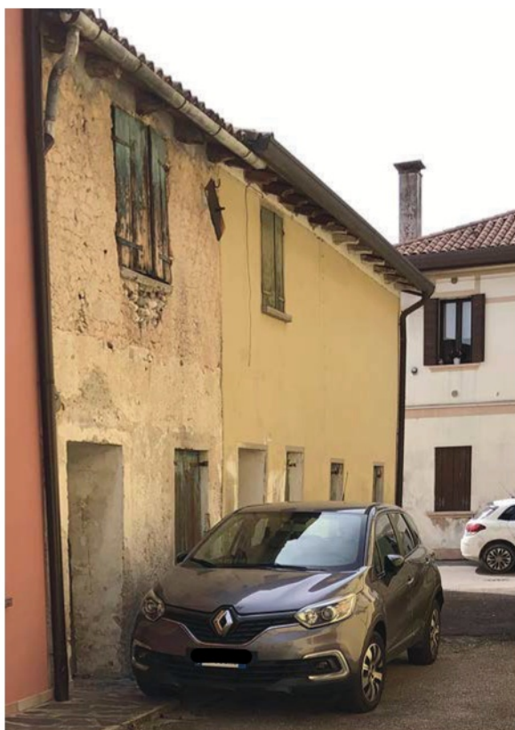
Foto n. 10 - Fronte Ovest abitazione
