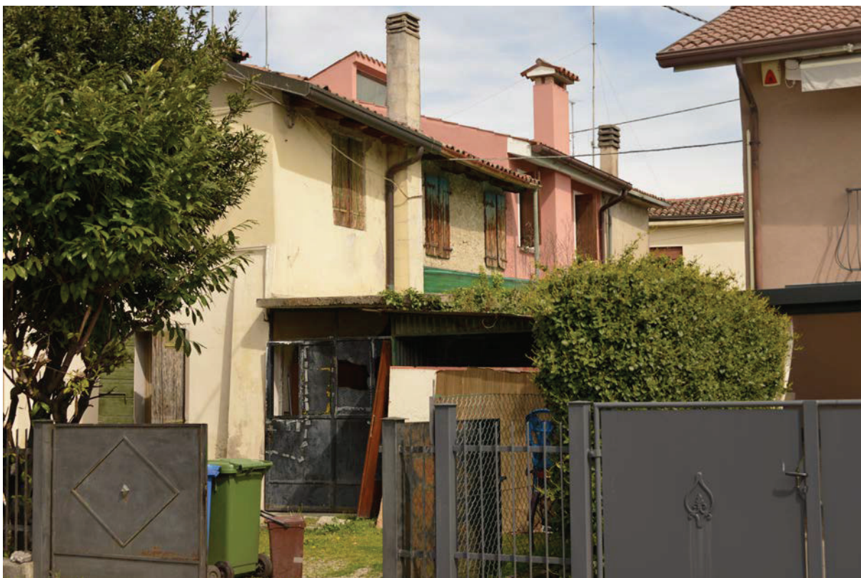
Foto n. 19 – Fronte Sud accesso carraio
