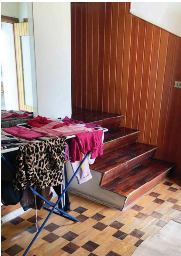
Foto n. 29 - 30 – Vano ingresso P.T.
