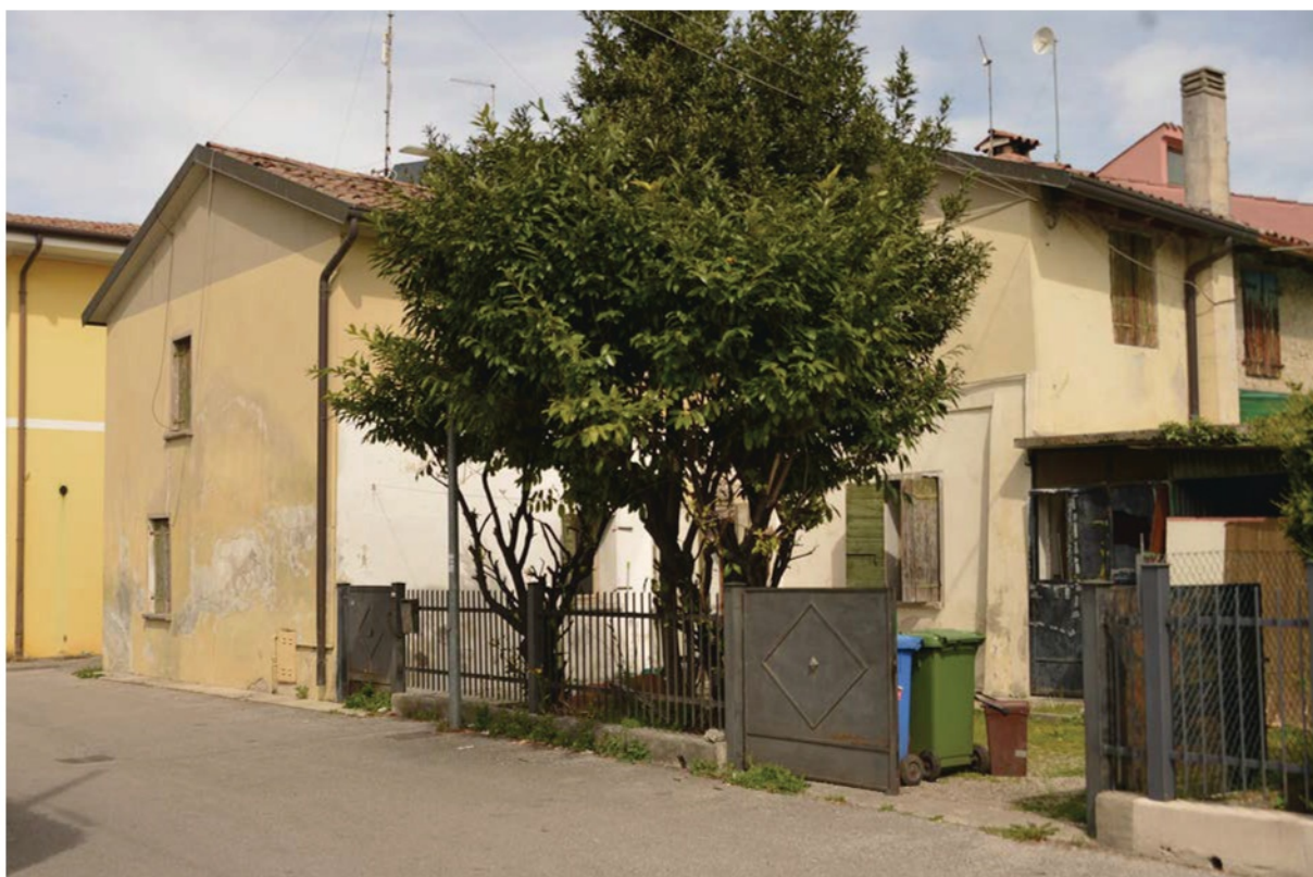
Foto n. 5 - Via San Martino - Fronte sud-est
