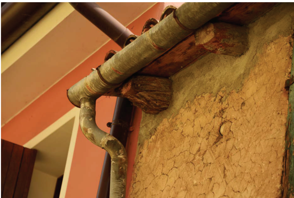
Foto n. 15 – Particolare colmo e grondaia
