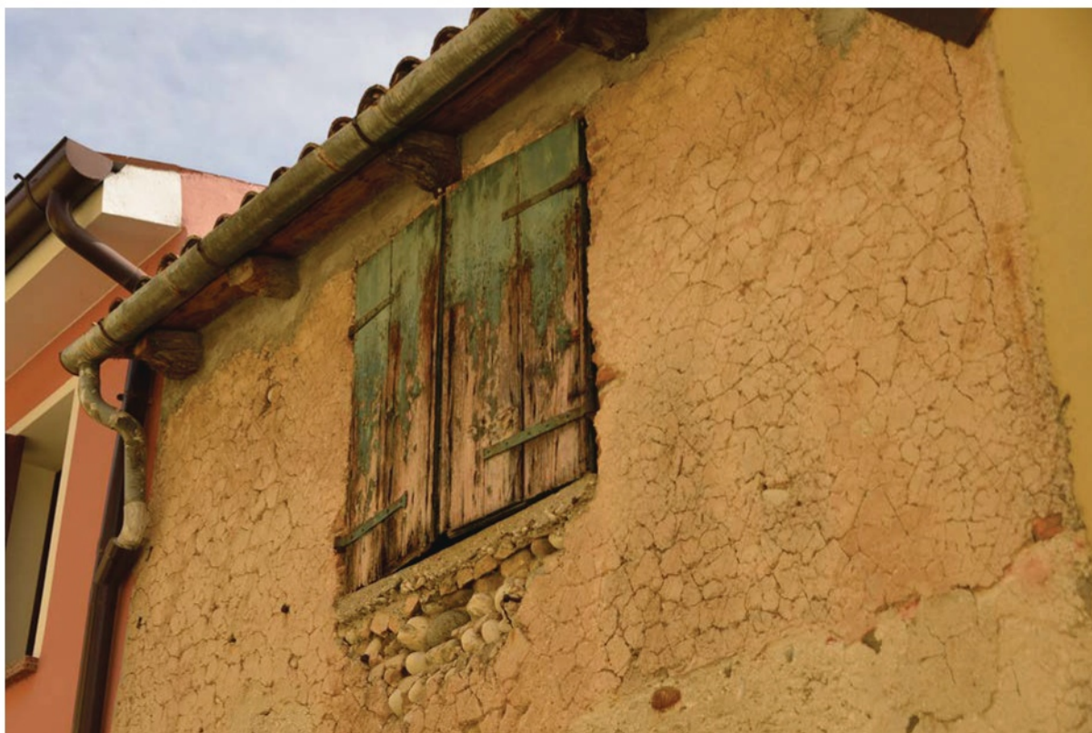
Foto n. 12 – Fronte ovest particolare costruttivo in ciottoli di fiumi e pietra
