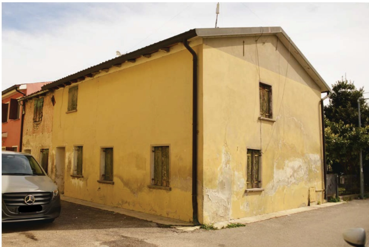
Foto n. 1 – Fronte sud-ovest Fabbricato su Via San Martino- Vicolo San Martino
