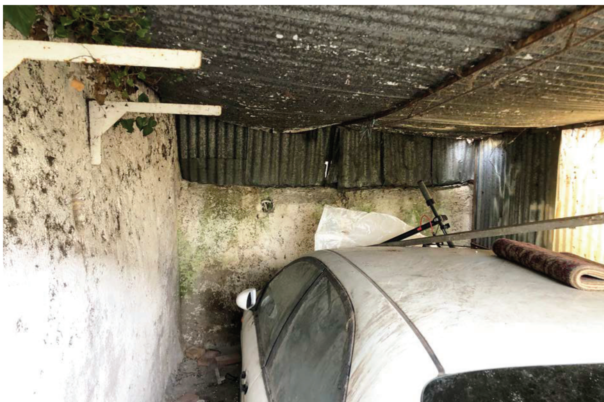
Foto n. 56 – Garage sub 2 - Particolare copertura
