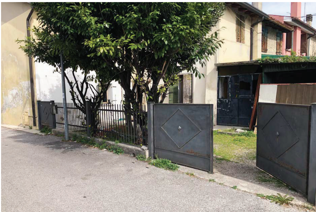
Foto n. 23– Fronte Sud Est su via San Martino - Accesso carraio
