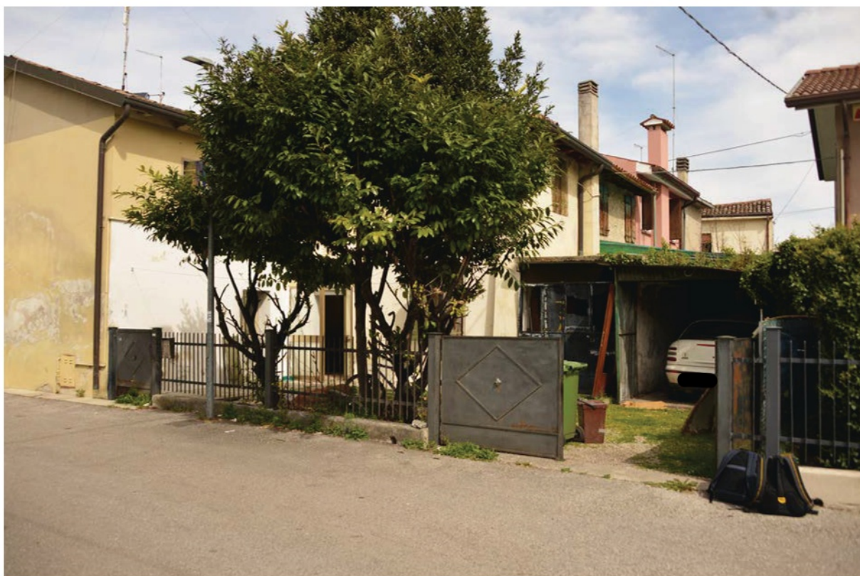
Foto n. 18 - Accesso pedonale e carraio da Via San Martino
