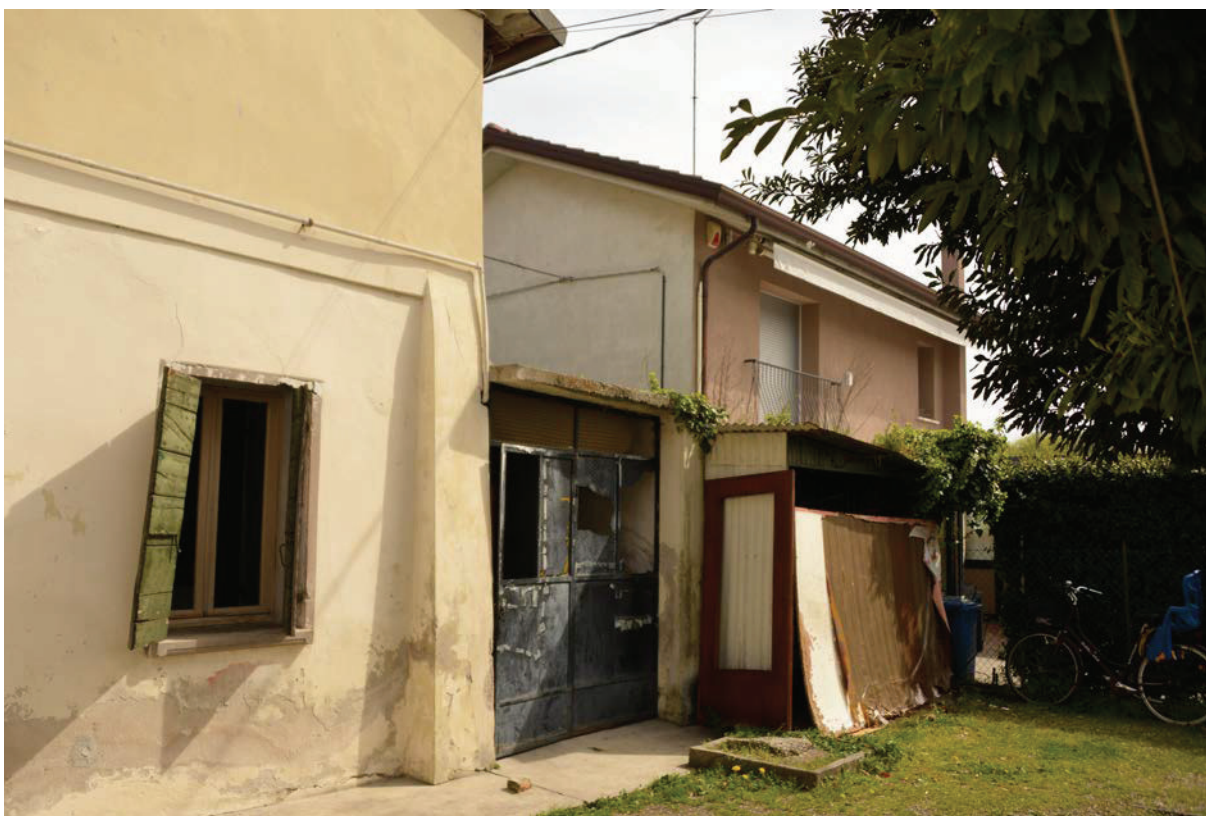
Foto n. 20 – Corte interna sub 1
