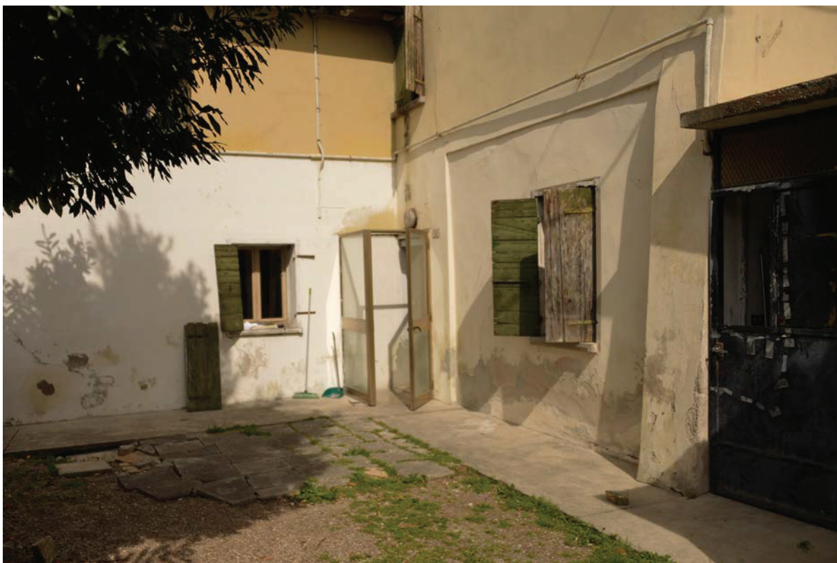
Foto n. 21 – Corte interna sub 1
