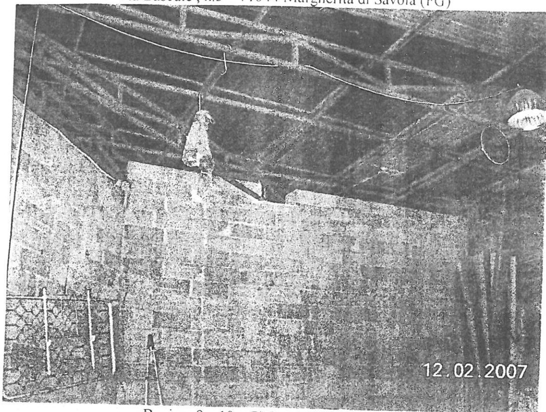
- Beni nn.9 e 10 – 7° Lotto - Vista interna -
