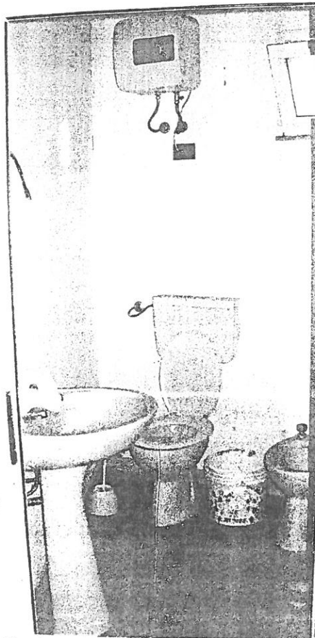
- Beni nn.9 e 10 - 7° Lotto - Vista interna -
