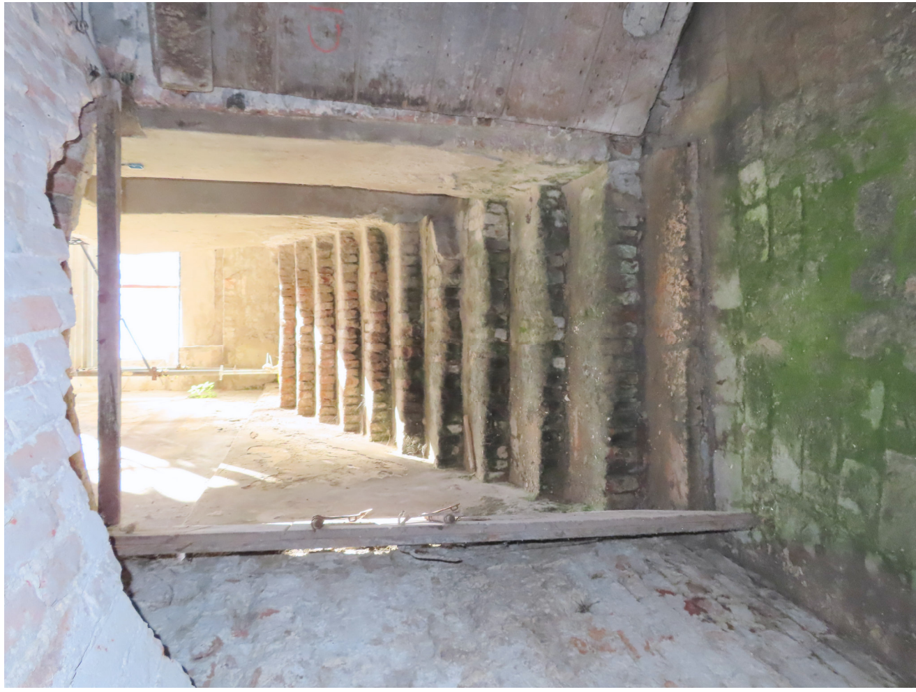
SCALA ACCESSO AL PIANO INTERRATO
