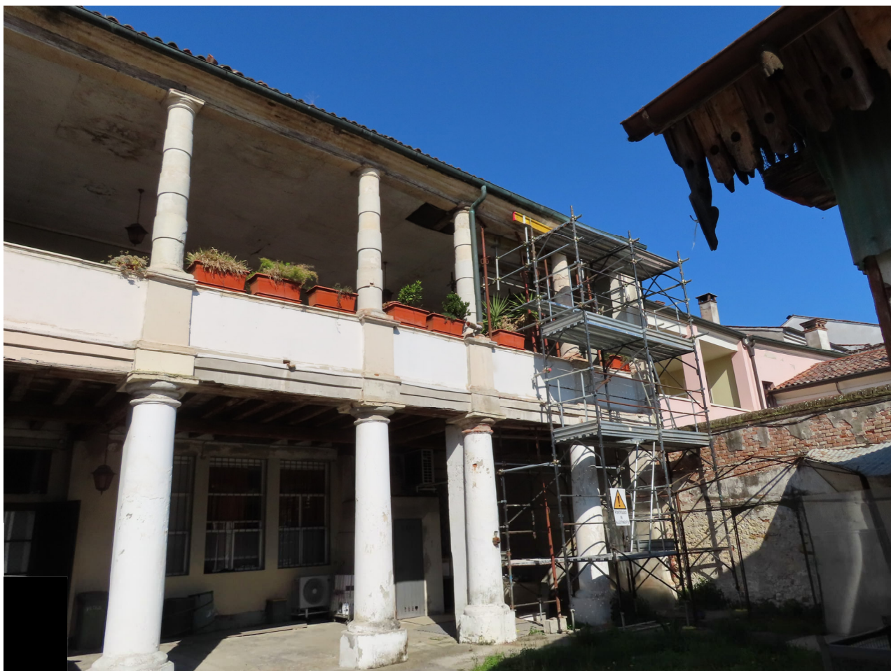
PARTICOLARE TETTO PUNTELLATO
