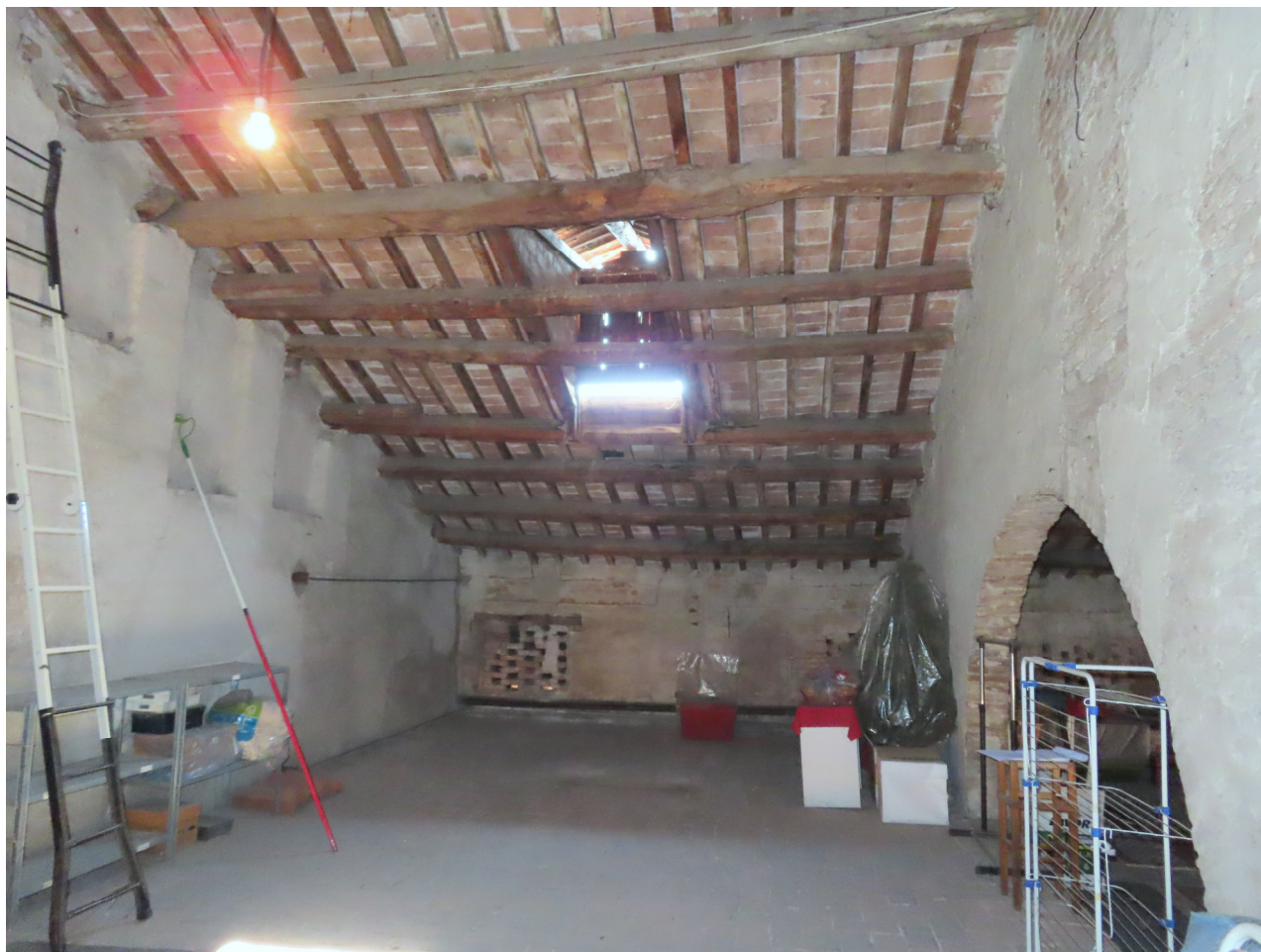
SOFFITTA 2 CON ABBAINO
