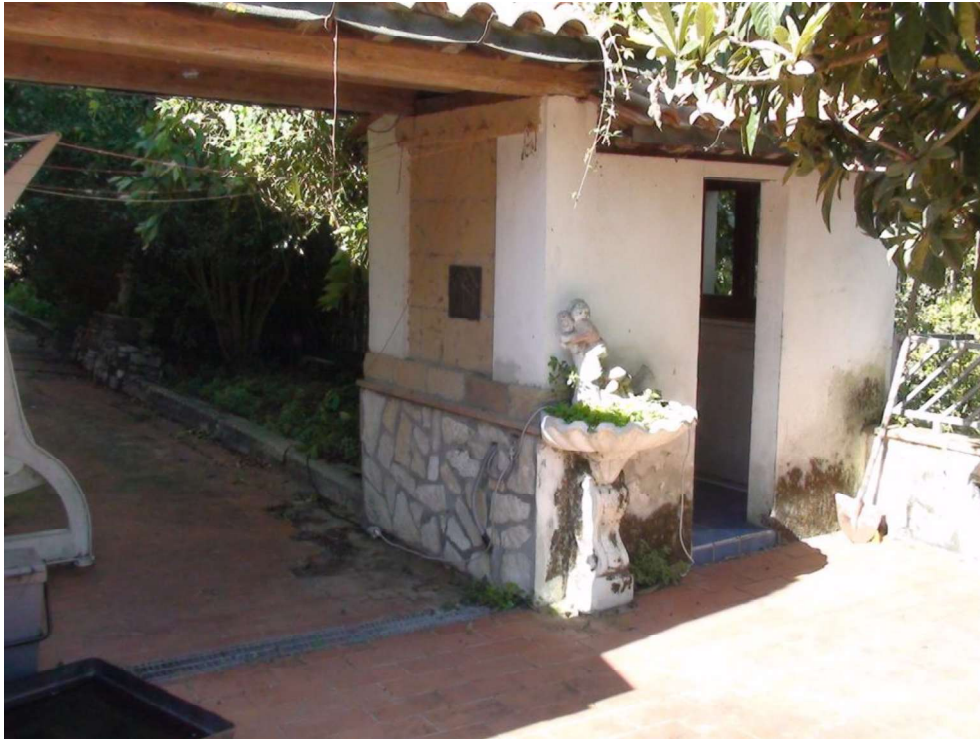
Figura 15 tettoia e locale lavanderia
