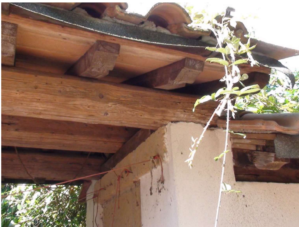
Figura 7 dettaglio della tettoia
