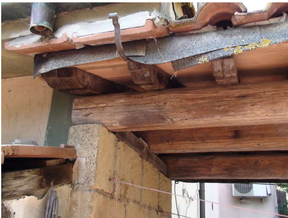
Figura 8 dettaglio della tettoia
