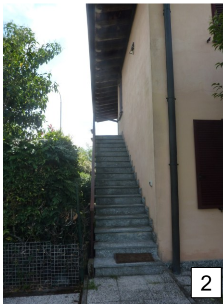
Scala esterna di accesso
