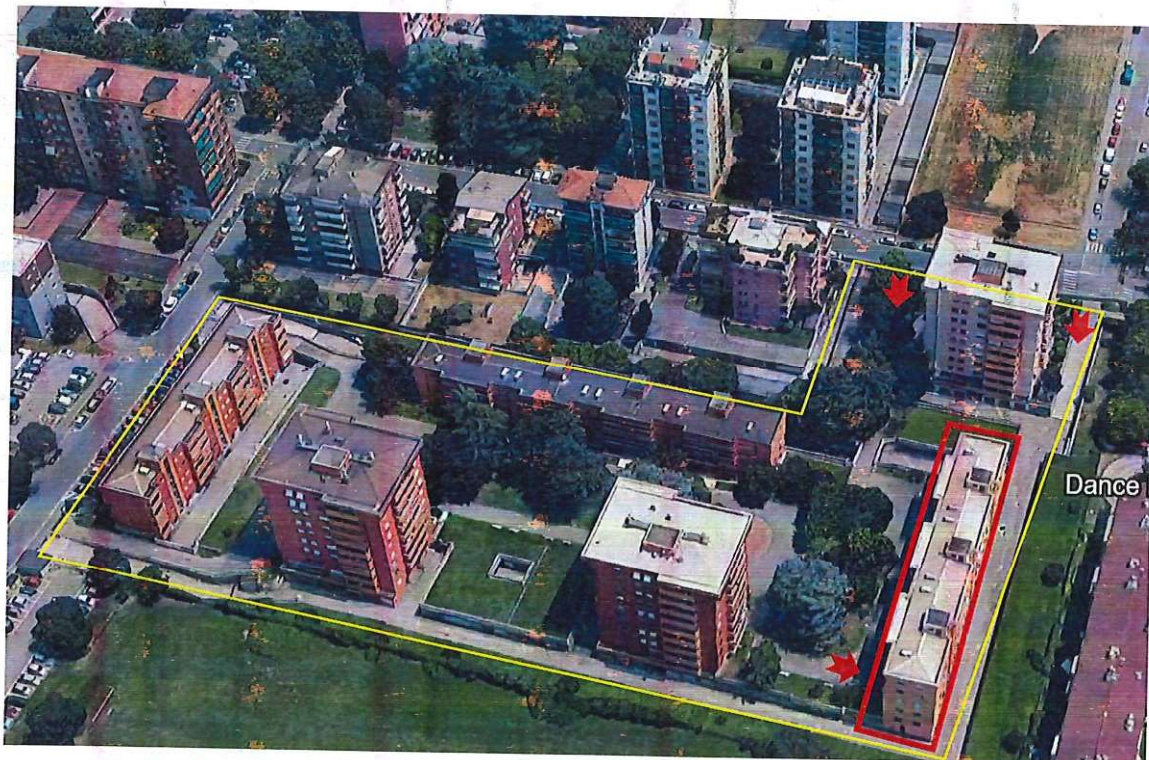
Mappa satellite: individuazione complesso residenziale e fabbricato
