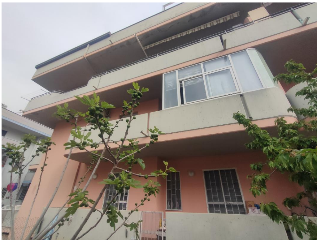
Vista posteriore fronte sud
