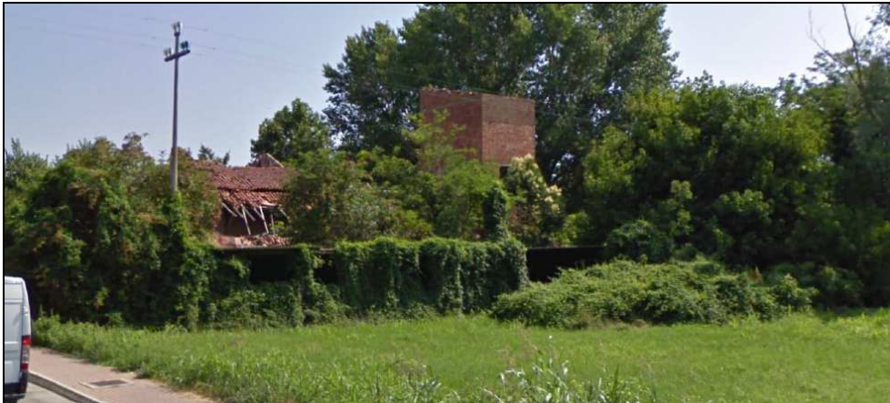
Figura 5 – edificio collabente prima della recinzione dell'area
