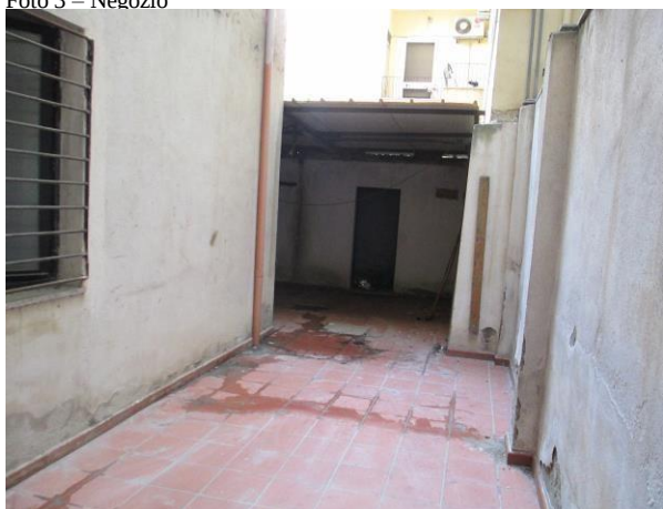
Foto 5 – Cortile e ripostiglio esterno
